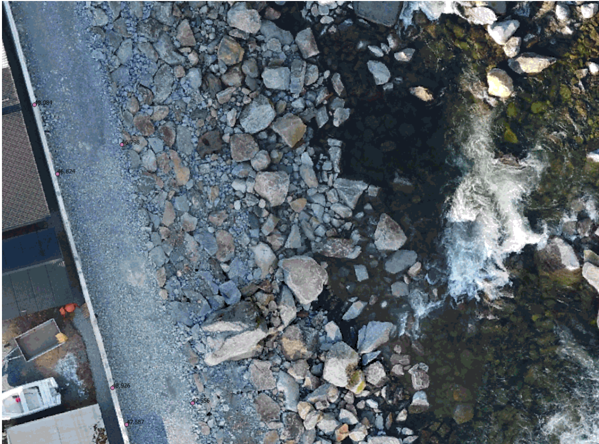
Figur 13 Detalj av erosjonssikring
