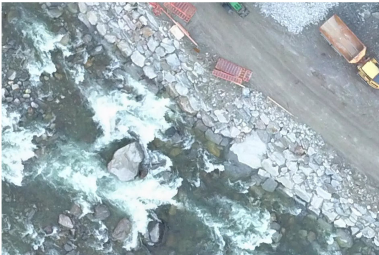
Figur 15 Detalj av erosjonssikring
