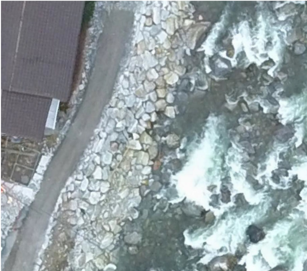
Figur 21 Detalj av erosjonssikring
