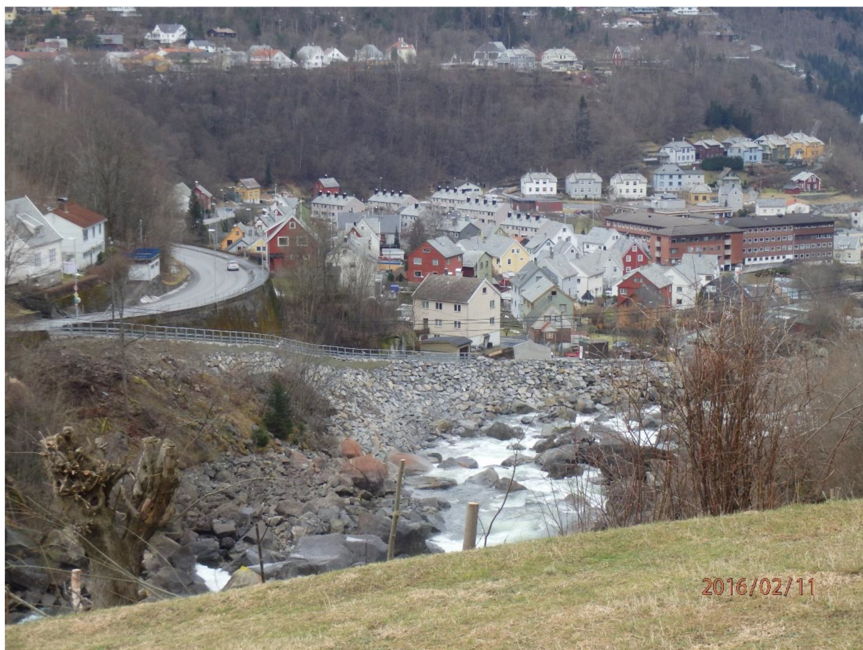
Figur 4 Ny erosjonssikring nedstrøms Eidesfossen. Dette området er ikke vist i oversikt over planlagt erosjonssikring Figur 5
