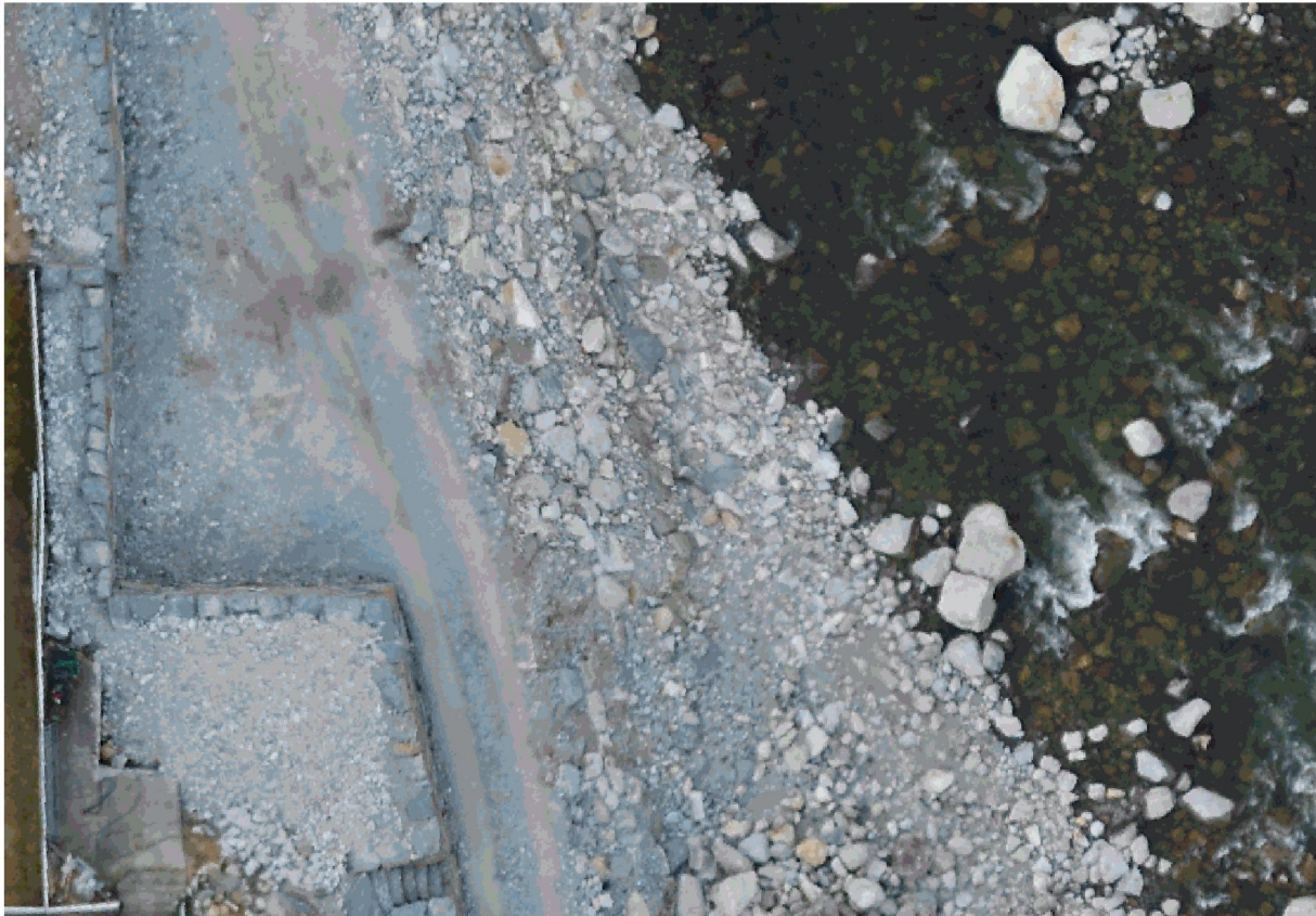
Figur 17 Detalj av erosjonssikring
