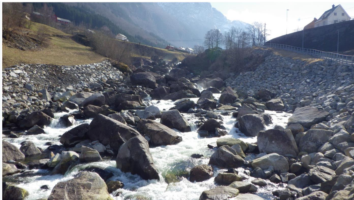
Figur 8-2 Opo nedenfor Eidesfoss med Mannsåker til venstre, ca. 8,3 m 3 /s vannføring. Bildet viser flomsikring, elvestrengen og infrastruktur på vestsiden som samlet gir gjerdingseffekt.
