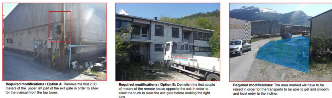
Figur 9: Eksempler på utbedringer på vei fra kai i Svelgen og opp til FV 572
