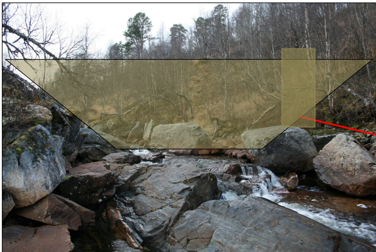
Figur 9. Dam og inntak nedstrøms dammen. Start på rørgate er skissert med rød strek
