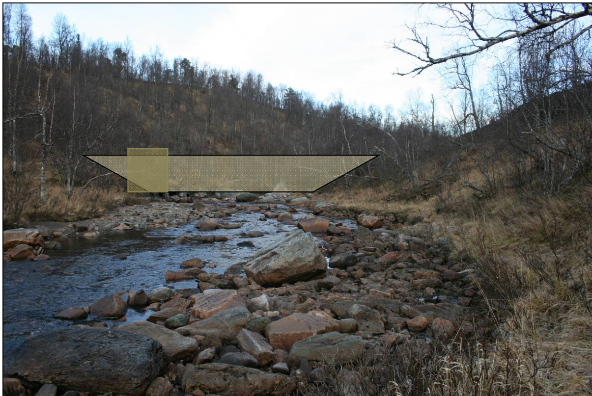
Figur 8. Dam og inntak sett fra magasinet
