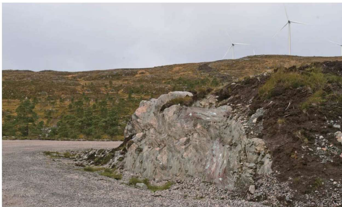
Figur 6 - Fjellskjæring uten tiltak (kilde: Norconsult)
