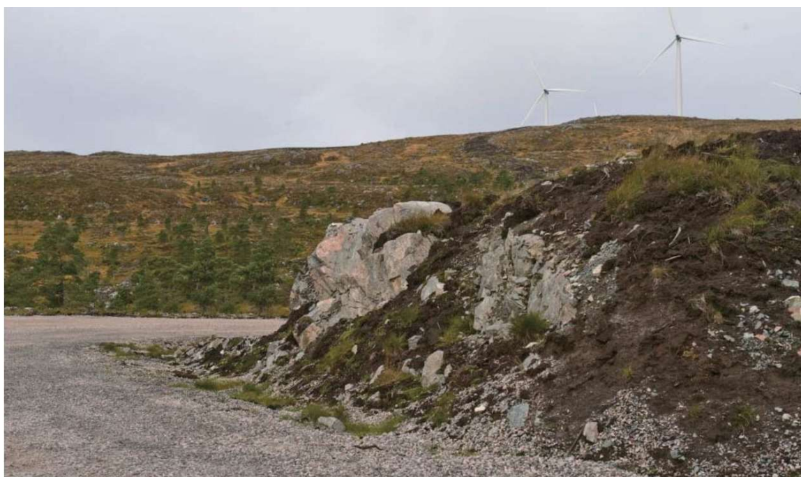
Figur 7 - Fjellskjæring kledd med løsmasser (kilde: Norconsult)
