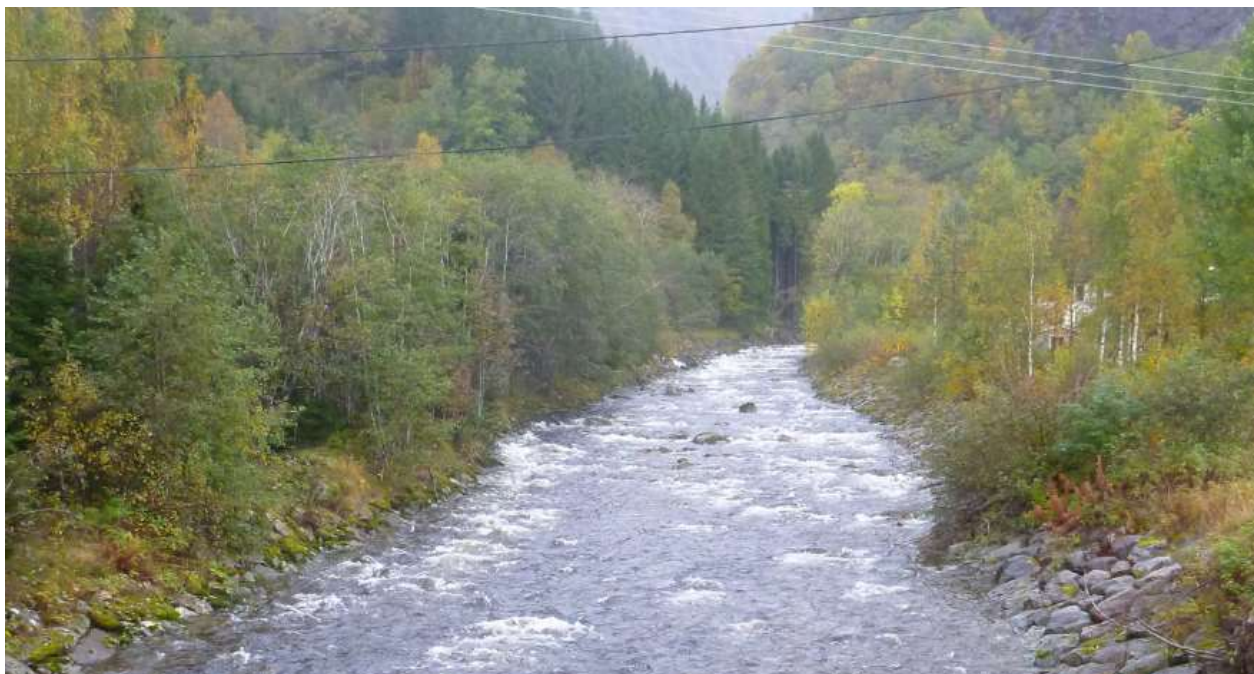
Figur 33: Nederste parti av Kvanndalselva, sett fra Hardangerveien. Her nede er elven relativt flat og bred. Forbygninger sees på begge sider.
