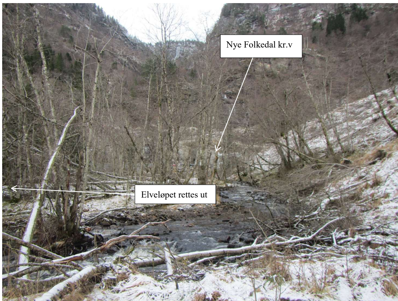
Figur 16. Omlegging av elveløpet
