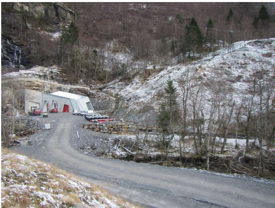
Nye Folkedal kraftverk og øverste delen av røtraseen
