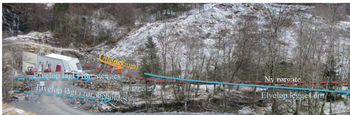
Figur 14 Nye og eksisterende inngrep ved Nye Folkedal kraftstasjon, adkomstvei og utløpskanal.
