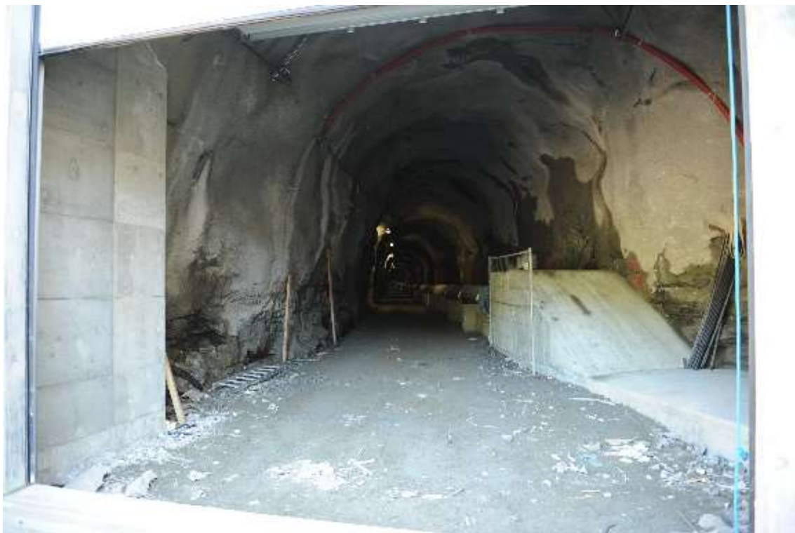
Rør i tilløpstunnel til Nye Folkedal kraftverk
