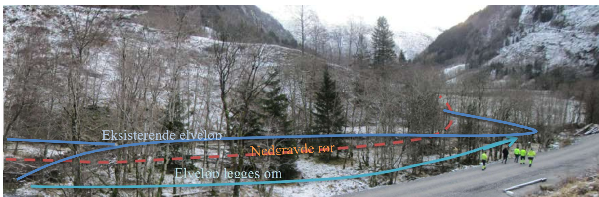
Figur 15 Omlegging av elveløp; rørgatetrase
