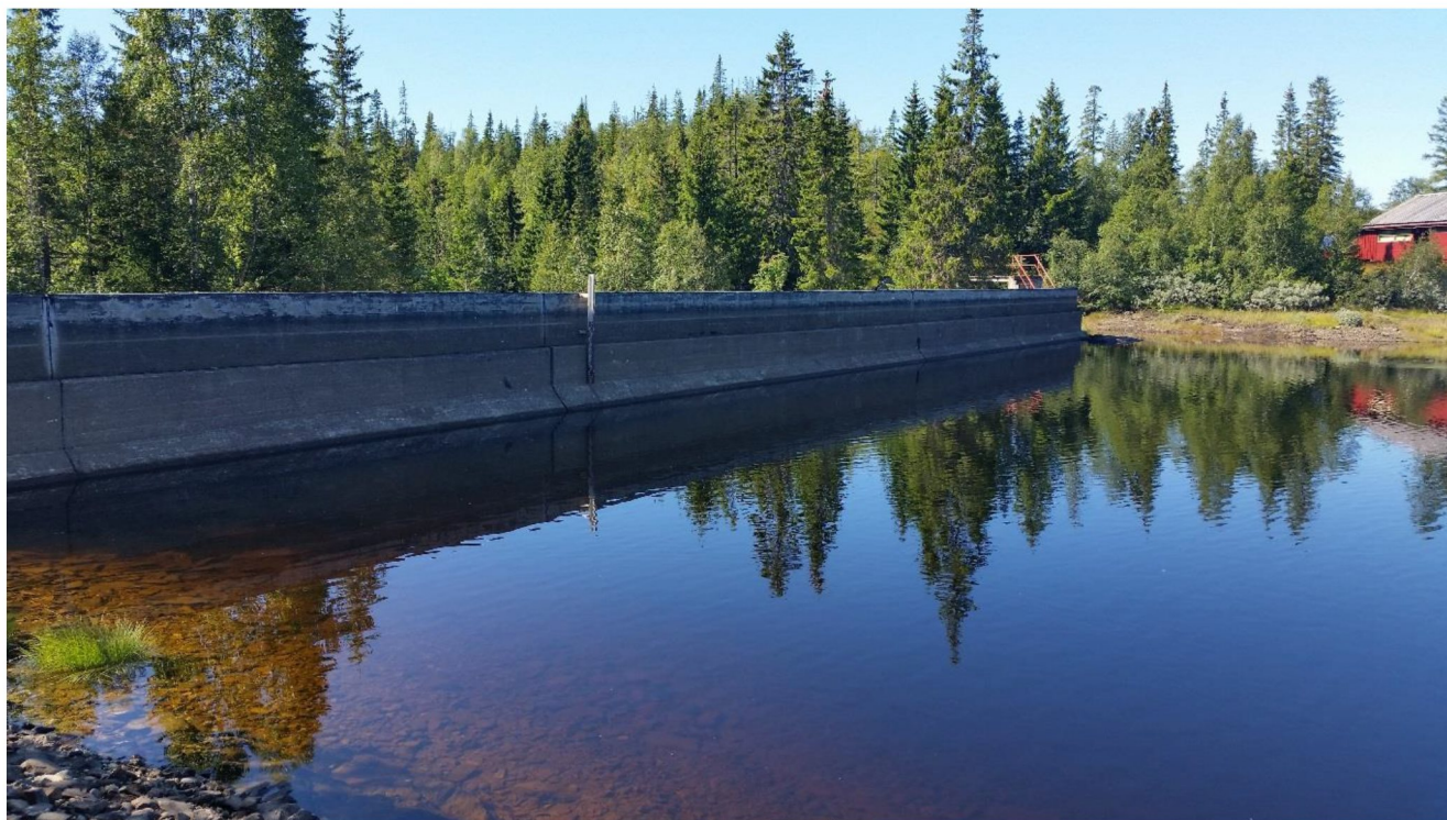
Figur 23 Eksisterende dam Røssin. Vannstand 17. august 2016: + 354,5
