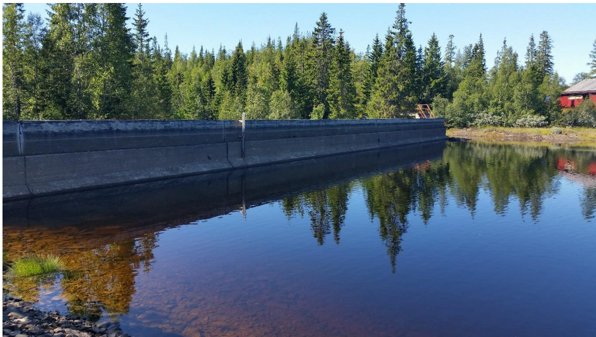
Figur 1. Dam Røssin sett fra øst. Foto: 17.8.2016.
