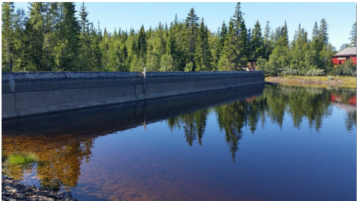
Figur 2 Eksisterende dam Røssin.
