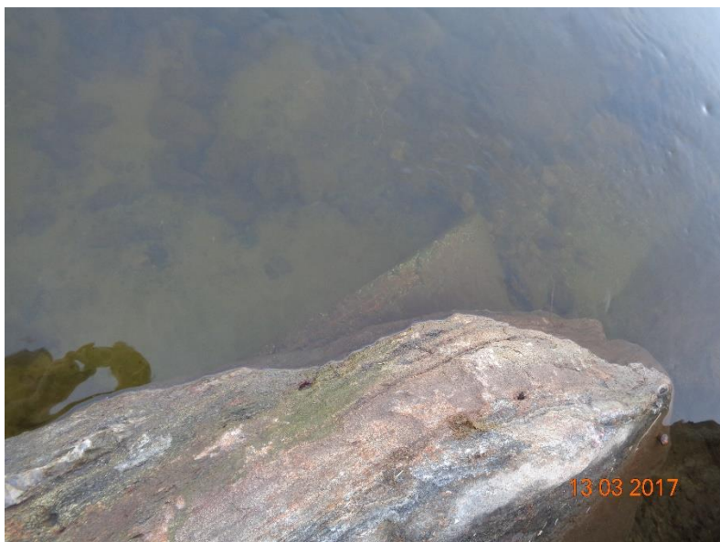
Avledningsrør på 80cm i diameter som er gravd ned ifm erosjonssikring av området
