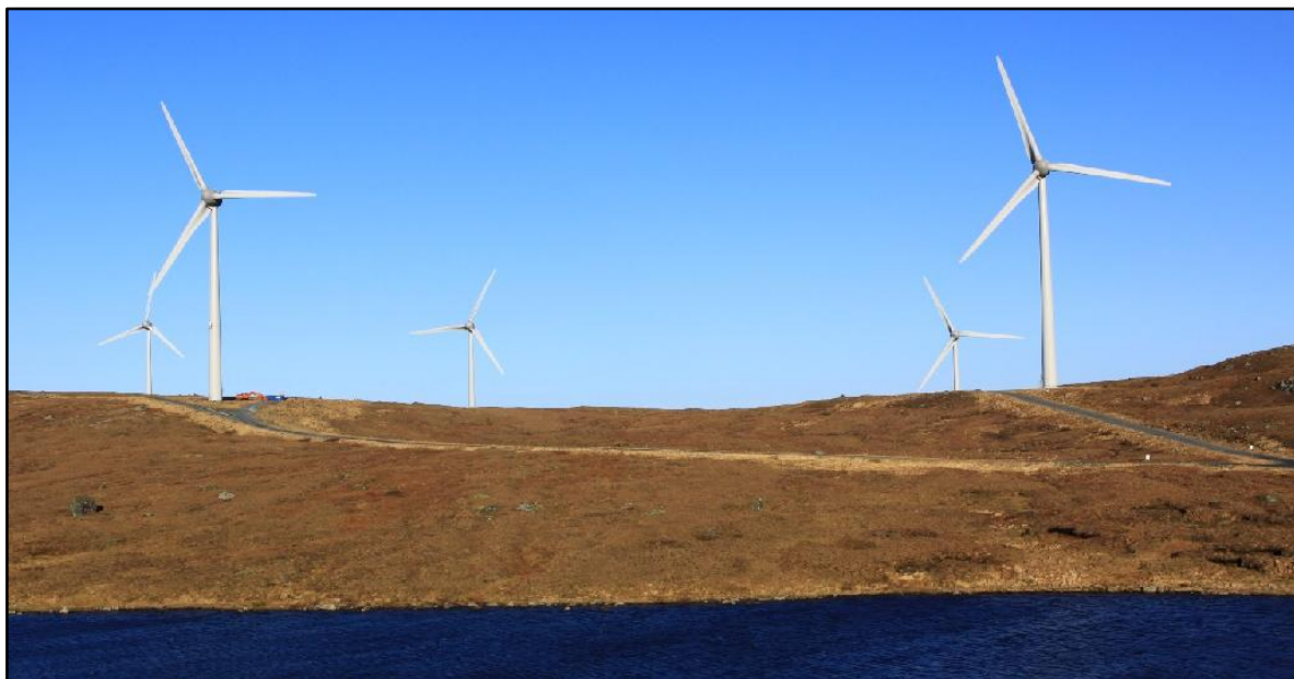
Figur 13-1. Vindturbiner i et karrig kystlandskap (Mehuken vindkraftverk, Sogn og Fjordane). Foto: Kjetil Mork, Multiconsult.
