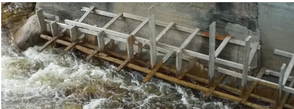
Figur 108: Statens Vegvesen har iverksett erosjonssikringstiltak på den nye brua over Rv9
