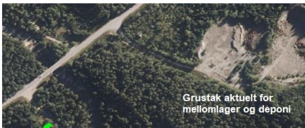
Figur 69: Massetaket på Skomemoen, berre nokre steinkast unna elva. Mesta Entreprenør AS har avtalen med grunneigar.
