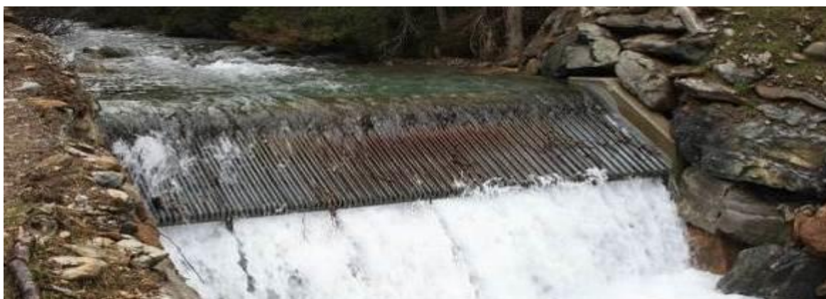
Figur 114: Eksempel på terreng-integrert coandarist.
