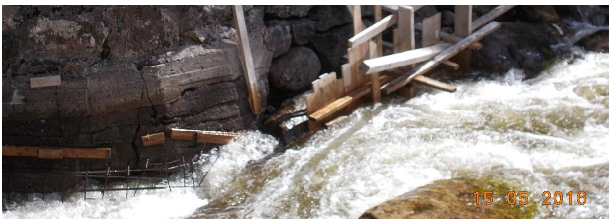
Figur 107: Statens Vegvesen har iverksett erosjonssikringstiltak på den gamle brua over Rv9
