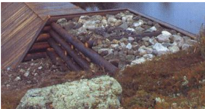
Figur 40: Tømmerkiste kan brukast til terskel/inntaksarrangement
