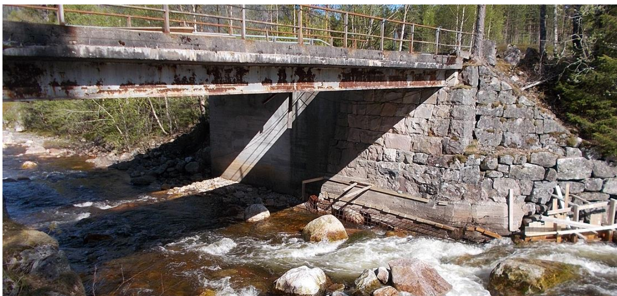
Figur 119: Jordkabelen for nettilknyttinga kryssar elva under gammal/ny bru for Rv9. Arbeid har pågått eit par år.
