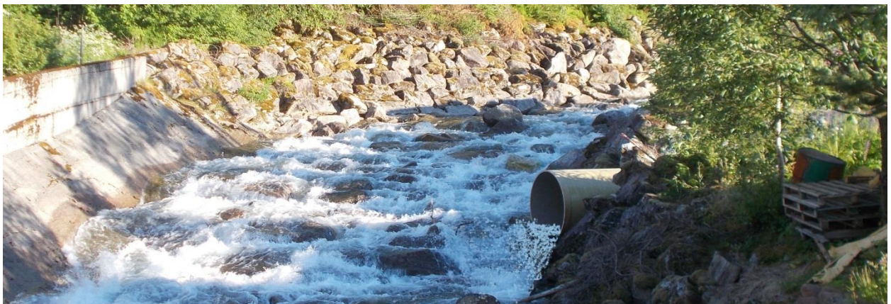
Figur 104: Illustrasjonseksempel for utløpskulvert frå kraftstasjonen.
