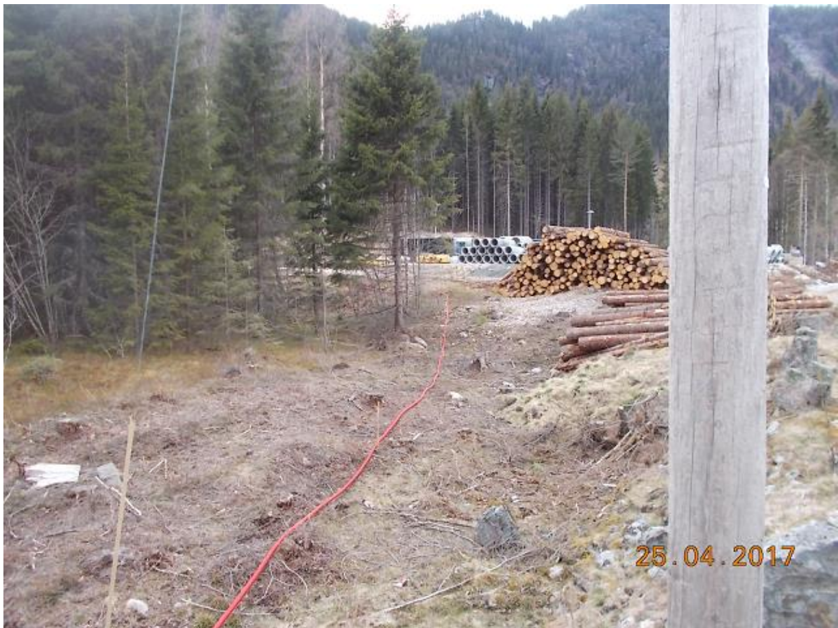
Figur 65: Omsøkt nettilknytting følger tilnærma dagens trasé for Rv9-anlegget sin nettaksess – men skal gravast ned!
