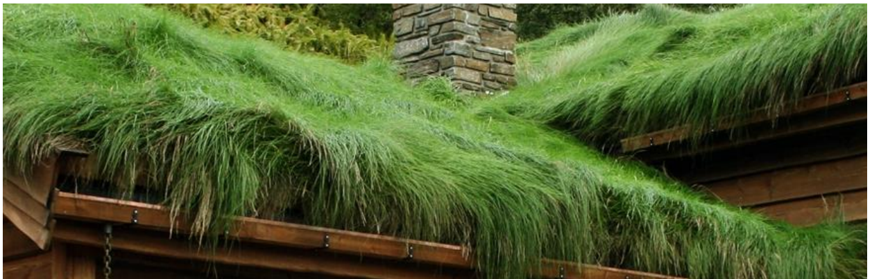
Figur 56: Kraftstasjonen skal ha torvtak.
