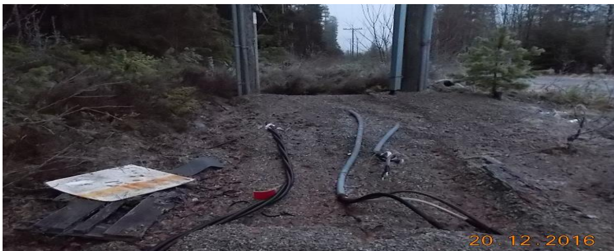
Figur 64: Kablane er klare for tilknytting til 22 kV i massetaket sør for elva.
