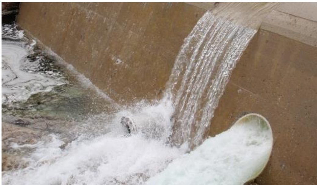
Figur 123: Eksempel på arrangement for minstevassføring.
