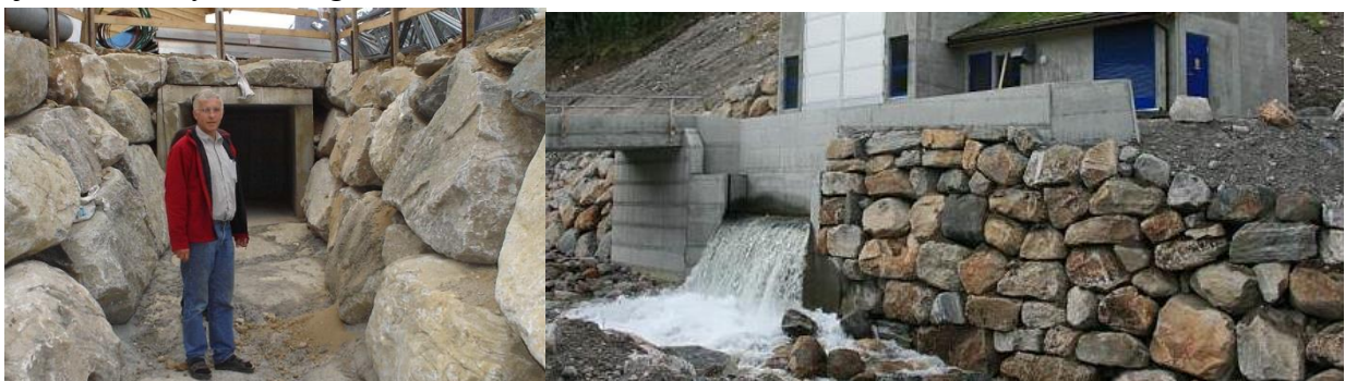
Figur 127: Peltonutløp utan «vasslås» – og med, der terskelen stenger lyden.
