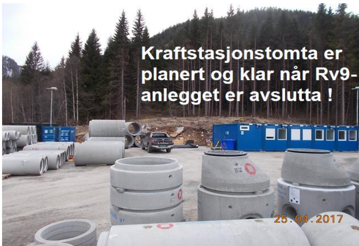
Figur 113: Riggområdet til Rv9-entreprenør Br. Thorkildsen/Statens Vegvesen.
