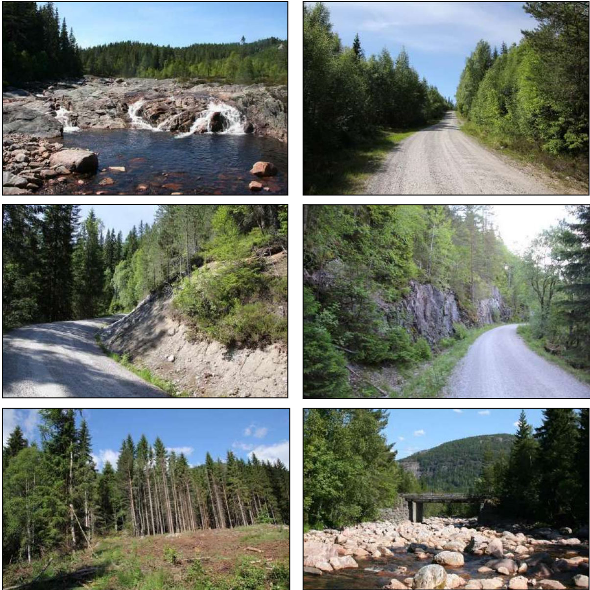
Figur 3: Øvst til venstre: Ved inntaket på kote 409 blir det bygd eit coandainntak som skal tilpassast elveprofilen lokalt. Øvst til høgre og midten: På mesteparten av strekninga blir røyr-gata graven ned i vegkanten (hovudalternativet). Nedst til venstre: Kraftstasjonen leggjast i utkanten av ei hogstflate på kote 228. Nedst til høgre: Skomåni på strekket nedstraus avløpet frå kraftverket. Traséen for nedgraven 22 kV kabel vil krysse elveløpet, og Rv9, i trekkerøyr under brua.
