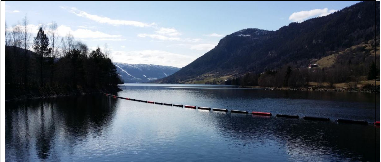
Strandafjorden lense ved inntak 444,45
