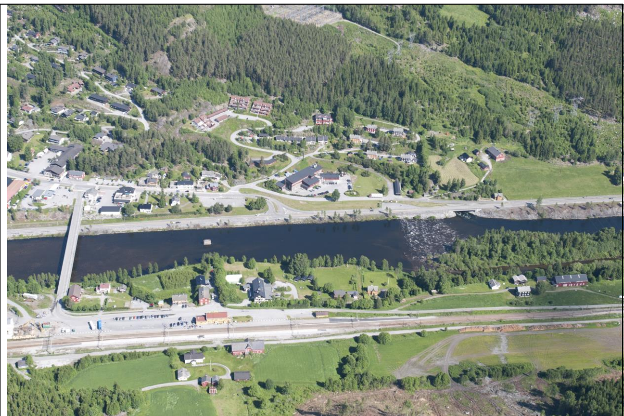
Ved Gol. Terskel og avløp fra Hemsil 2 kraftstasjon
