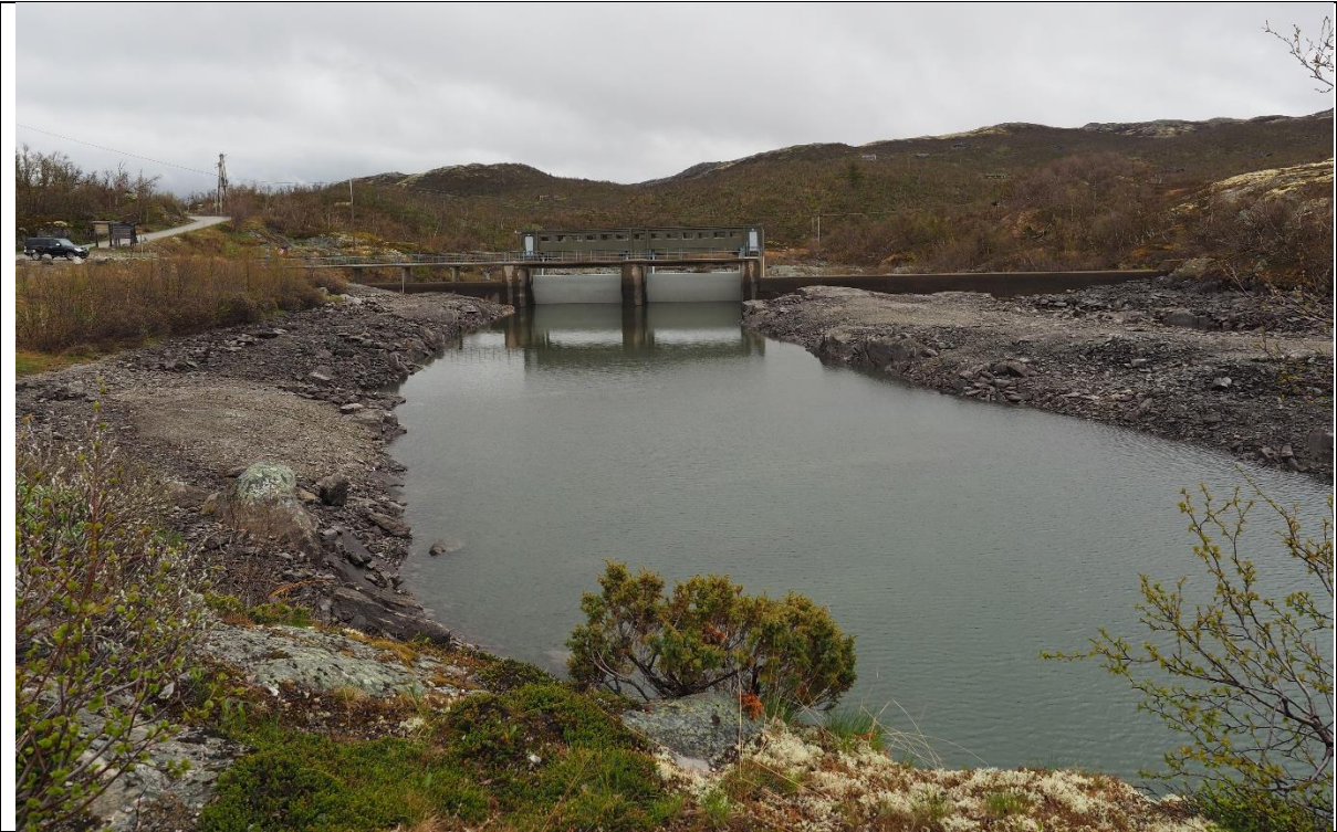
Dam Ustevatn. 8. juni 2017 982,30
