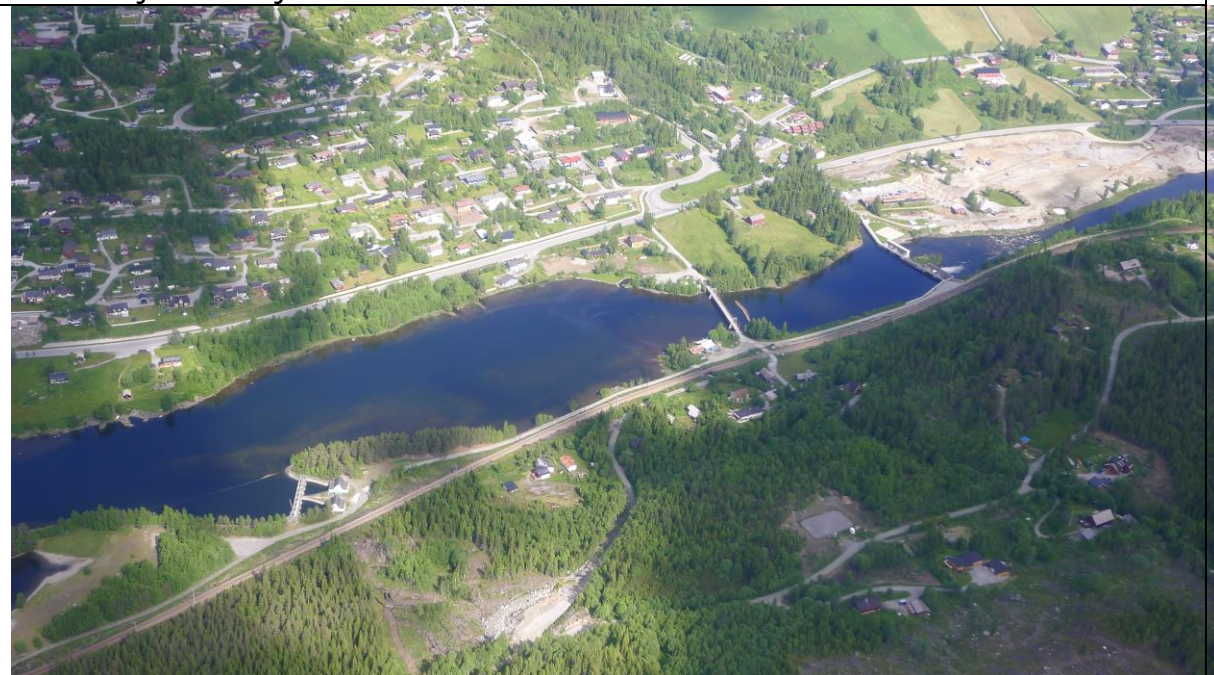
Strandafjord. Inntak Nes kraftverk og Dam Strandafjord. 21. juni 2012
