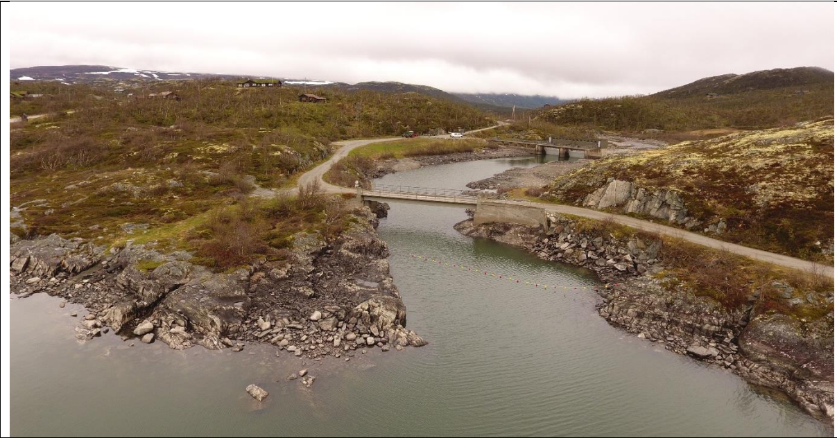
Dam Ustevatn 9. juni 983,03
