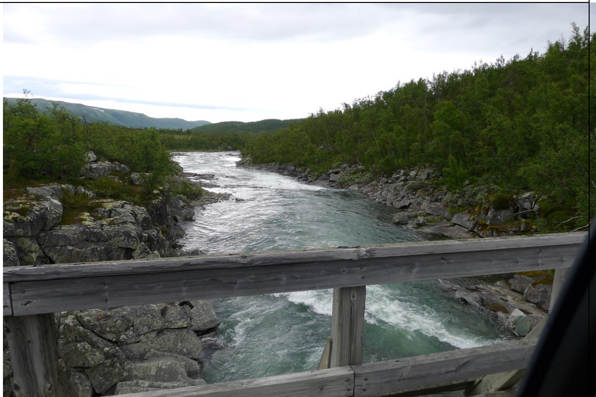
Usteåne med flomvassføring over dam Ustevatn. Bru Biskolavegen. 6. august 2015
