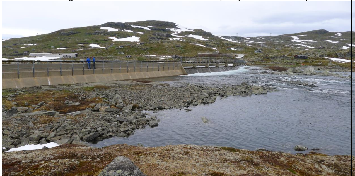
Dam Finsevatn 6. august 2015 sommervannstand 1215,26 (flomvannstand)
