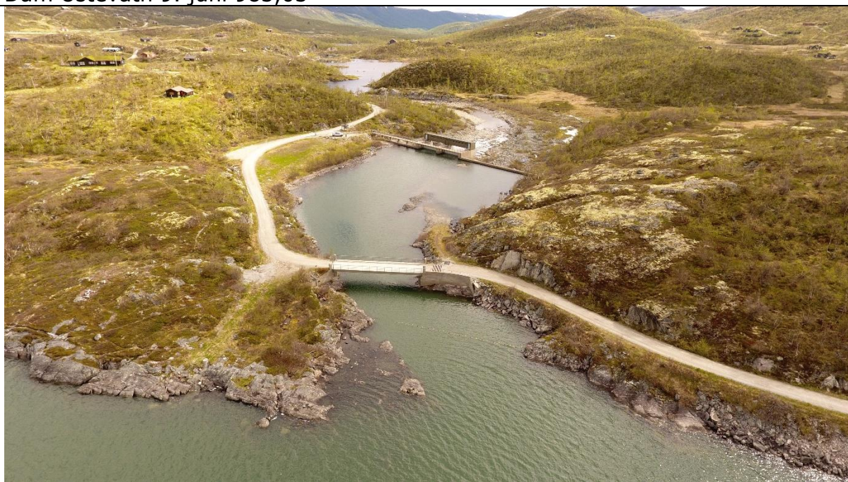
Dam Ustevatn 12. juni 984,18
