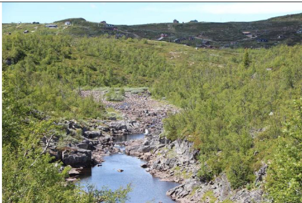
Oppstrøms Biskola brua.
