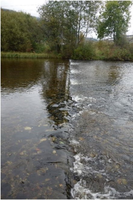
Terskelen rett oppstrøms RV7.
