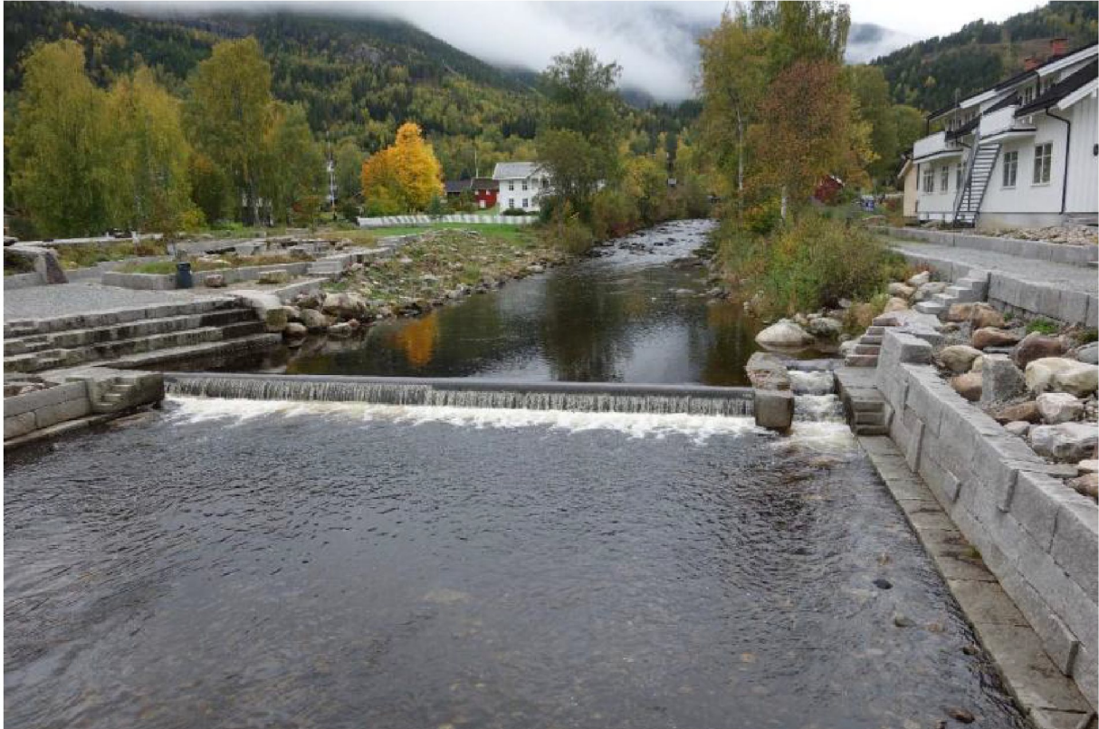
Bildet er tatt fra Hagembrua og viser terskelen med fiske-trapp og flomparken.
