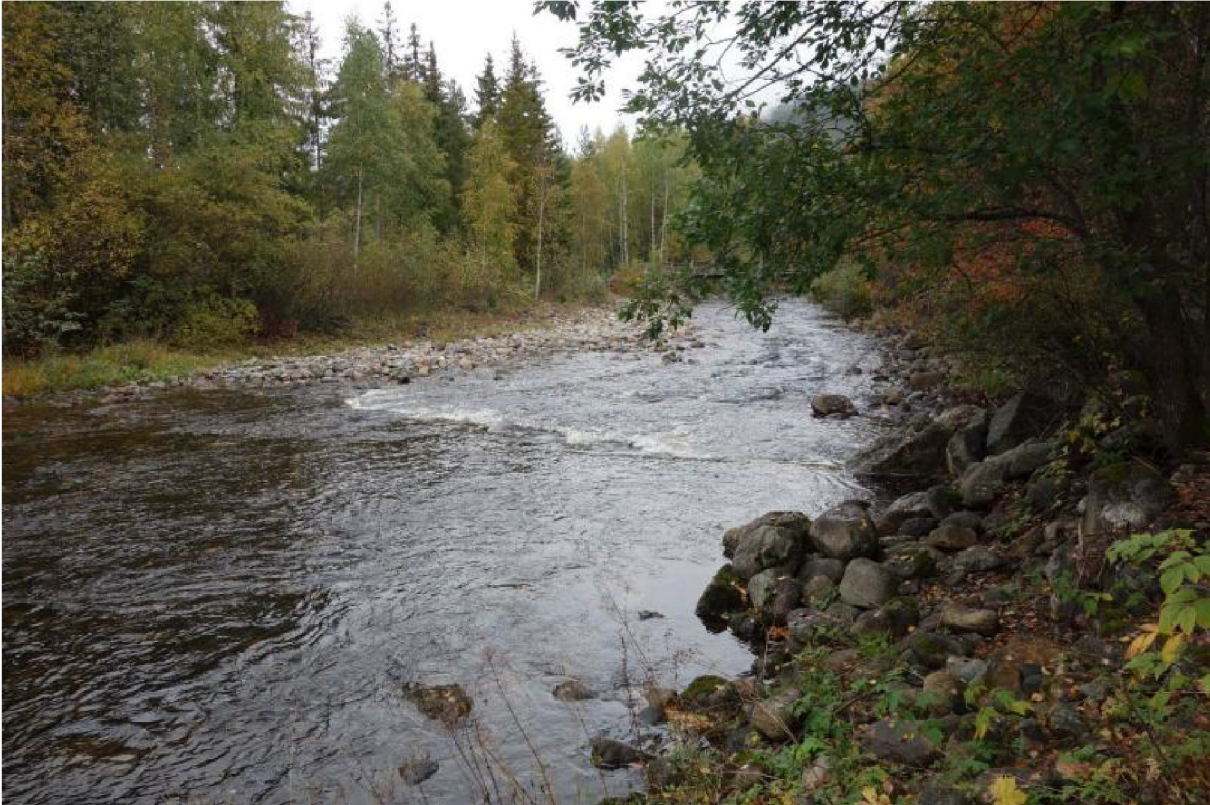
Bildet viser erosjonssikringen av kloakkledningen som Nes kommune har bygd.
