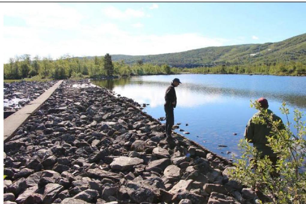
Nordre terskel ved utløpet av Ustedalsfjorden.
