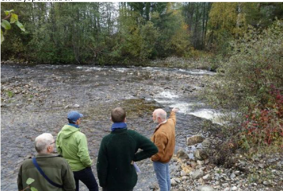
Terskelen 150 meter oppstrøms RV7. Midtre del er begravd i grovkornet sediment.
