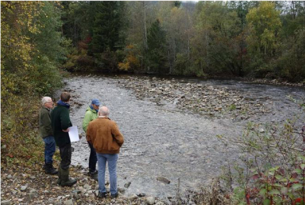
Oppstrøms terskelen er det opplagret mye grovkornet sediment.
