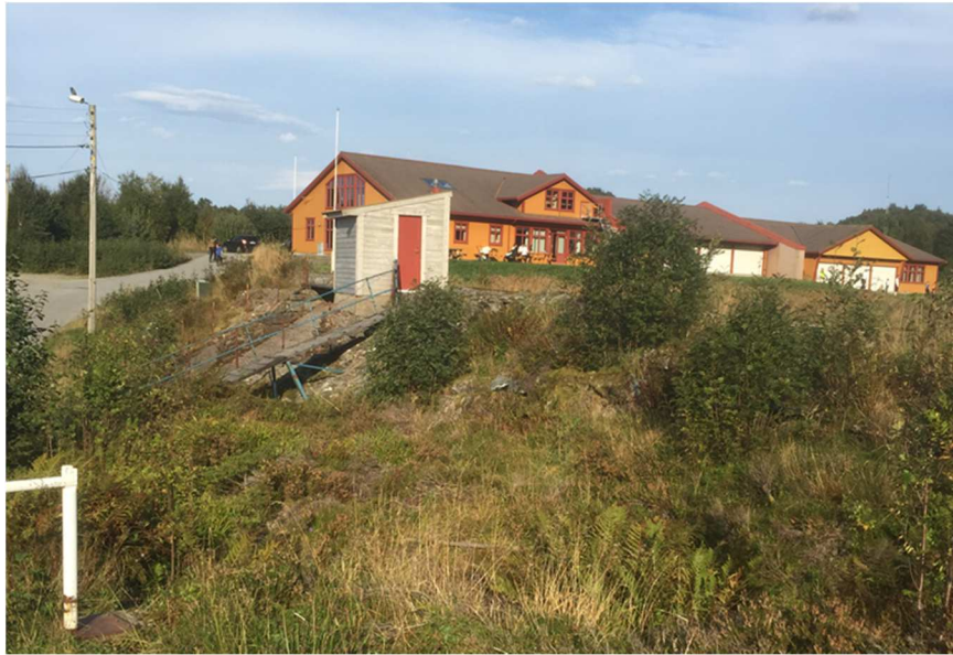
Figur 2 Dam Sætrevatn sett frå nedstraums side.
