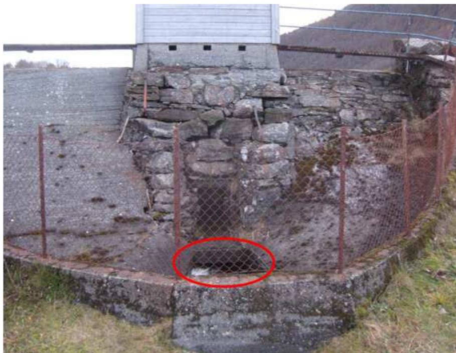
Figur 4 Overløpet på dam Sætrevatn. Det er ringa rundt avløpet frå luka, dette fortset rett inn i ein kulvert som går under vegen og ut i Vassetvatnet.
