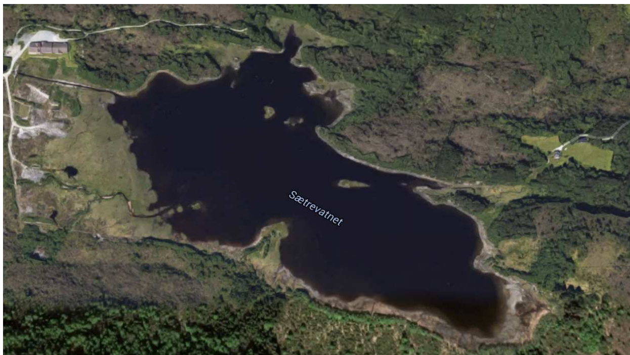
Figur 5 Det er vegetasjon i reguleringssona rundt Sætrevatnet som følgje av at reguleringa berre blir brukt som dempingsmagasin. Dam Sætrevatn er plassert i enden av kanalen, heilt til venstre i biletet.
