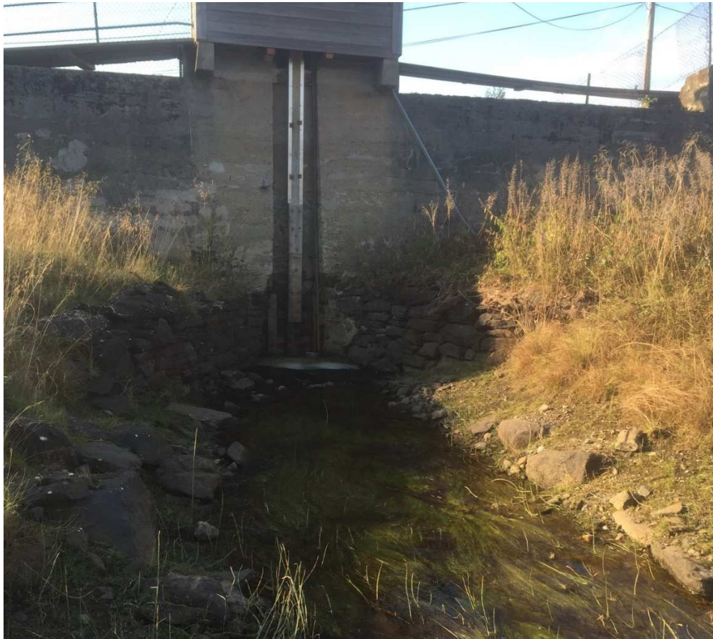
Figur 3 Kanalen på oppstrauts side av dam. Heilt inn mot dammen kan ein sjå muren som snevrar inn kanalen.
