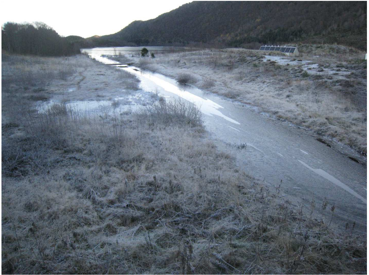
Figur 7 Kanalen og dam Sætrevatn ved ein vasstand på 20,3 moh.
