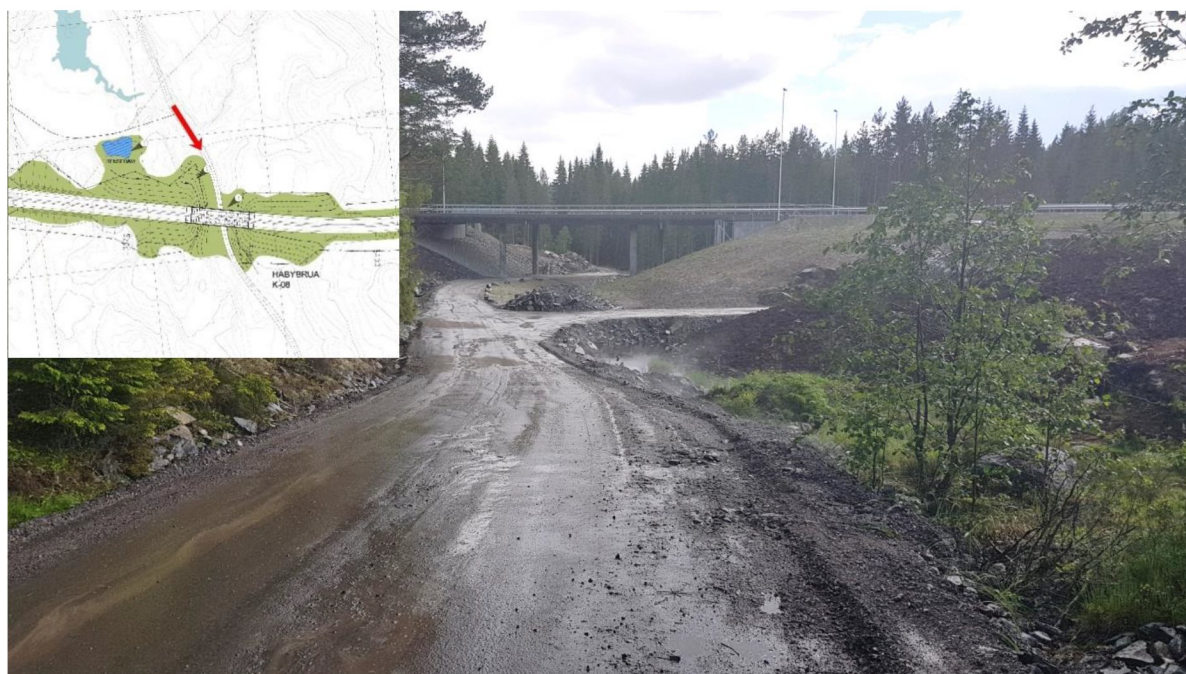
Figur 1: Dagens situasjon ved Håbybrua
