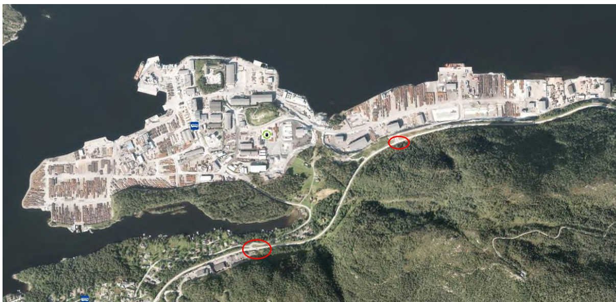
Figur 3-8 Fjordbase sitt havneanlegg i Florø. Markeringene viser aktuelle avkjørsler ut på riksveg 5.
