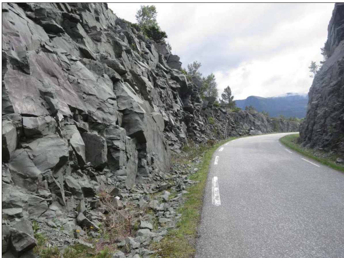
Nærbilde av en fjellskjæring langs fylkesvei 577 til Botnane. Fjellskjæringen er delvis flisete og har en estetisk lite tiltalende overflate.
