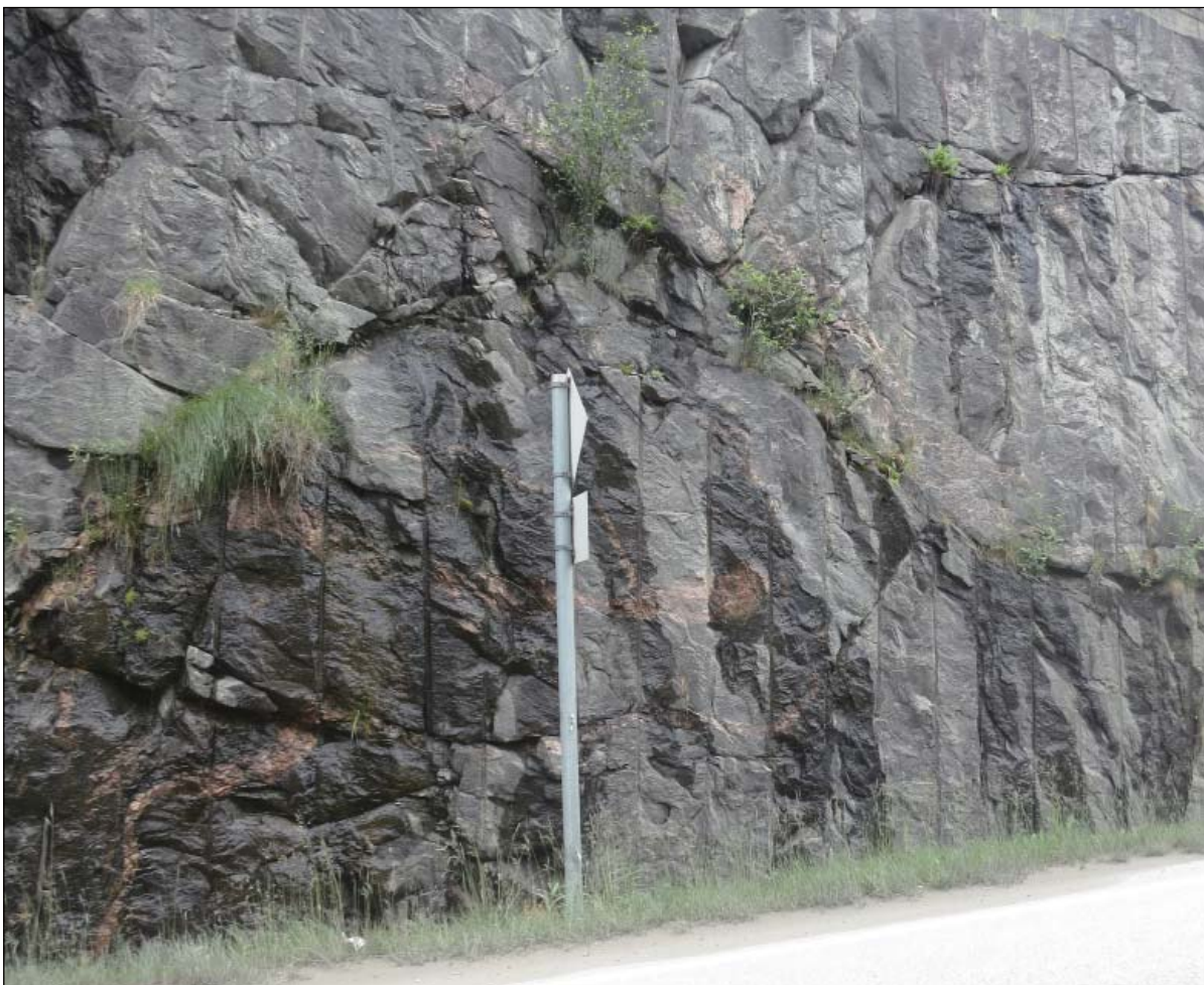
Tette salver og konturboring gir riktignok kilemerker i berget, men gir også slette flater og lite flisfjell
