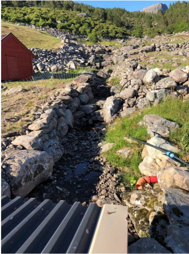
Figur 5: Vannforsyning i vinterhalvåret til fastboende på vestsiden av Terdalselva (mrk. 10 i Figur 1). Anvendes ikke i sommerhalvåret pga. liten vannføring og fare for fekal forurensning fra beitende dyr. Det var ingen vannføring i bekk-/grøft inn mot inntaksløsningen under befaring 12. juni 2018. Vannstand i inntakskum sto ca. 30 cm under topp ring på befaringstidspunktet.
