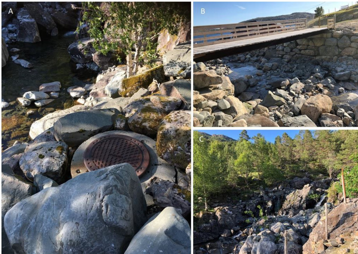
Figur 4: Vanninntak fra Storelva: A) til fritidsbolig på østsiden av elva (mkr. 8 i Figur 1), B) til fastboende på vestsiden av elva (under svært tørre forhold med liten vannføring på befaringstidspunkt 12. juni 2018) og C) til fastboende på vestsiden av elva under normal vannføring i elva (mkr. 9 i Figur 1).
