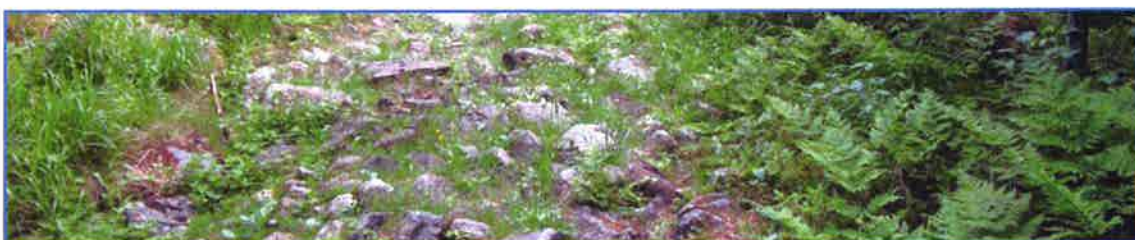
Figur 5. Eksempler på veistandard på brudalsveien fra nord til sør. Øvre bilde viser veien i nord slik den ser ut opp til Fjerdingbyputten, mens det nedre bilde viser «veien» slik den ser ut nær Ramstadsjøen. Stedvis går veien inntil bekk som trolig ble flyttet noe på når Fjerdingbyveien ble utbedret sist for en god del år tilbake.
