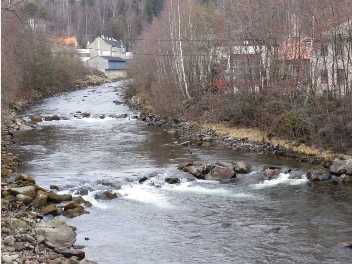
2 etablerte terskler som rehabiliteres og forsterkes
