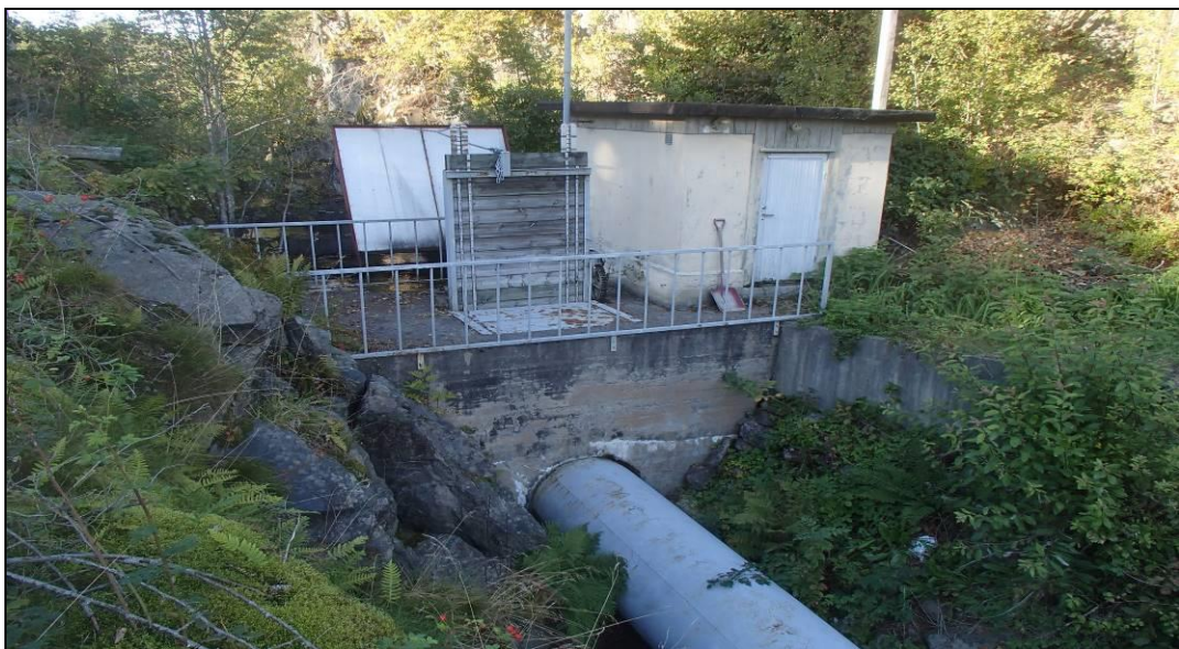
Figur 6. Inntaksdam planlegges revet. Nåværende vannvei planlegges erstattet med ny. Foto: Einar Tafjord
