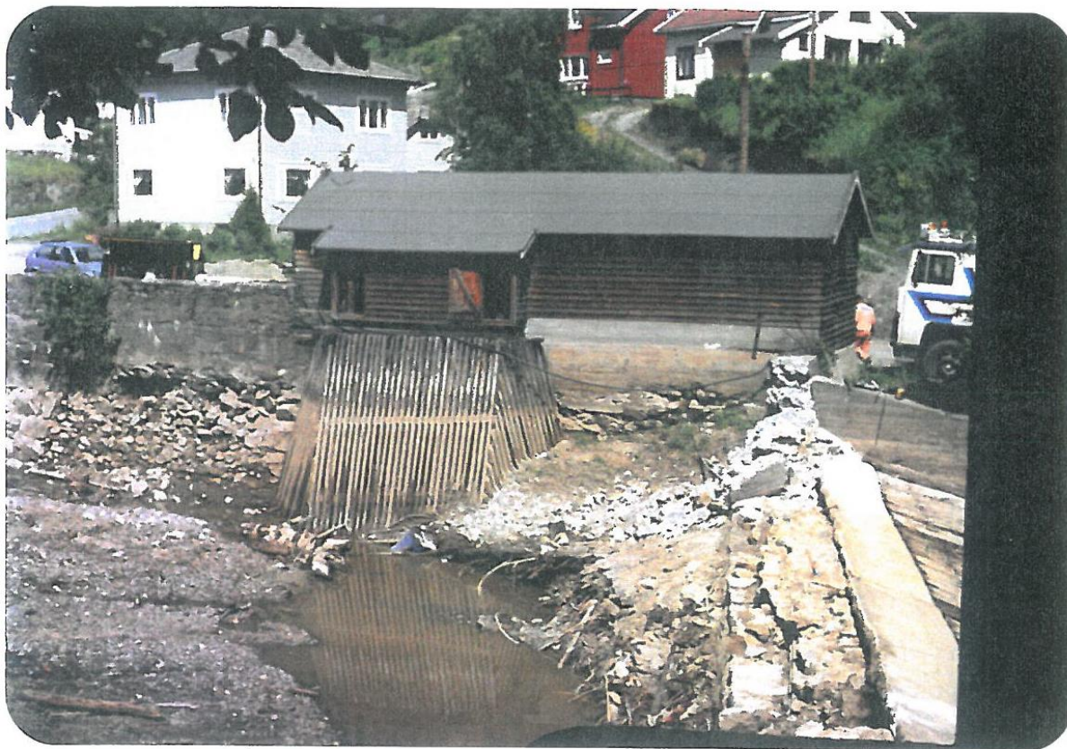
Gammel Dam med inntakskonstuksjon og Lukehus fra ombygging 1990.
