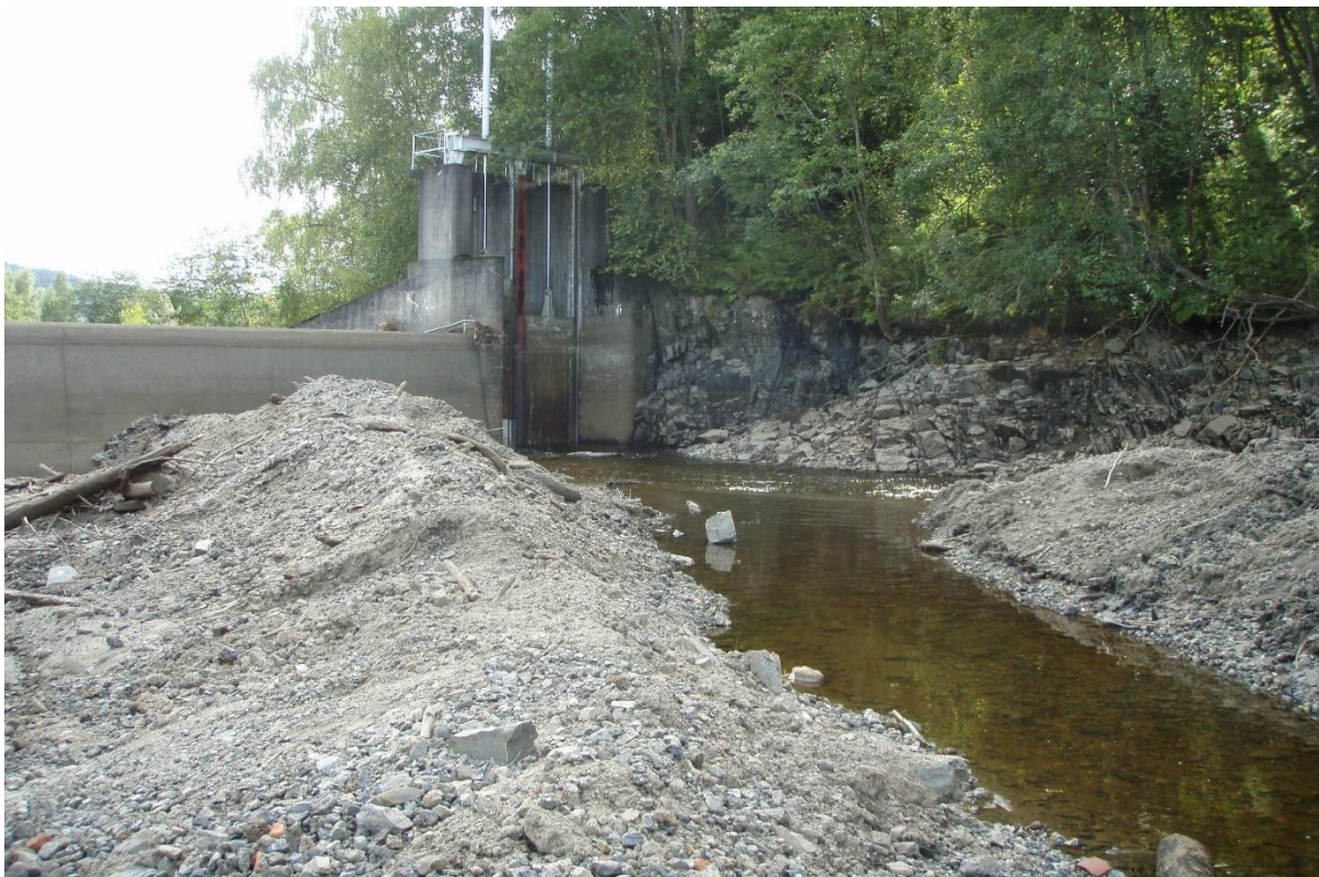
Nedtappet magasin med ledevoll ved arbeid i elveleiet/magasin 2012. Vannføringen ledes gjennom lukeløp ved glideluker på vestre side av dammen.
