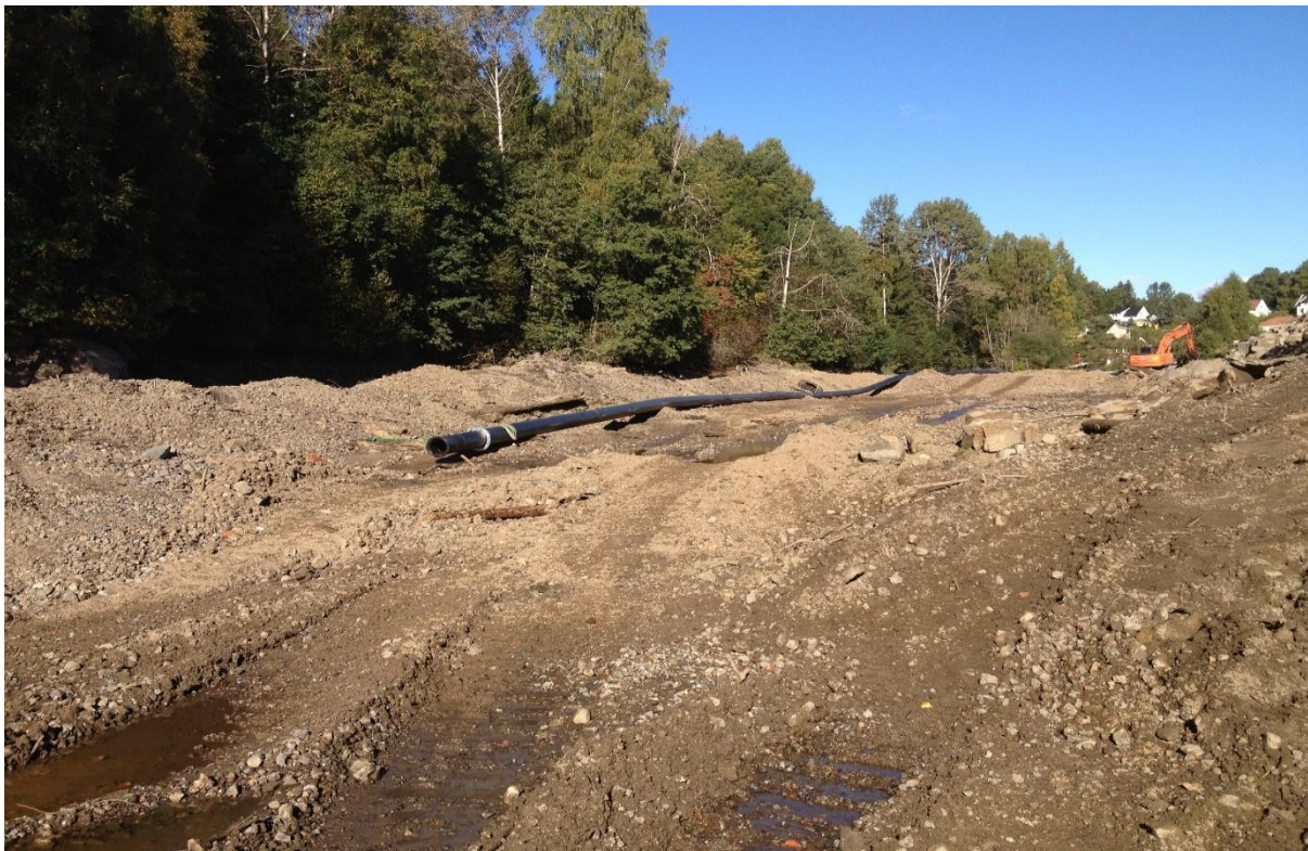
Legging av rørledning i bunnen av magasinet/elveleiet 2012.
