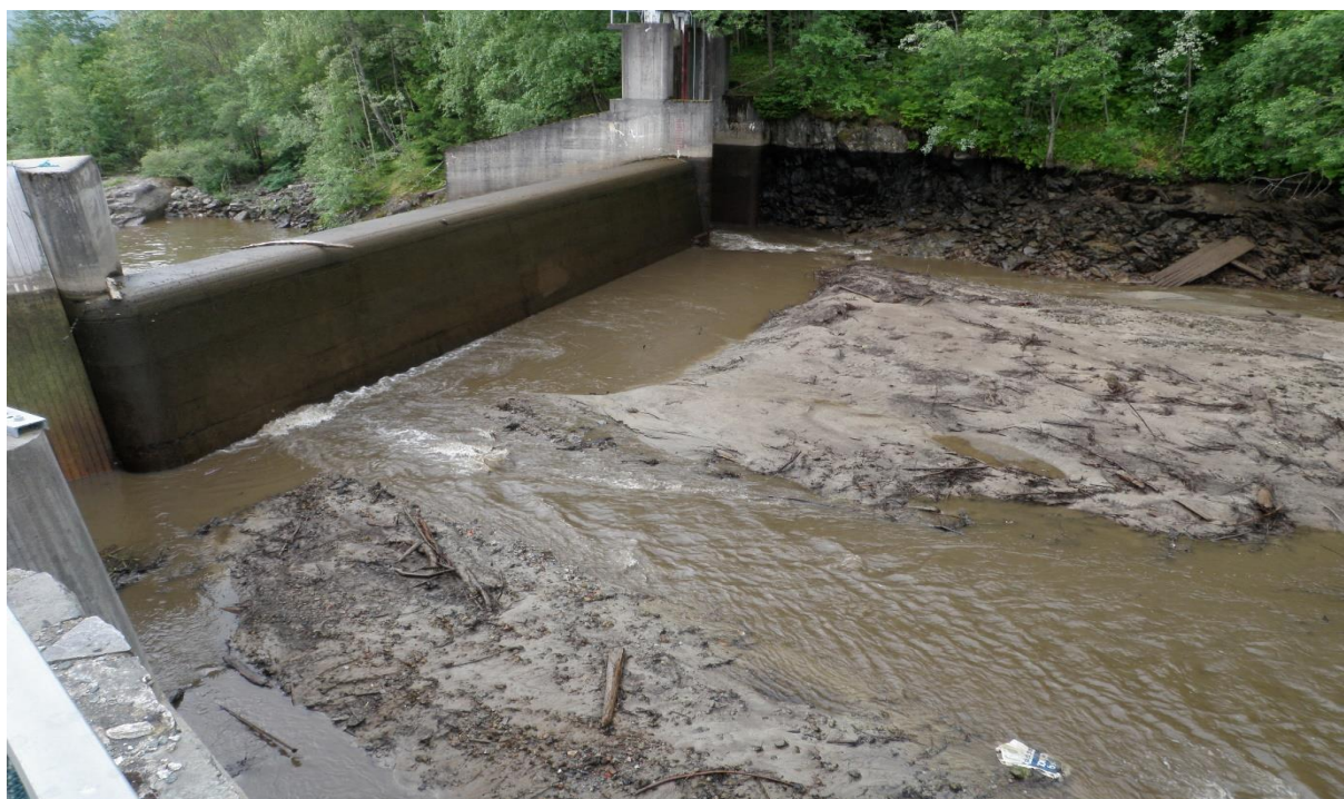
Gammel Dam med inntakskonstuksjon og Lukehus fra ombygging 1990.
