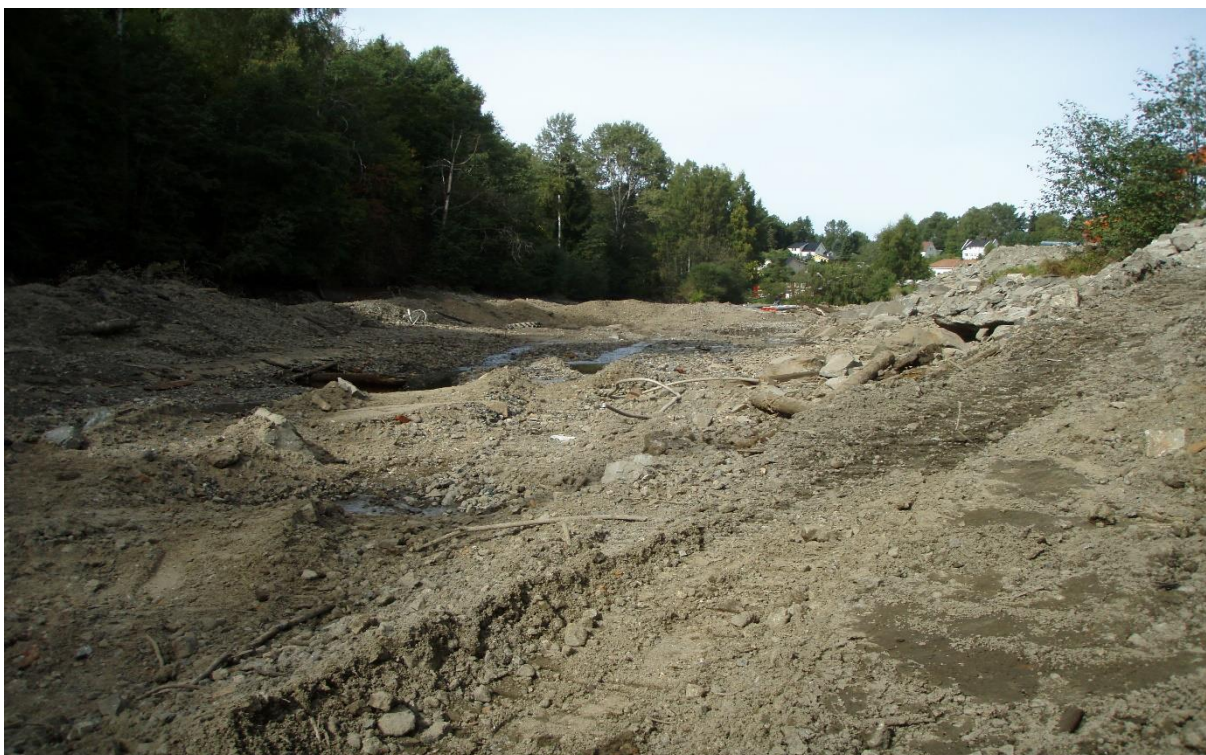
Nærbilde av bunnforhold i magasin Dam Skotselv under gravearbeid 2012.
