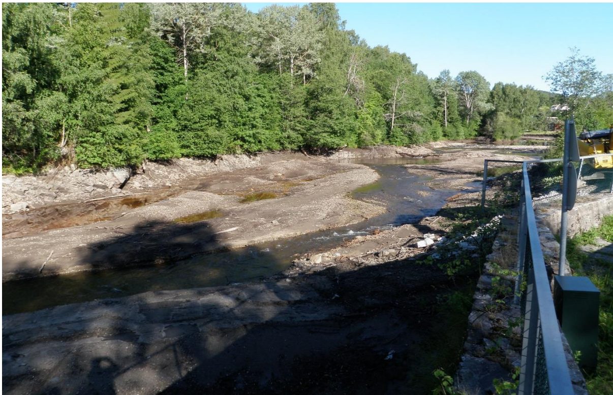
Nedtappet magasin sett fra lukehus oppstrøms Dam Skotselv ved gravearbeid 2012.
