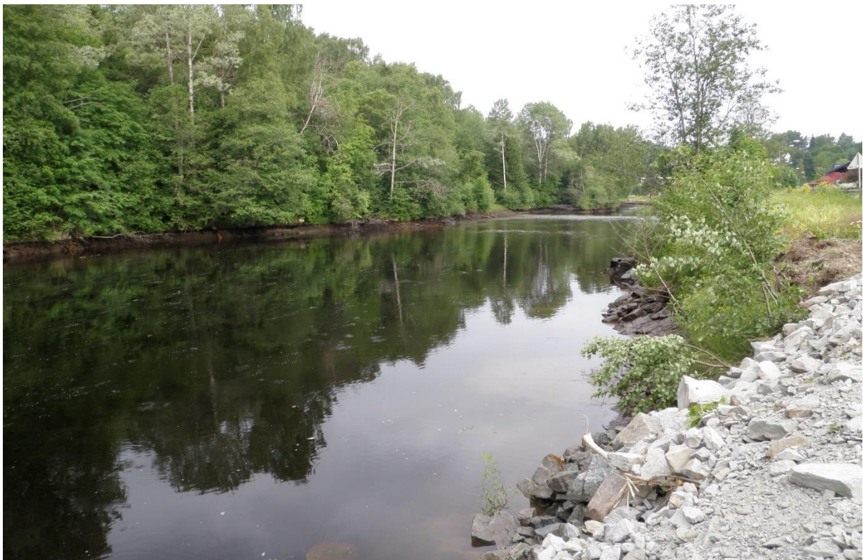
Magasin oppstrøms ved Dam Skotselv. Nedtappet magasin ca. 0,5 m, dvs. LRV.
