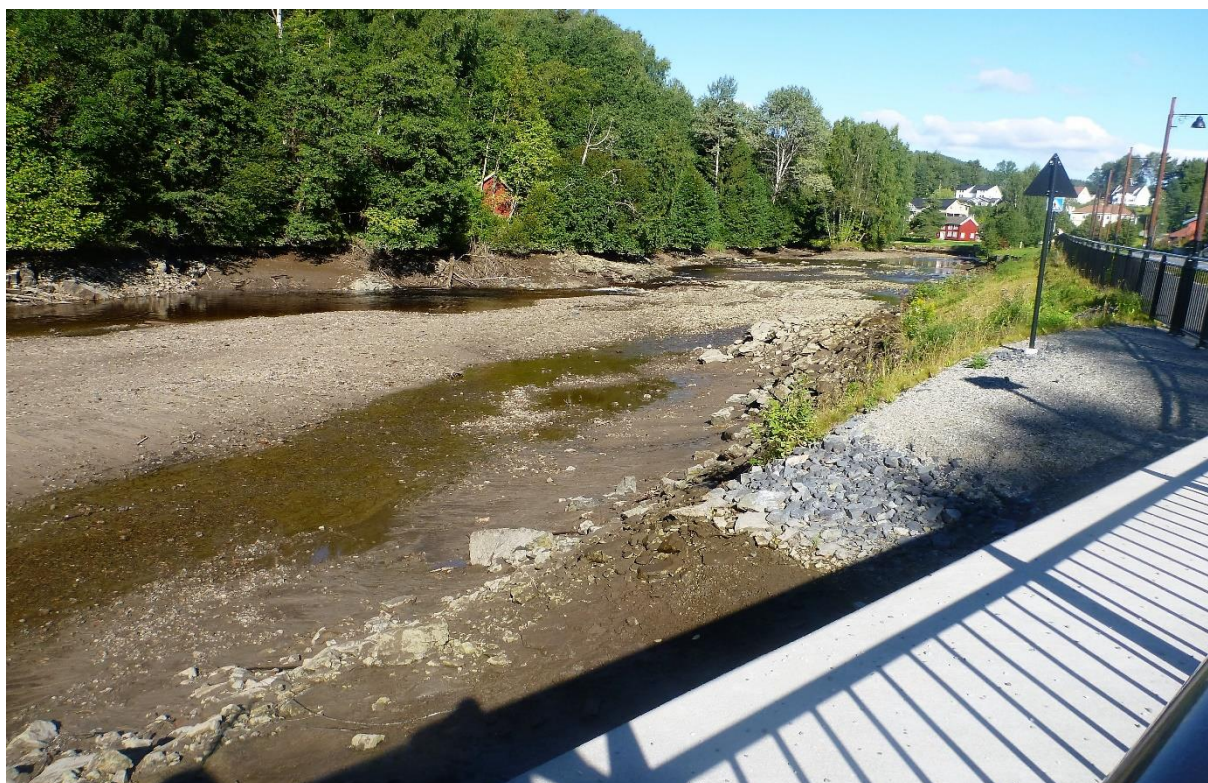
Nedtappet magasin ved revurderingstilsyn 2016.
