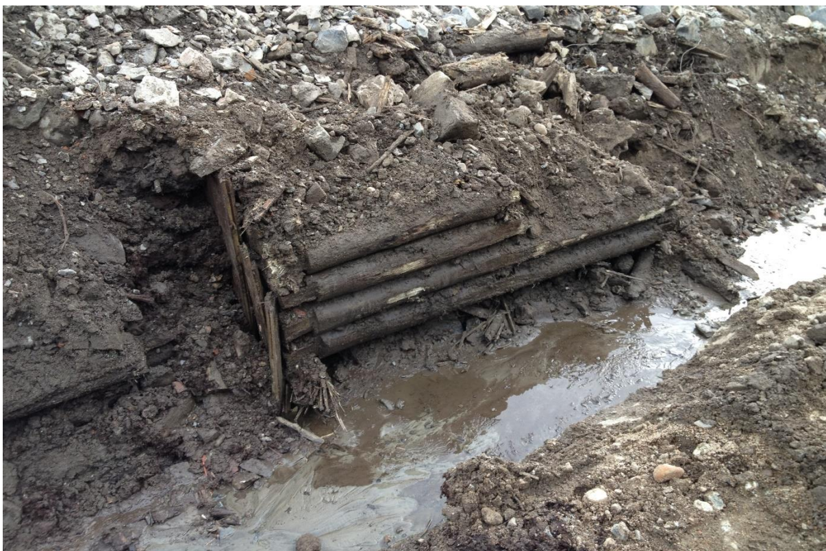
Rester av gamle tømmerkistedammer i elvebunnen i bunnen av magasinet i Dam Skotselv.
