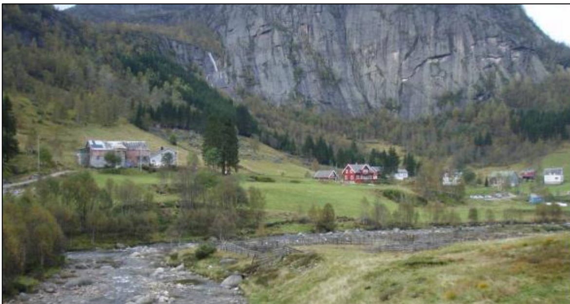
Figur 3-19. Skredåni forbi grenda Skredå. Foto: Terrateknikk
