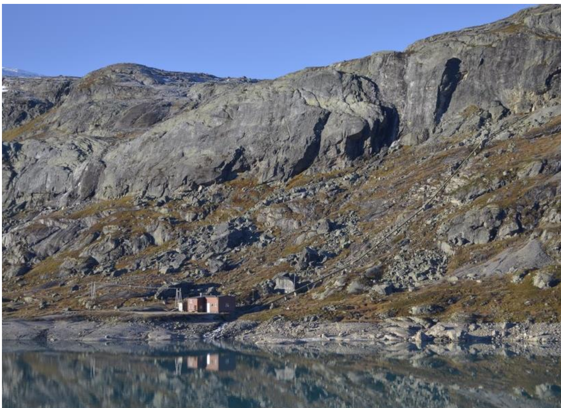
Figur 6 Fivlemyr kraftverk, ved Fivlemyrmagasinet
