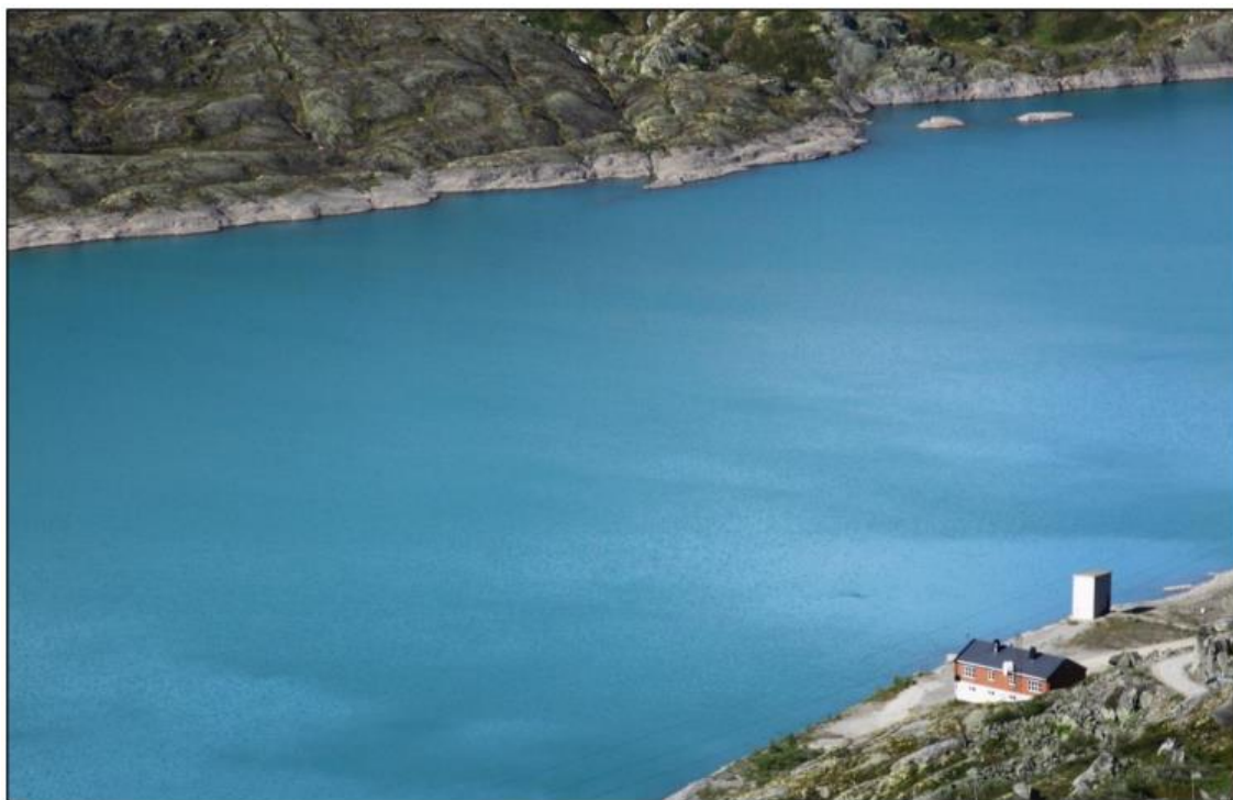
Figur 5 Herva kraftverk ved Skålavatn
