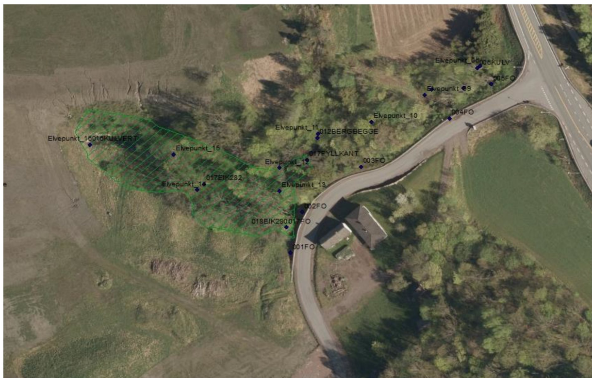
Figur 6: Oppfylling av Skjervikbekken vist på flyfoto, oppfylling vist i grønt.
