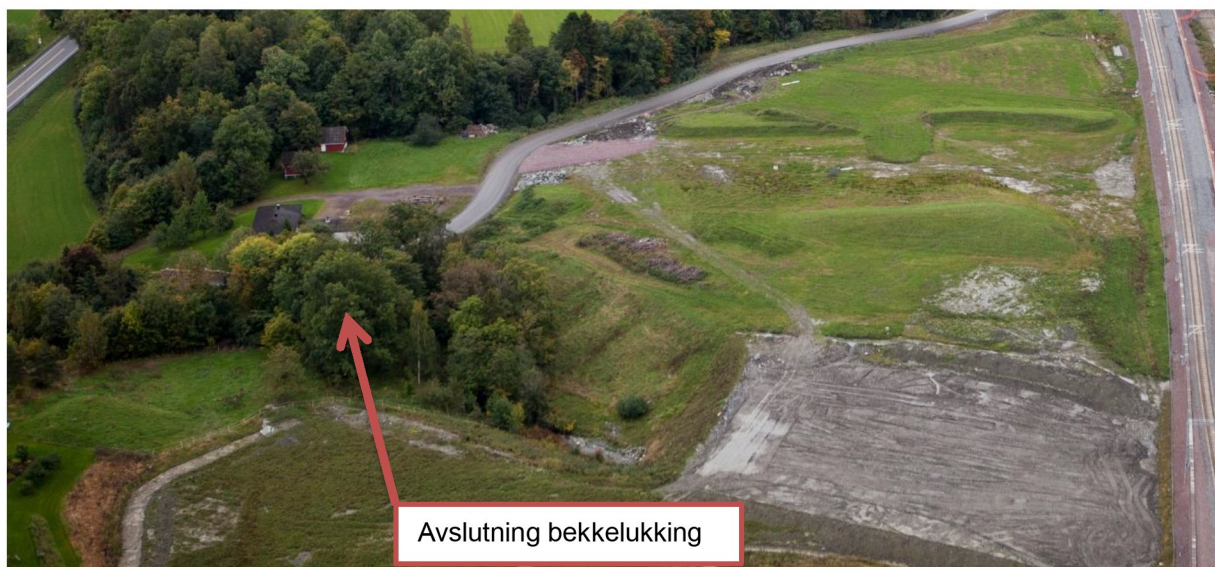
Figur 5: Flyfoto fra Skjervikbekken 2013. Fyllingen nærmest jernbanen er nylig etablert. Bildet er tatt mot sør.
