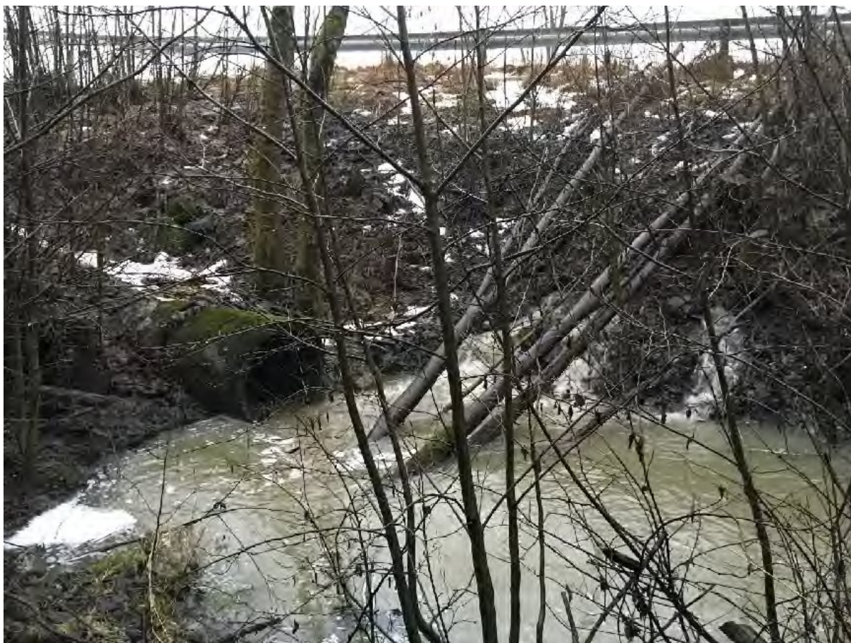
Skjervikbekken innløp kulvert fv.313, flom 8.2.2016 vannføring ukjent
