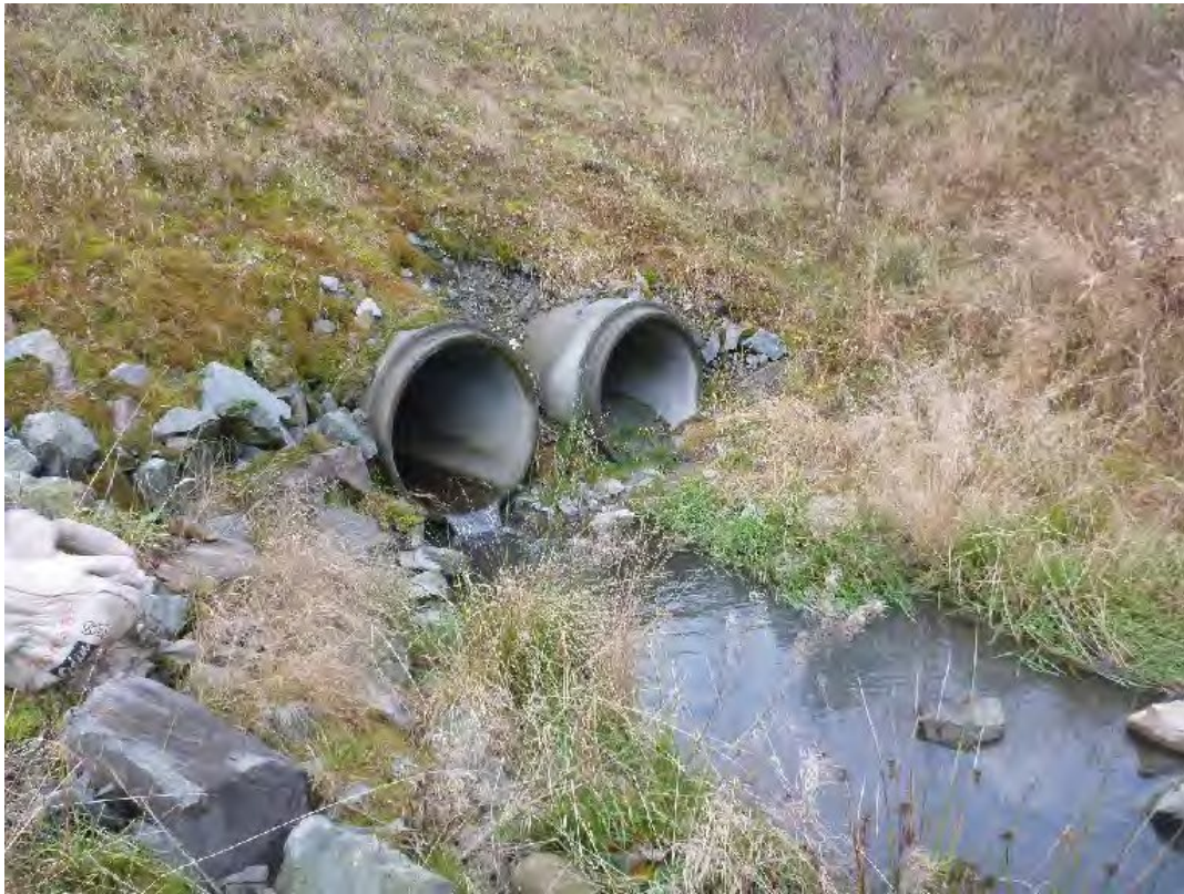
Dagens utløp fra Skjervikbekken under jernbanen, liten vannføring. Liten vannføring
