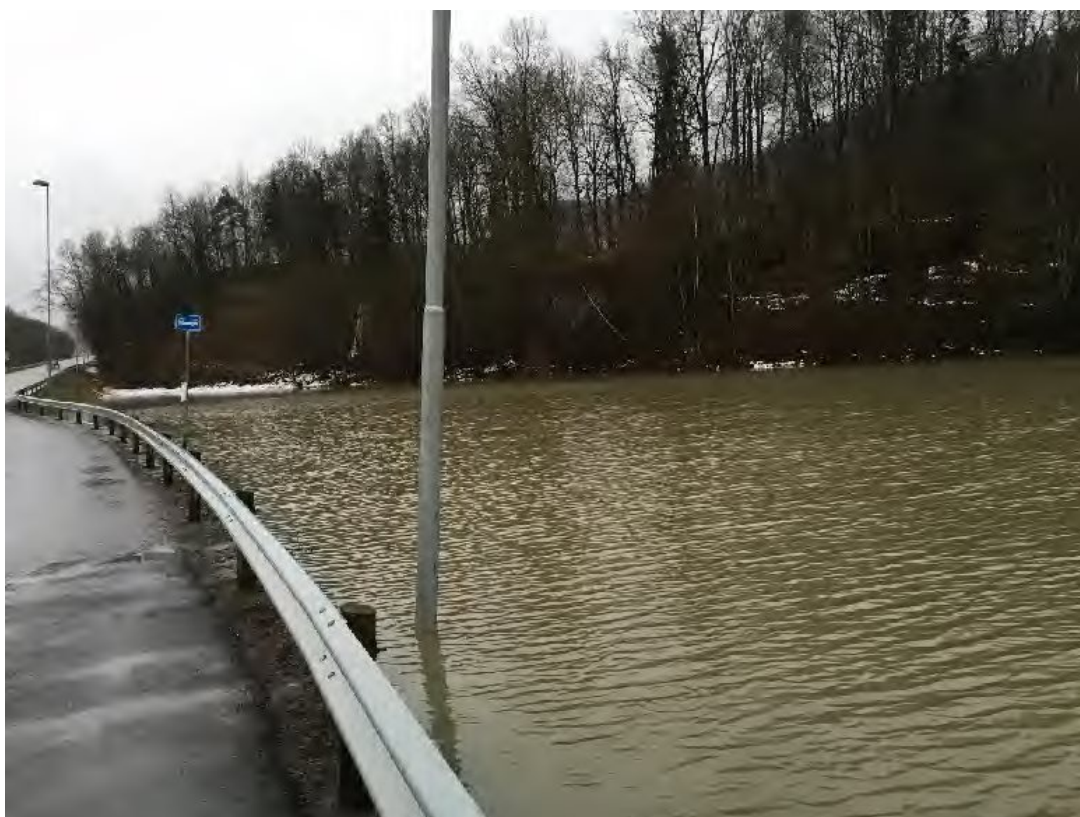
Skjervikbekken sør fv.313 til venstre i bildet, flom 8.2.2016 vannføring ukjent
