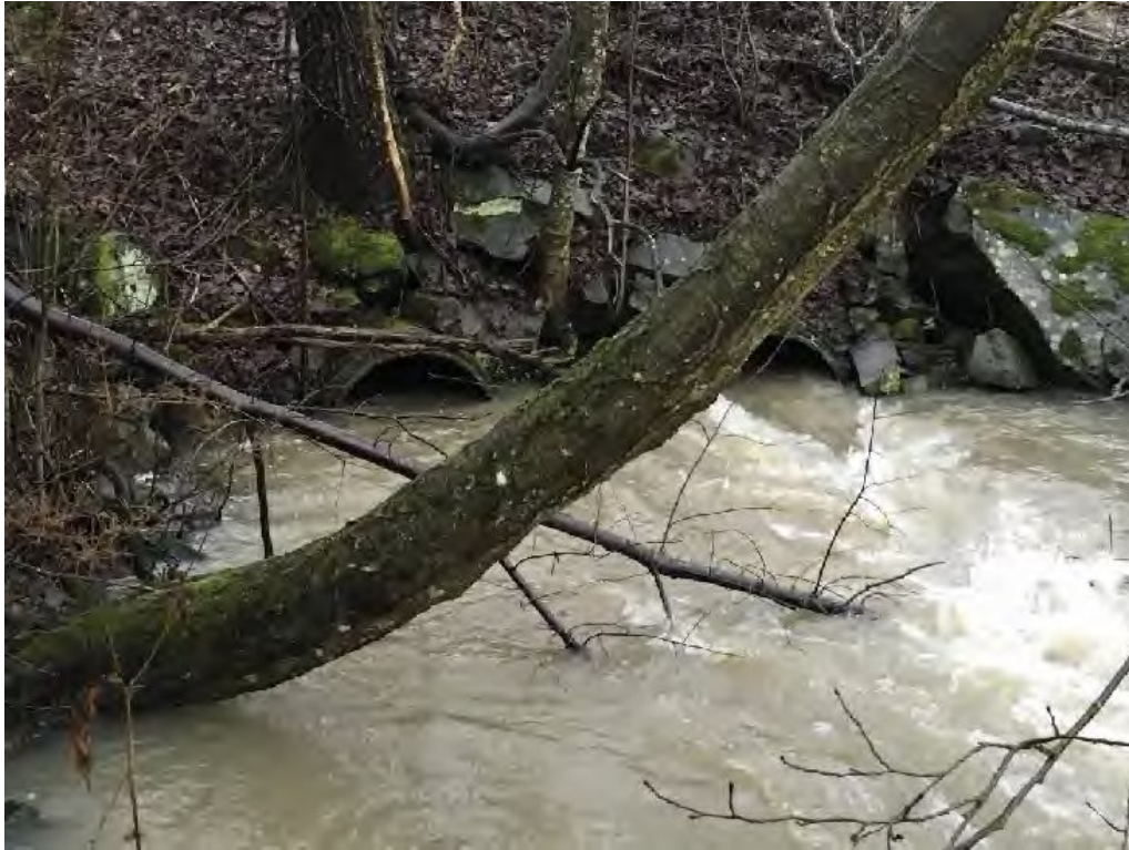
Utløp fra kulvert under fv. 313 fra Skjervikbekken (høyre kulvert) og Skkjervikbekken sør (venstre kulvert), flom 8.2.2016 vannføring ukjent
