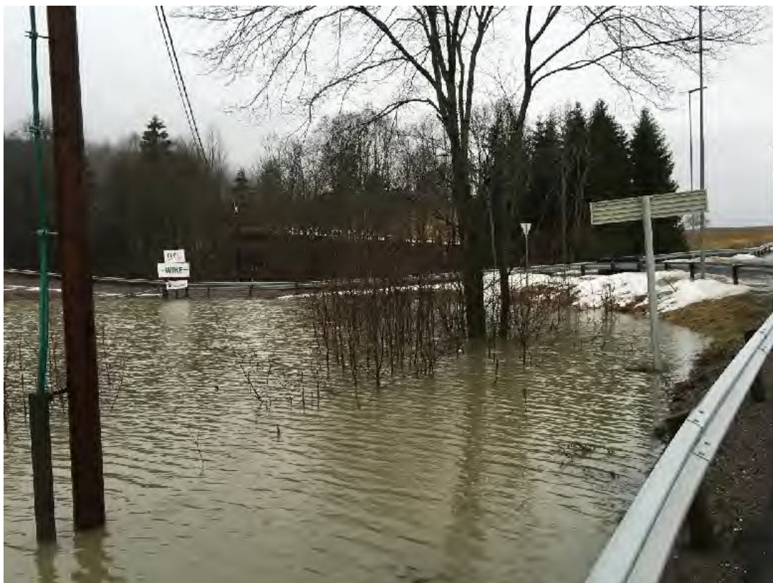
Skjervikbekken sør, fv.313 til høyre i bildet, anleggsveien til jernbanen i bakgrunnen, flom 8.2.2016 vannføring ukjent
