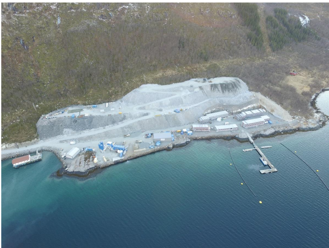
Figur 8 Smibelg anlegg med tipp og brakkerigg
