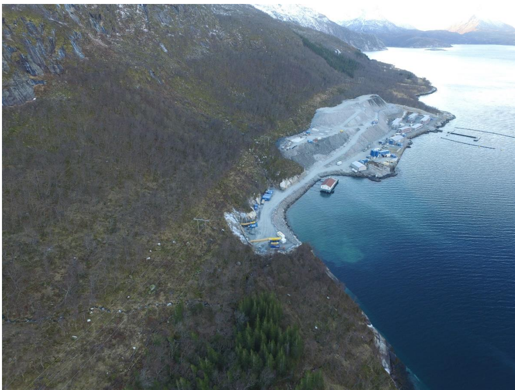
Figur 7 Smibelg kraftverk med tipp
