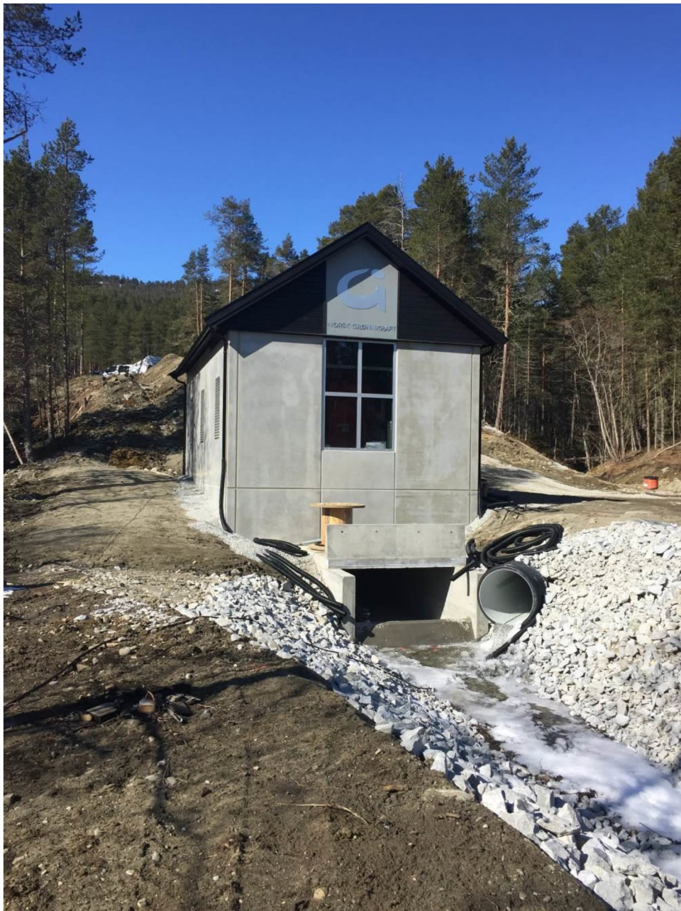
Figur 14 Eksempel på kraftstasjon fra NGK Utbygging. (Kvernåi kraftverk, Lesja, 2017)
