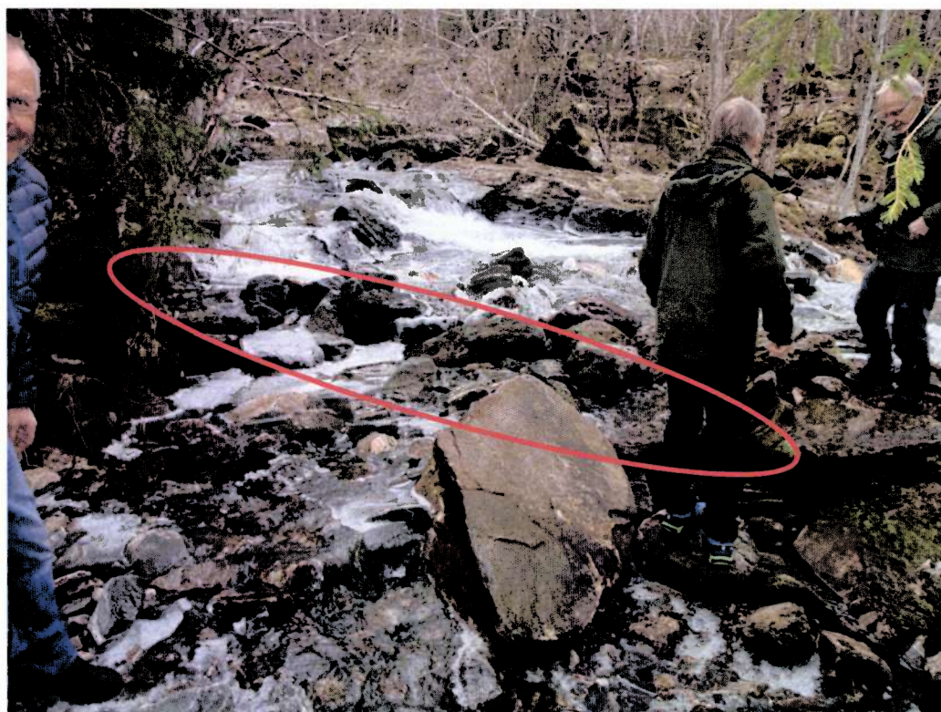
Elvedele kote 78, øverst. Stein er lagt ut for å få vann i sørvestre løp. Planlagt terskel vist med rød ellipse
