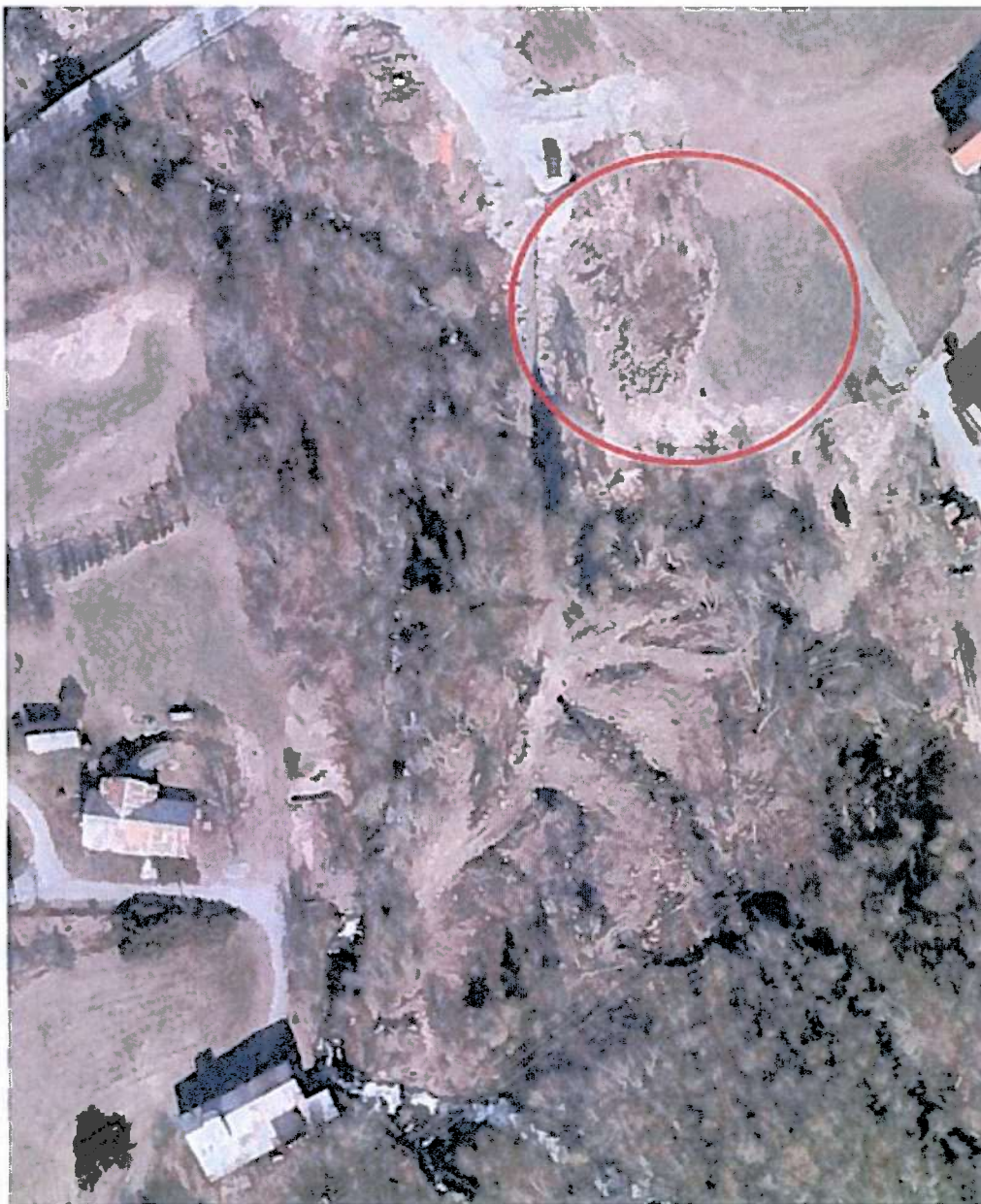
Figur 3-6 Flyfoto fra tiltaksområdet fra 2014. Hele området er betydelig påvirket. I dag står i tillegg kraftstasjonen til Herje kraftverk i området vist med rød sirkel.
