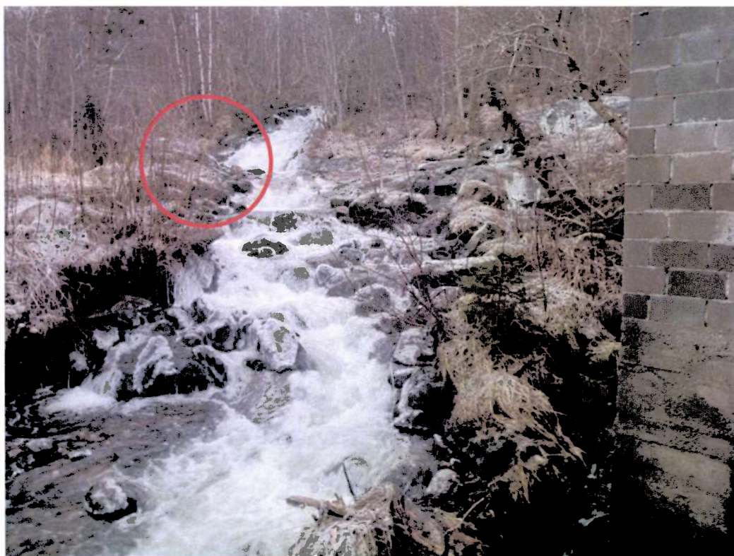
Nytt inntakssted. Gammel kraftst. til høyre. Fjell i dagen i elva, løsmasser på sidene
