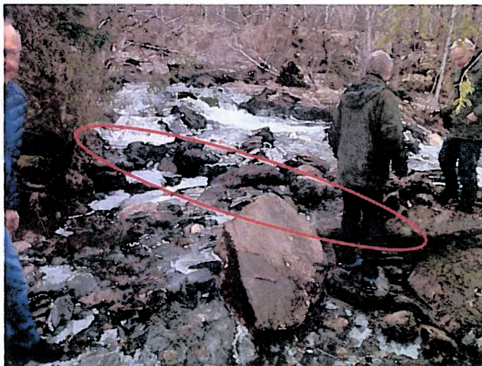
Figur 2-9 Elvedele 78 moh., overst. Stein er lagt ut for å få vann i sørvestre løp vist ved rød ellipse. Her bygges det en terskel.
