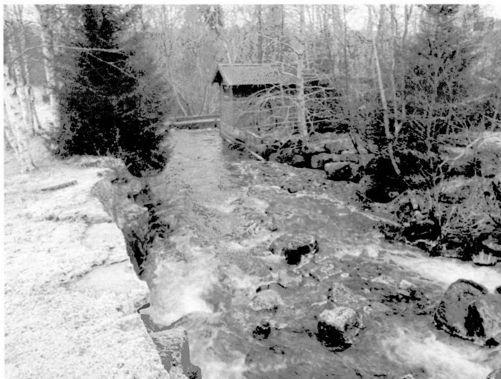
Dagens inntaksdam. Flomsikringsmur til venstre (og høyre)
