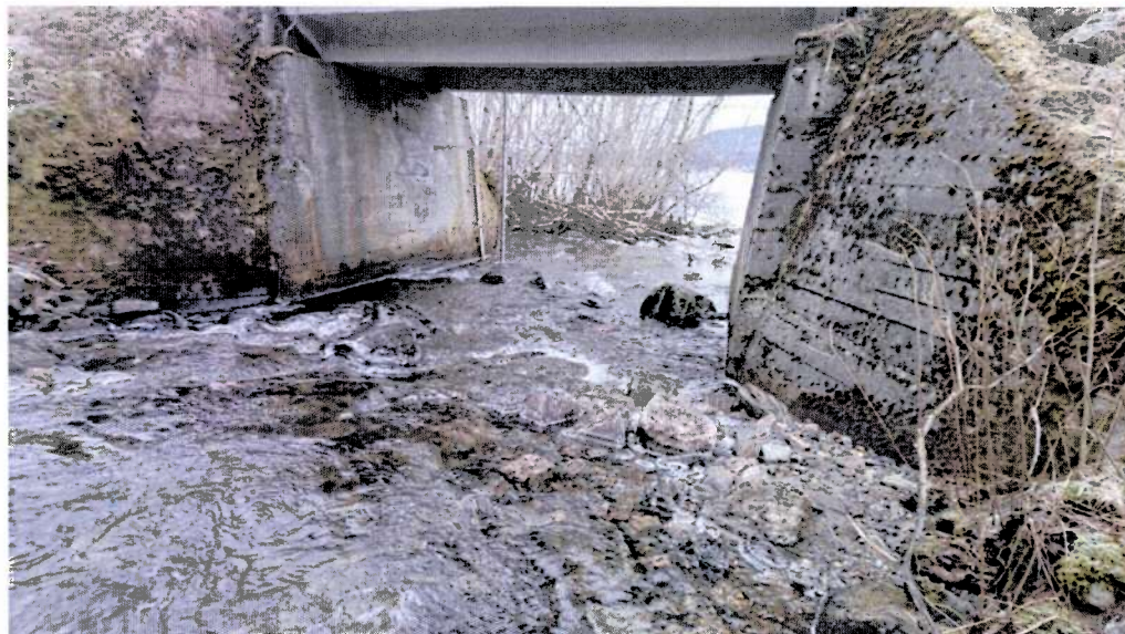
Kulvert under fylkesvei 660
