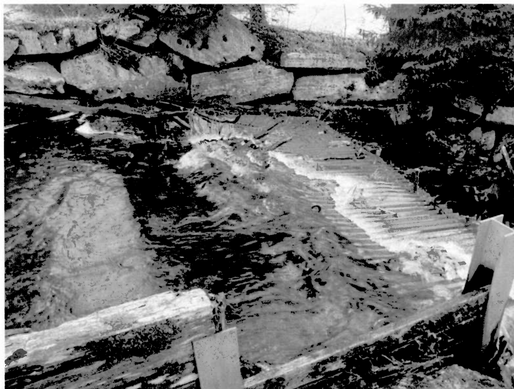
Dagens inntaksdam med fiskesperre. Utsatt flomsikringsmur
