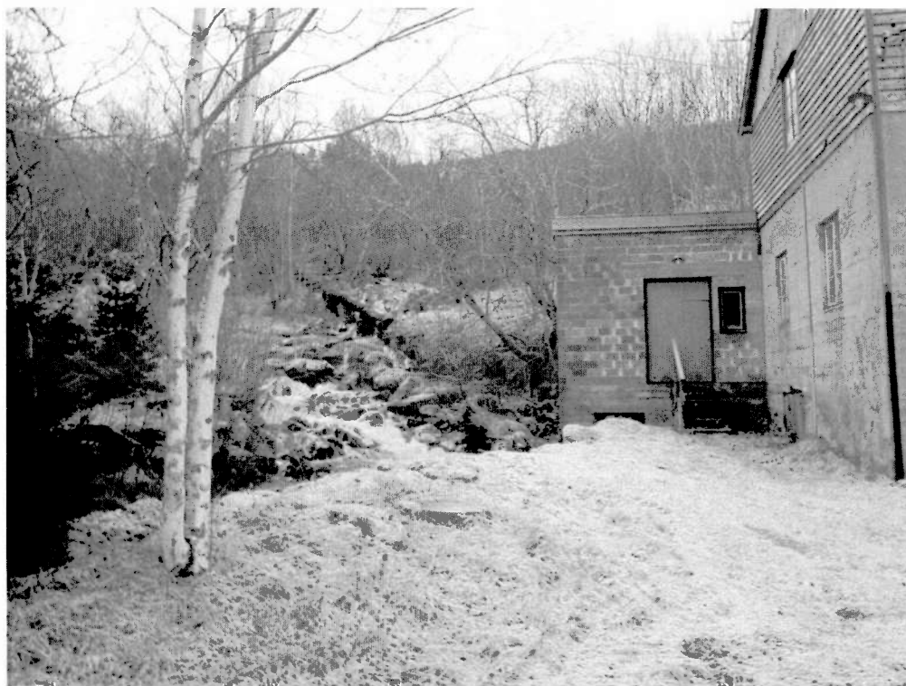
Herjeelva oppstrøms dagens inntaksdam. Gml. kraftstasjon (grønn dør)
