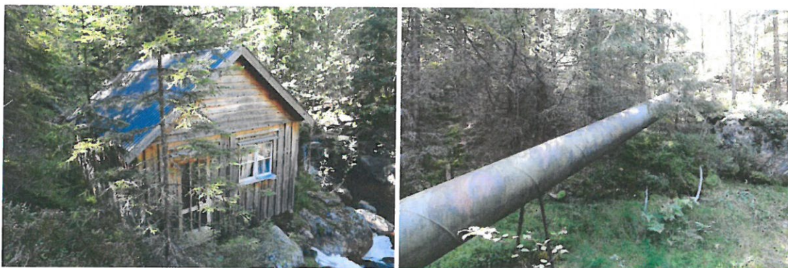
Figur 13. Fjone kraftverk. Foto Helge Kiland.
