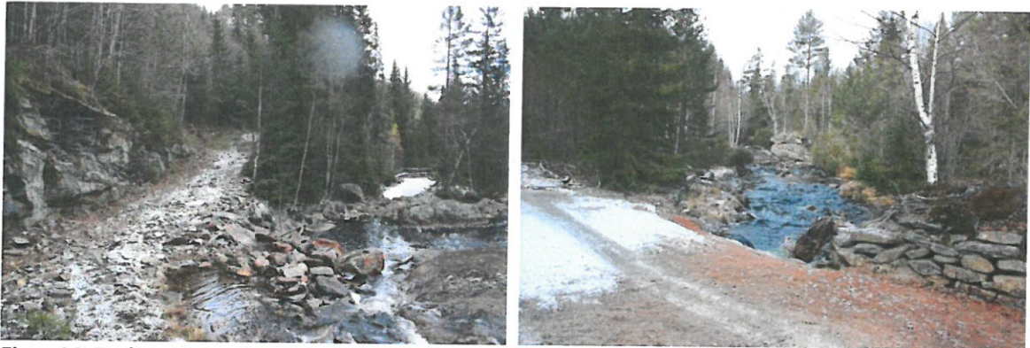
Figur 14. Traktorveg ned til elva ovanfor eksisterande kraftverksinntak og lågbru der vegen til Åkre kryssar elva. Foto Anne Nylend.
