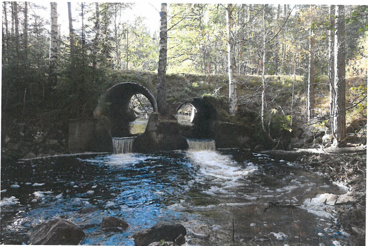
Figur 1. Røra under Fjonevegen. Røret til høgre ligg ca 40 cm over vassflata ved den aktuelle vassføringa.
