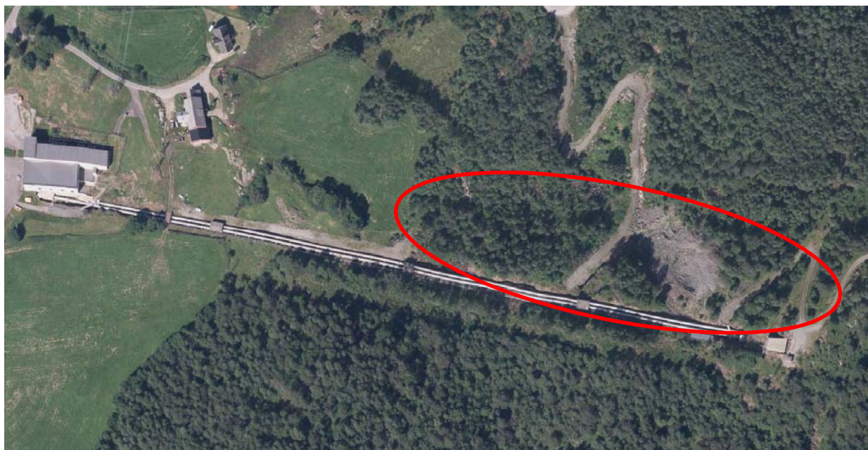
Figur 5: Den store bygningen til venstre er Litledalen kraftverk og Litledalen koblingsstasjon. Kabelen legges herfra på nordsiden langs eksisterende rørgate. Kabelen legges videre i veien som svinger ut på høyre side av bildet. Det merkede området er befart med hensyn på naturmangfold. Nedenfor (sør for) rørgaten er traseen til eksisterende 11 kV linje godt synlig. Traseen til 66 kV linjene kan skimtes kryssende nord i det avmerkede området.
