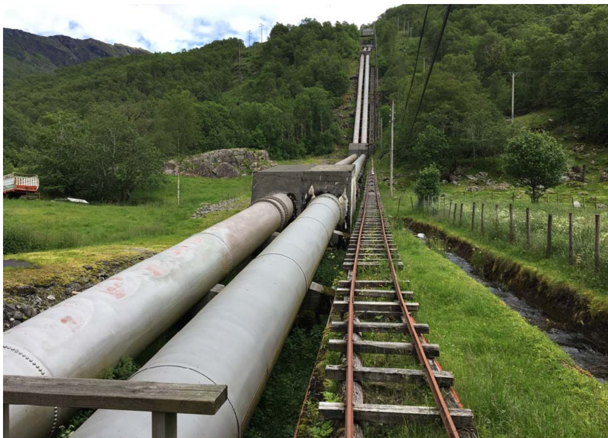
Figur 6: Kabelen foreslås lagt på venstre side oppover langs rørgaten. Til venstre i skråningen vises de to 66 kV linjene som er foreslått fjernet, mens til høyre går 11 kV linjen som også foreslås fjernet.
