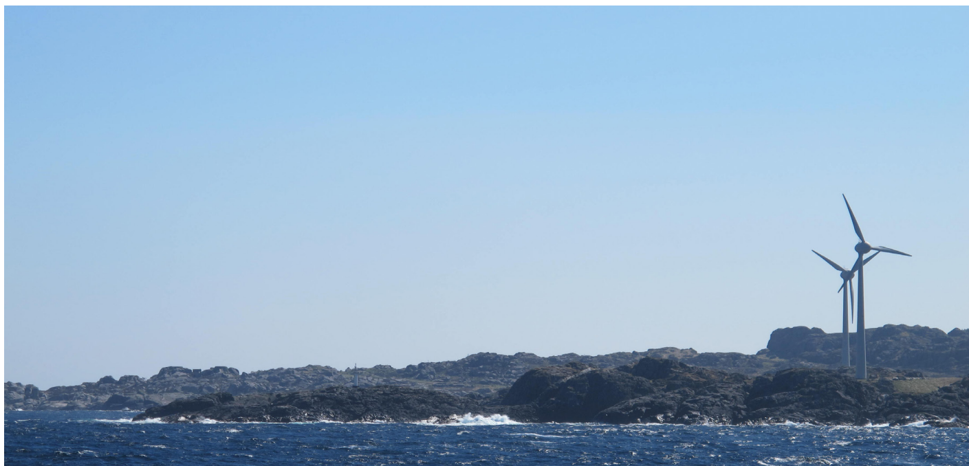
Figur 2: Utsira idag - 2 turbiner tilsammen 1,2 MW. Dekker stort sett Utsira sitt forbruk. Navhøyde 45 og diameter 40 meter.
