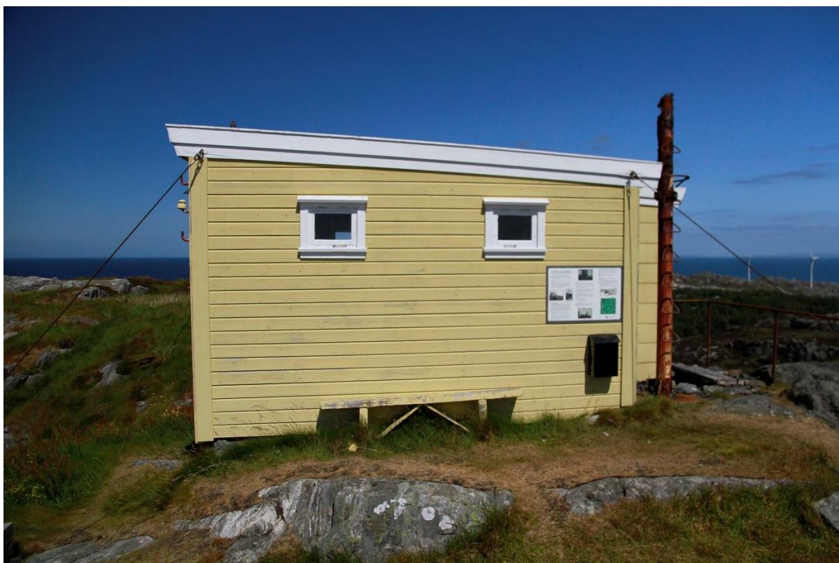
Fig. 30. Loshytta på Børge, sett mot nord. Dagens 2 vindturbiner kan sees helt til høyre i bildet. 26. juni 2014. Foto: A. Håland©.
