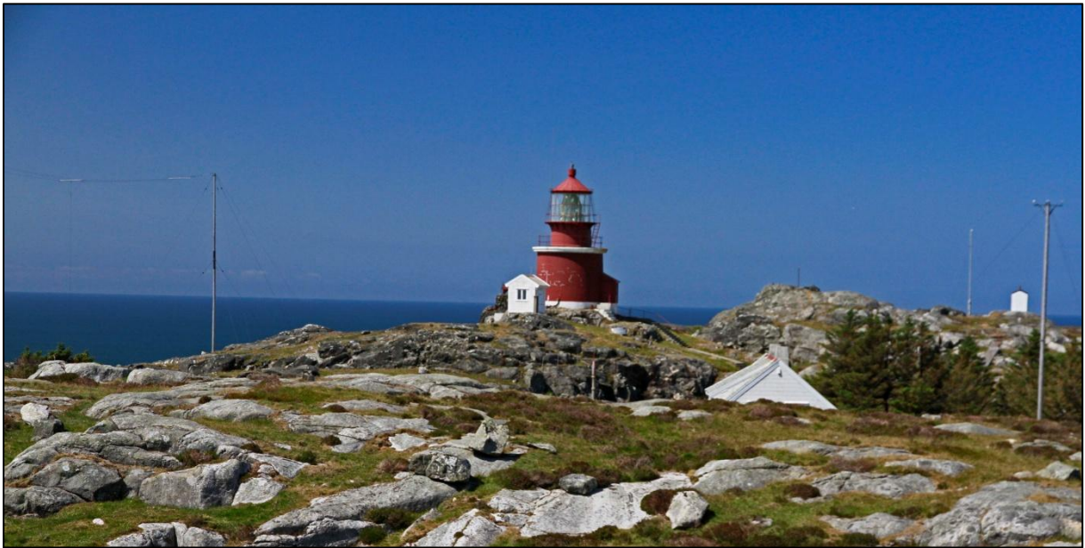
Fig. 18. Utsira fyr sett mot NV. 25. juni 2014. Foto: A. Håland.
