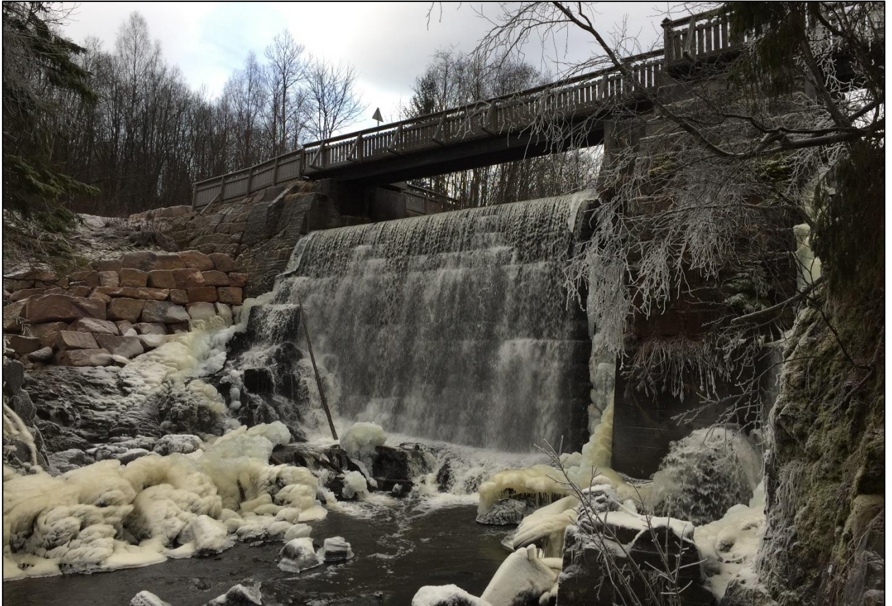
Figur 1-4 Bildet viser dammen sett nedstrøms. Foto: Multiconsult
