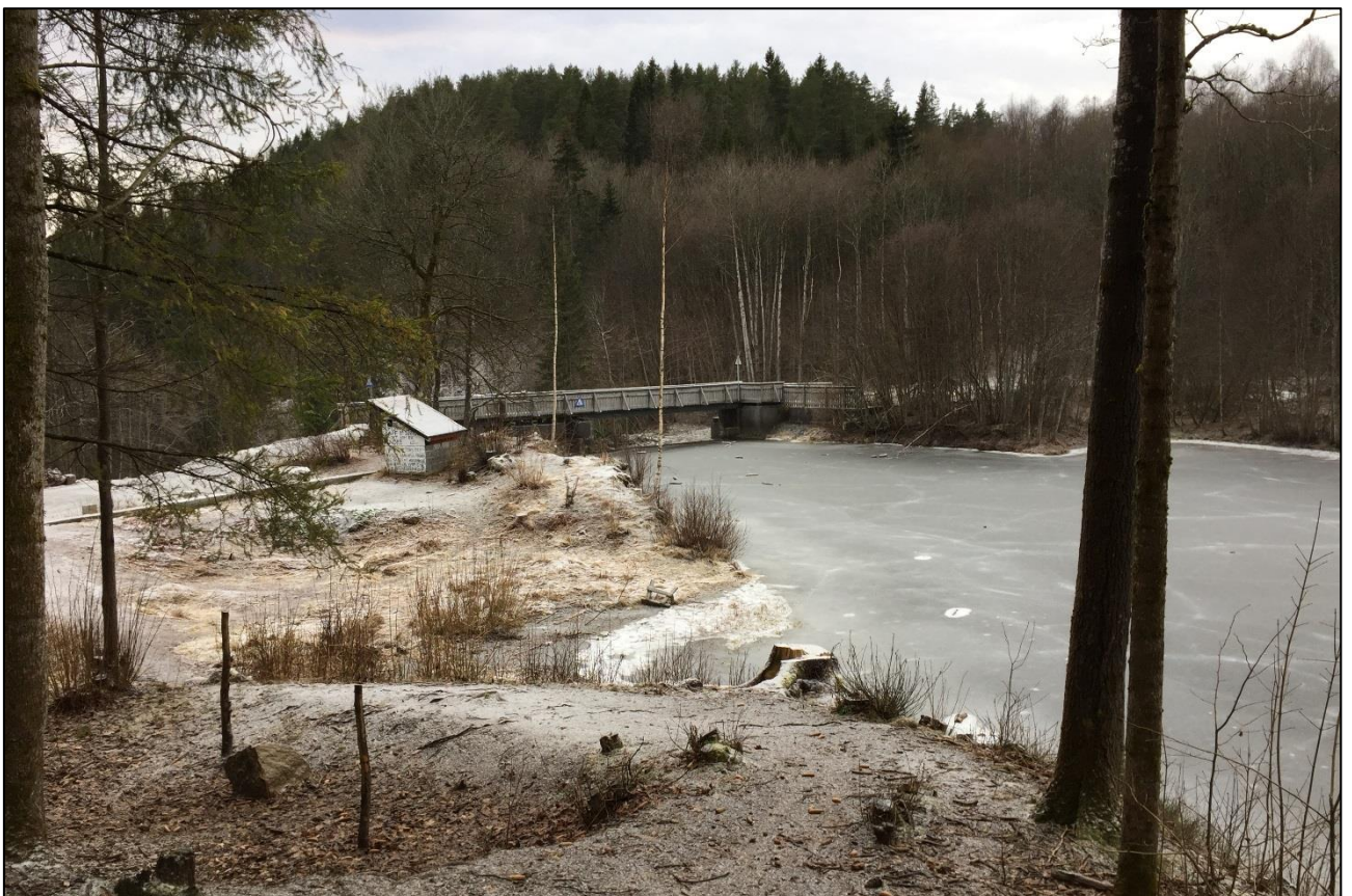
Figur 1-5 Bildet viser dammen sett fra oppstrøms side. Foto: Multiconsult.
