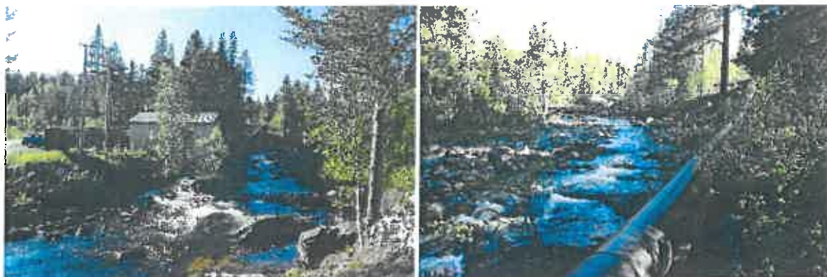
Figur 14. Gjøv kraftstasjon med rørgate.
