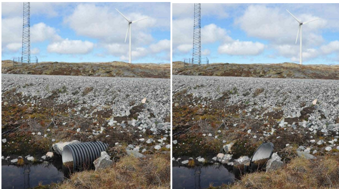
Figur 14. Stikkrenner plasseres ved tidligere vannveier og tilpasses sideterreng.
