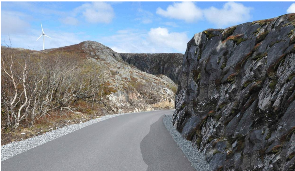
Figur 10. Manipulert bilde viser en tosidig skjæring der det ikke er gjort tiltak for å dempe den visuelle virkningen av skjæringen til høyre i bildet.
