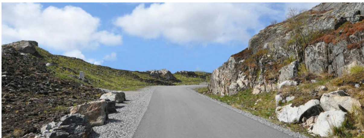
Figur 16. Ved behov for ekstra masser tas positive former ut i sin helhet. I det manipulererte bildet under er en større gjenstående knaus etter innføring av atkomstveg benyttet, samtidig som man har tatt toppen av skjæringa på motsatt side. Mindre knauser har fått stå igjen for variasjon og en mer naturlig flate.
