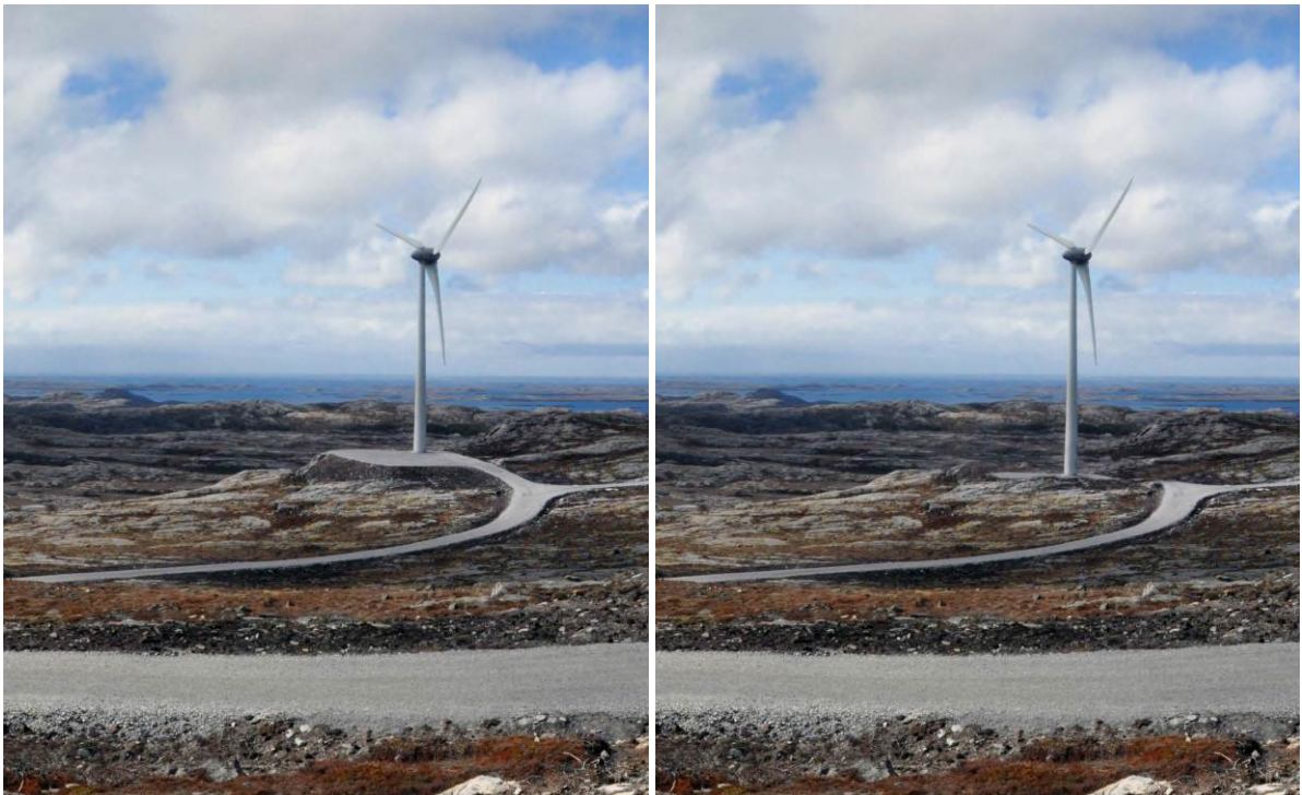
Figur 21 Minst mulig eksponering av kranoppstillingsplass og fundament er viktig for god landskapstilpassning, her vist ved senking av oppstillingsplass slik at utstrakte fyllinger unngås og gjenstående knauser delvis skjerner for innsyn.
