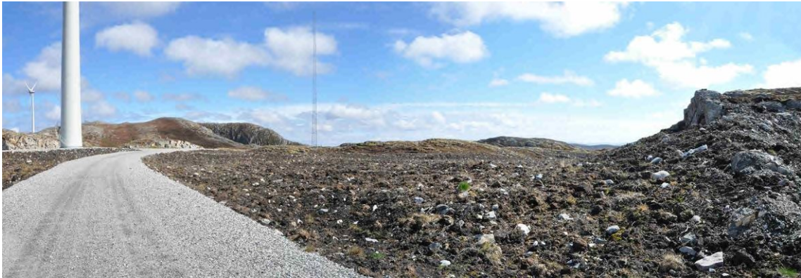
Figur 3 Istandsatt massetak har fått ei overflate som går fint til tilliggende terreng, men flata er noe stor og ensarta til at den visuelt aksepteres som en naturlig formasjon i det småkuperte terrenget.
