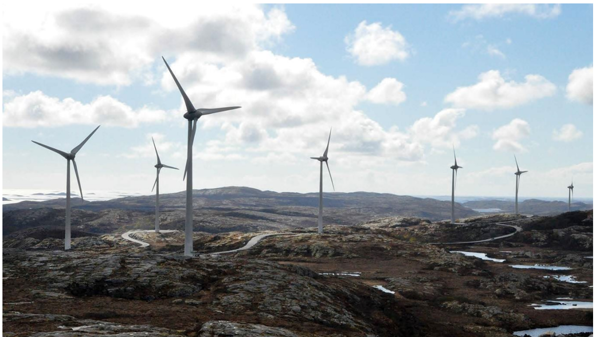
Figur 9. Bildet viser hvordan et godt tilpasset vegnett slynger seg med terrenget.
