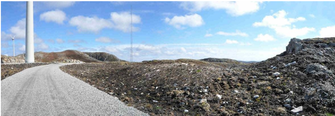
Figur 4 Fotomanipulert bilde viser at en mindre overhøyde på deler av arrondert terreng kan være alt som skal til for et mer naturlikt landskapsbilde
