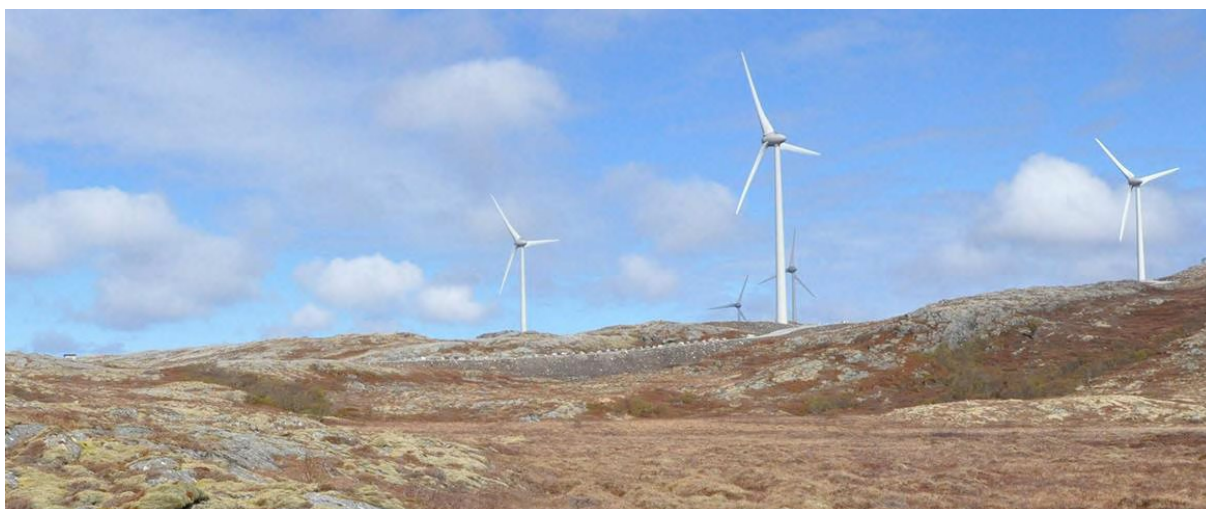
Figur 6 Jordfargen på vegskråningen skiller seg noe ut fra tilliggende terreng, men vil på sikt bli lite synlig med reetablert lyng og mose som på tilliggende areal.
