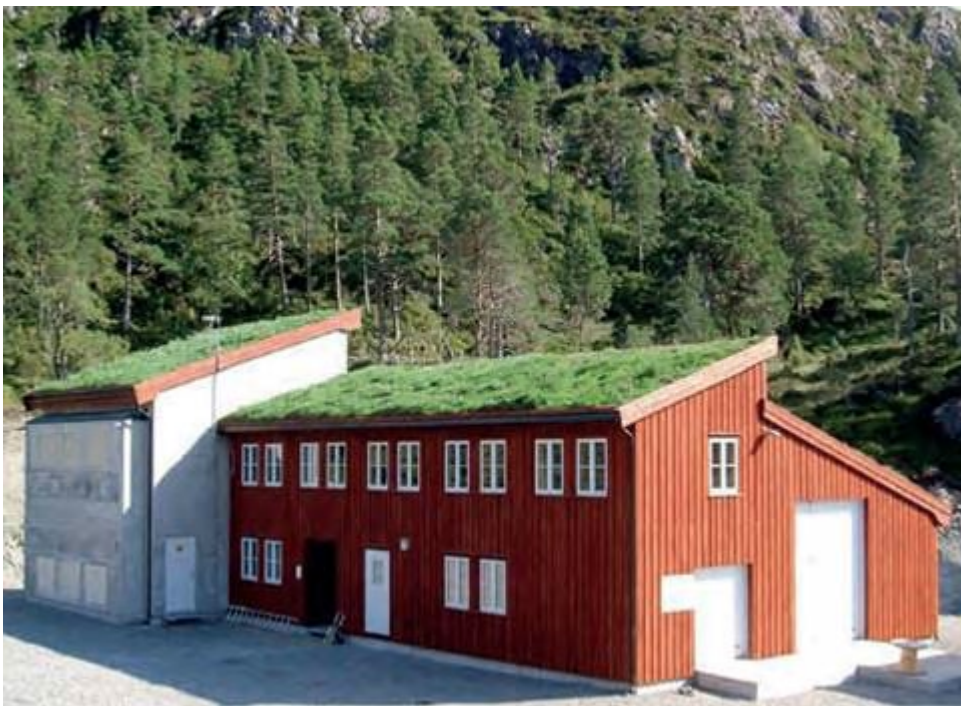
Figur 4: Eksisterende trafostasjon og driftsbygning for Hitra vindkraftverk.
