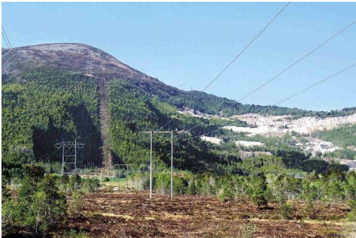
Figur 19 Bildet viser parallellføring av to ledningstraseer, der linja til venstre i bildet har begrensa skogrydding og er langt mindre synlig enn linja til høyre. (Foto: Statnett)
