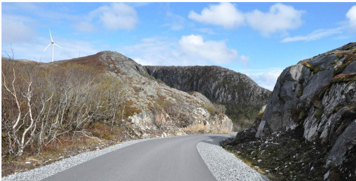
Figur 11. Dersom vegen må føres gjennom fjellparti og tosidige skjæringer ikke kan unngås, er det viktig at det settes av nok plass til at tverrsnittet føles romslig og skjæringene kan bearbeides i bunn og topp for å minske deres visuelle høyde og myke opp profilet. (Orginalbilde fra asfaltert adkomstveg til vindkraftverket på Ytter Vikna.)
