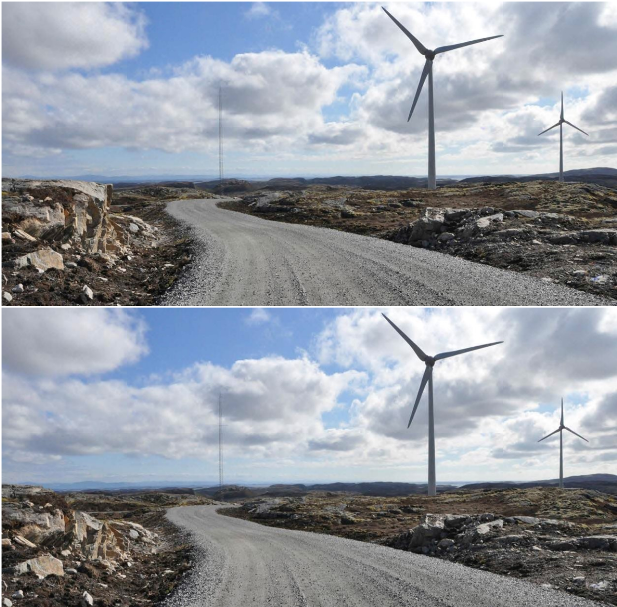
Figur 13. En mindre skjæring står igjen på venstre sida av vegen. Mindre pigging i toppen, som vist på manipulert bilde nederst, er alt som skal til for at oppstikkende nabber på begge sider av vegen skal bli mindre påfallende.
