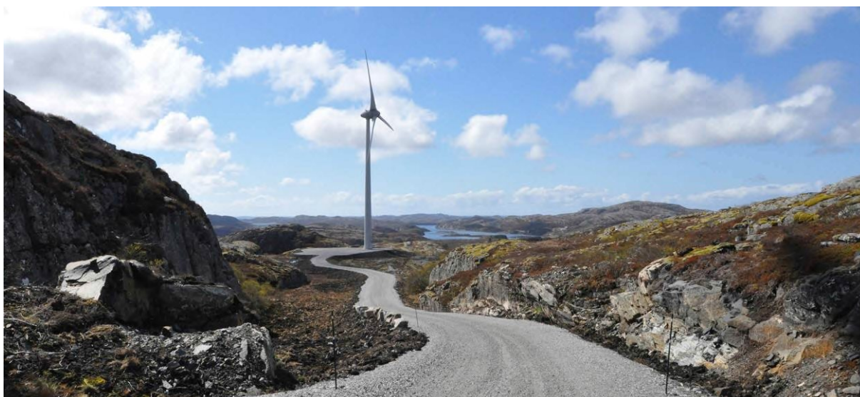
Figur 7. Dersom vegen ikke forankres i eksisterende terrengformer, men blir liggende med tosidig skjæring eller fylling vil den bli mer markant i landskapsbildet, som her hvor vegen blir liggende med tosidig fylling i et lokalt lavpunkt.
