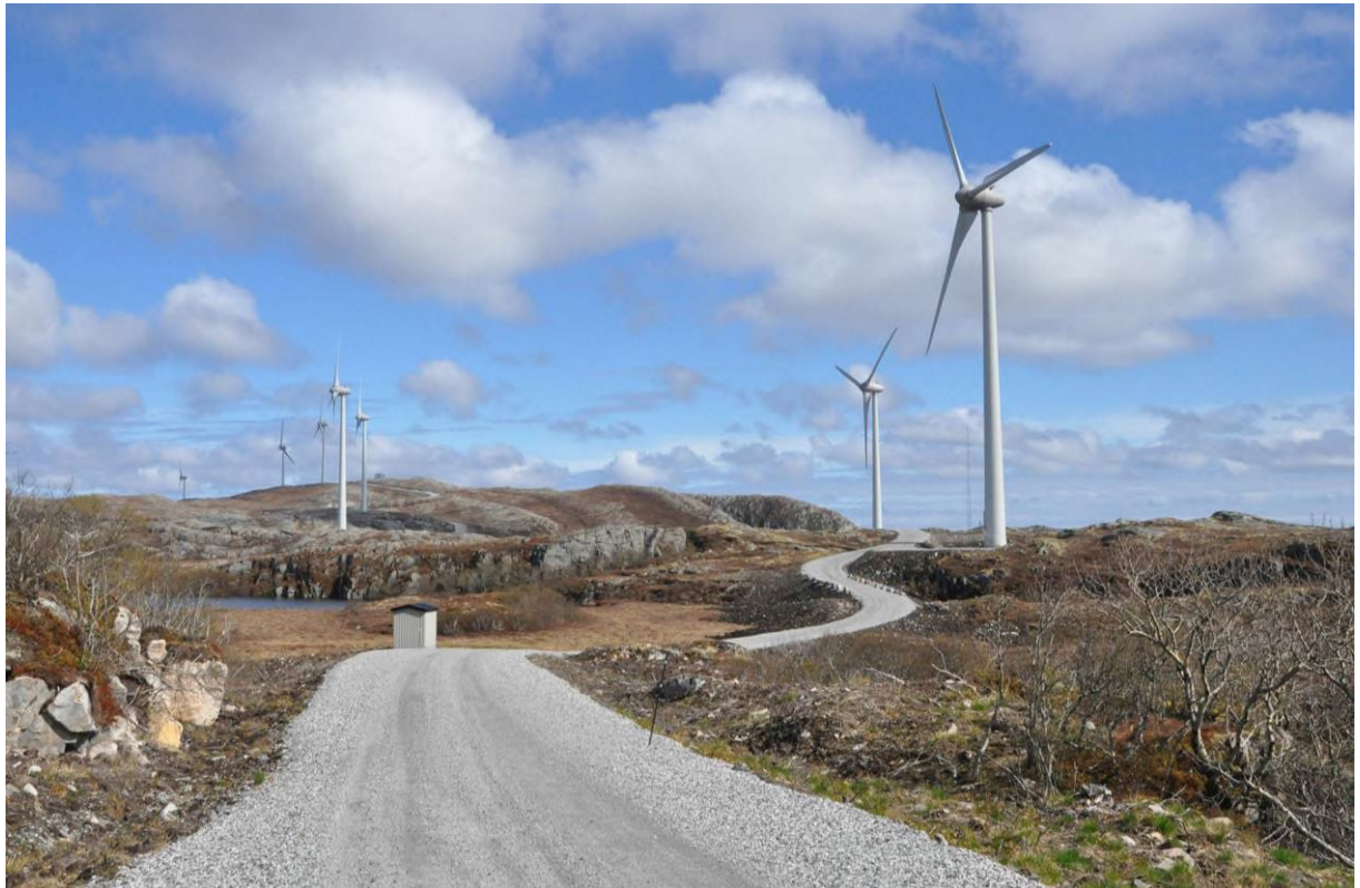
Figur 8 I det småkuperte landskapet er økt veglengde å foretrekke foran skjæringer i tillegg kan traseen med fordel legges med litt høyde i terrenget, da fyllinger i prinsippet lettere kan gis en naturlig tilpassing enn skjæringer.
