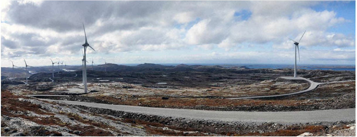
Figur 20. Panoramabildet viser kranoppstillingsplasser som generelt ligger godt i terrenget, med unntak av den ved vindturbinen til høyre i bildet som ligger noe høyt og blir dertil eksponert.
