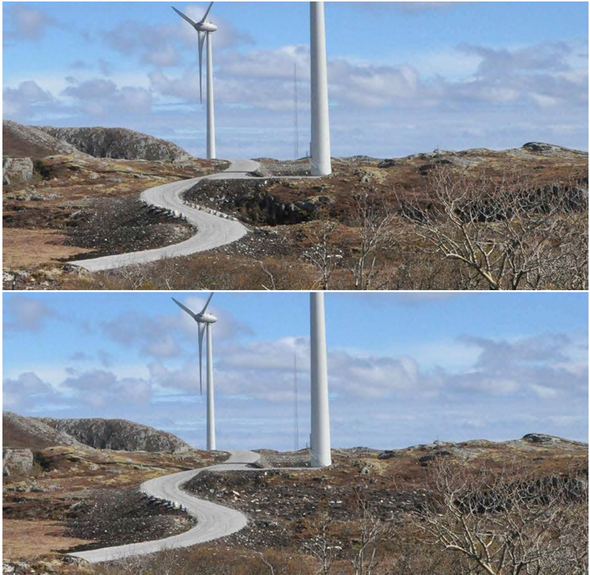
Figur 17. I det fotomanipulerte eksemplet er det fylt igjen masser i et dalsøkk foran fremre turbin. Her ville dette samtidig gitt vegen en bedre forankring i landskapet ved å unngå fyllingsskråning på begge sider av vegen og kranoppstillingsplassfor turbinen blir mindre ruvende.
