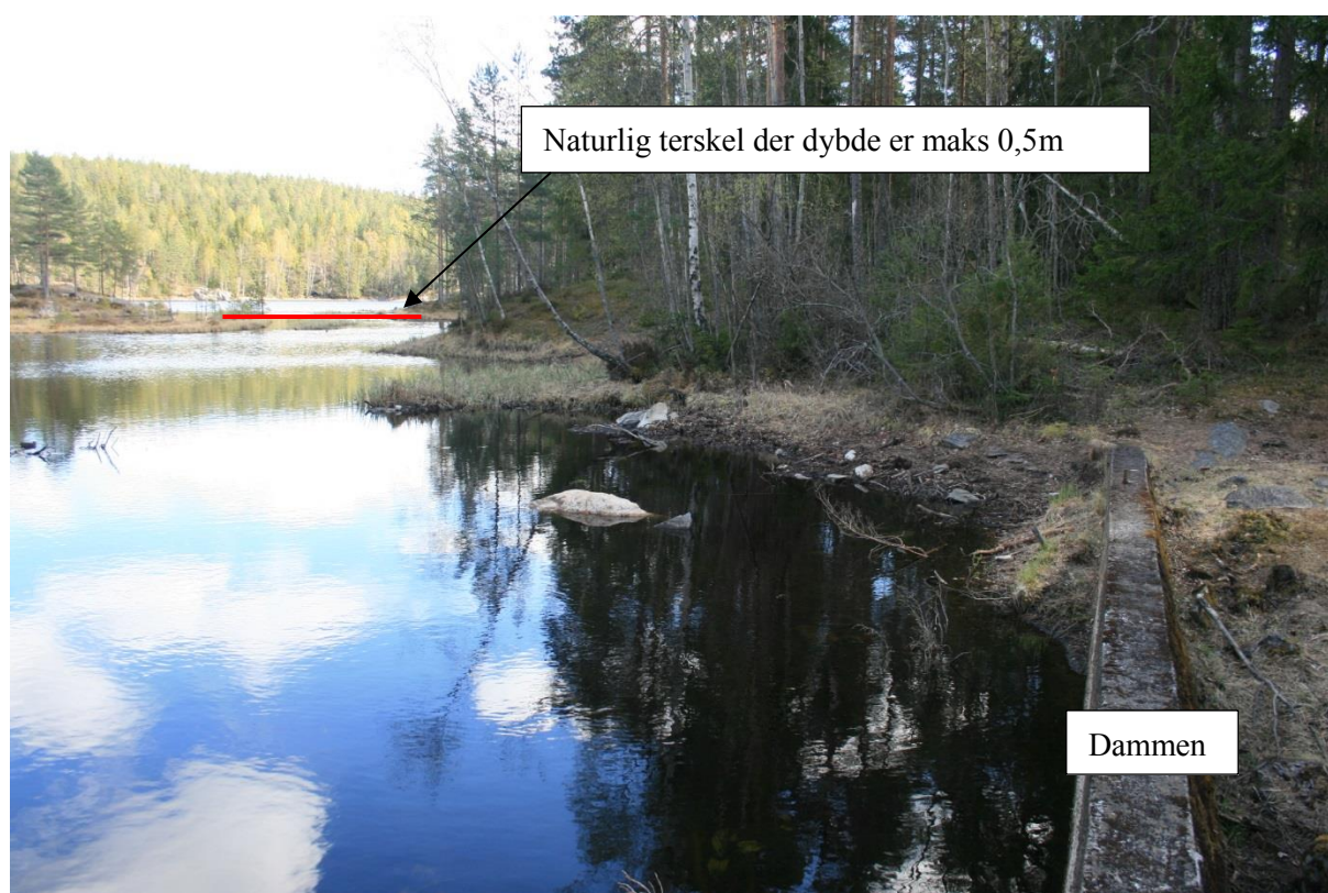
Figur 1-3. Dam Abortjern med naturlig terskel.
