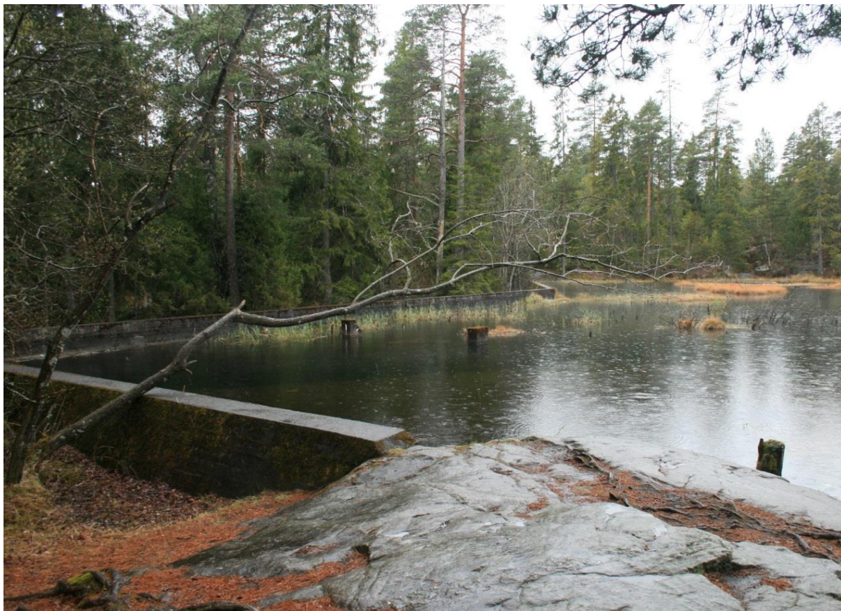
Figur 1-4. Dam Tientjern sett fra østside.
