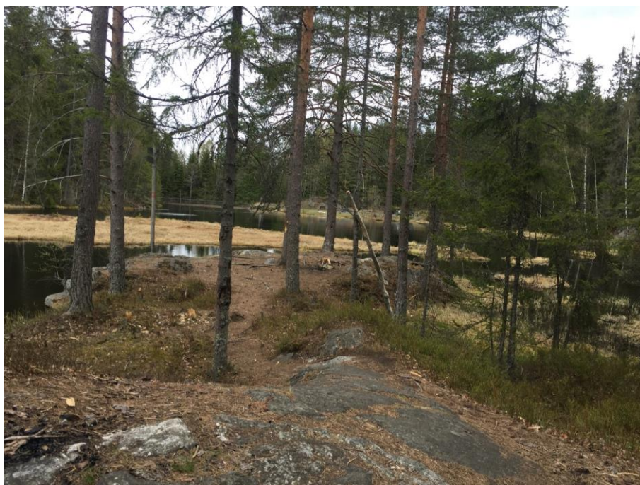
Figur 3-2. Dam Østbyputten (Bilde tatt under befaring 9. mai 2017).
