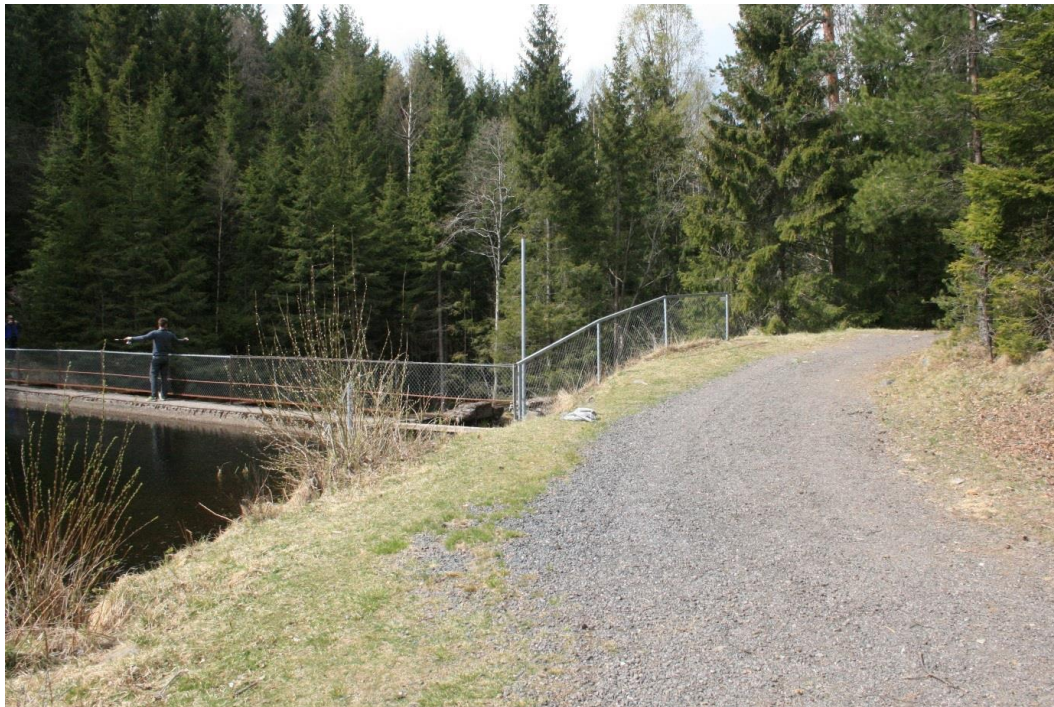
Figur 2-2. Anleggsveien er nylig oppgradert og gruset.
