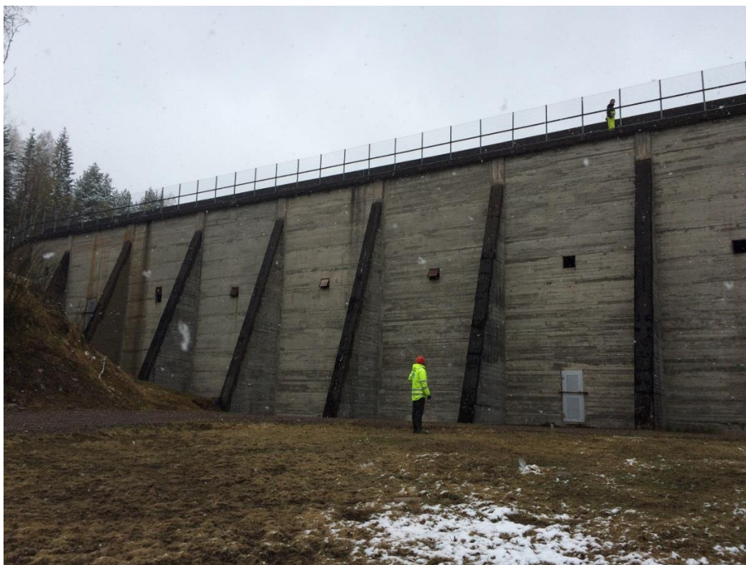
Figur 1-4. Vestre dam, platedammen, sett fra luftsiden.
