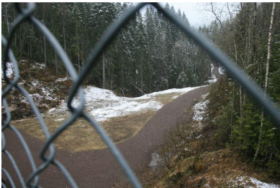
Figur 2-3. Kjøreadkomst til luftsiden av vestre dam (Bildet tatt fra damkrone).
