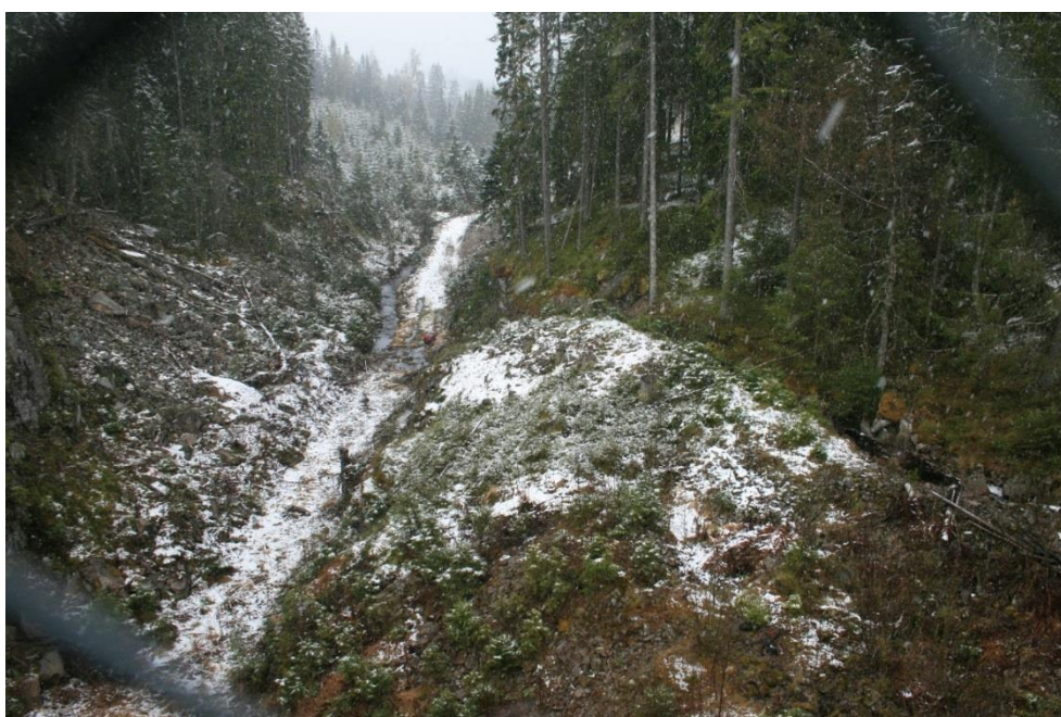
Figur 2-4. Mulighet for oppgradering av gammel anleggsvei nedstrøms østre dam (bildet tatt fra damkrone).
