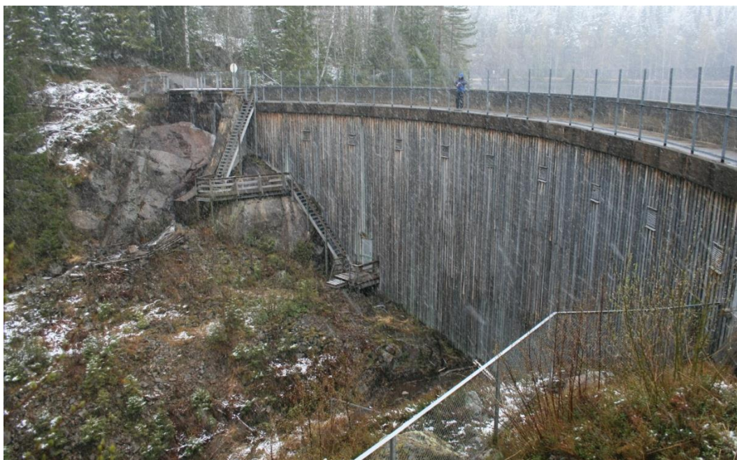
Figur 1-3. Hoveddam sett fra luftsiden.
