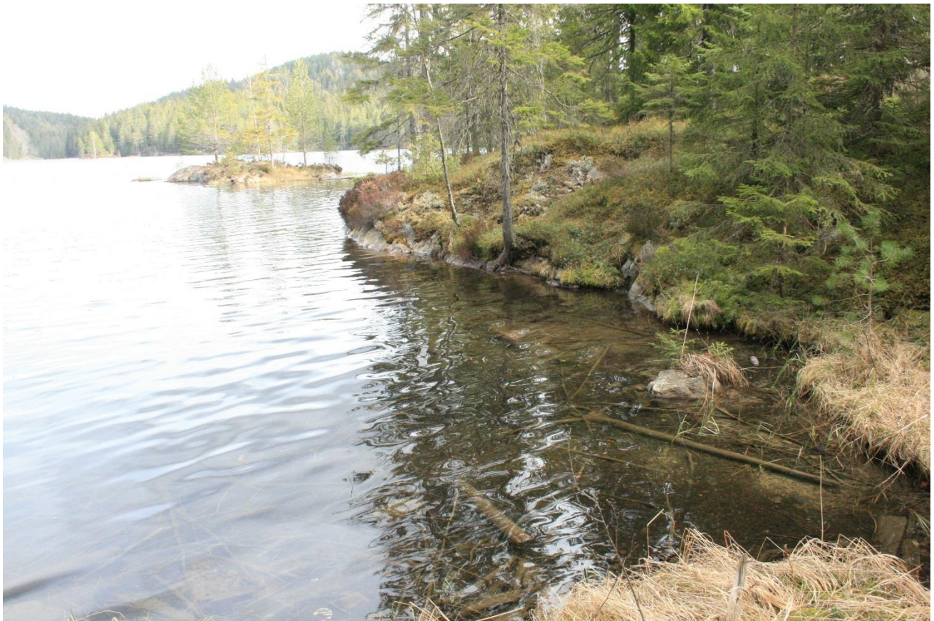
Foto 9 Bildet viser noe lav vannstand pga. lekkasjer ved alle tre dammer og begrenset tilsig (Erath, mai 2017).
