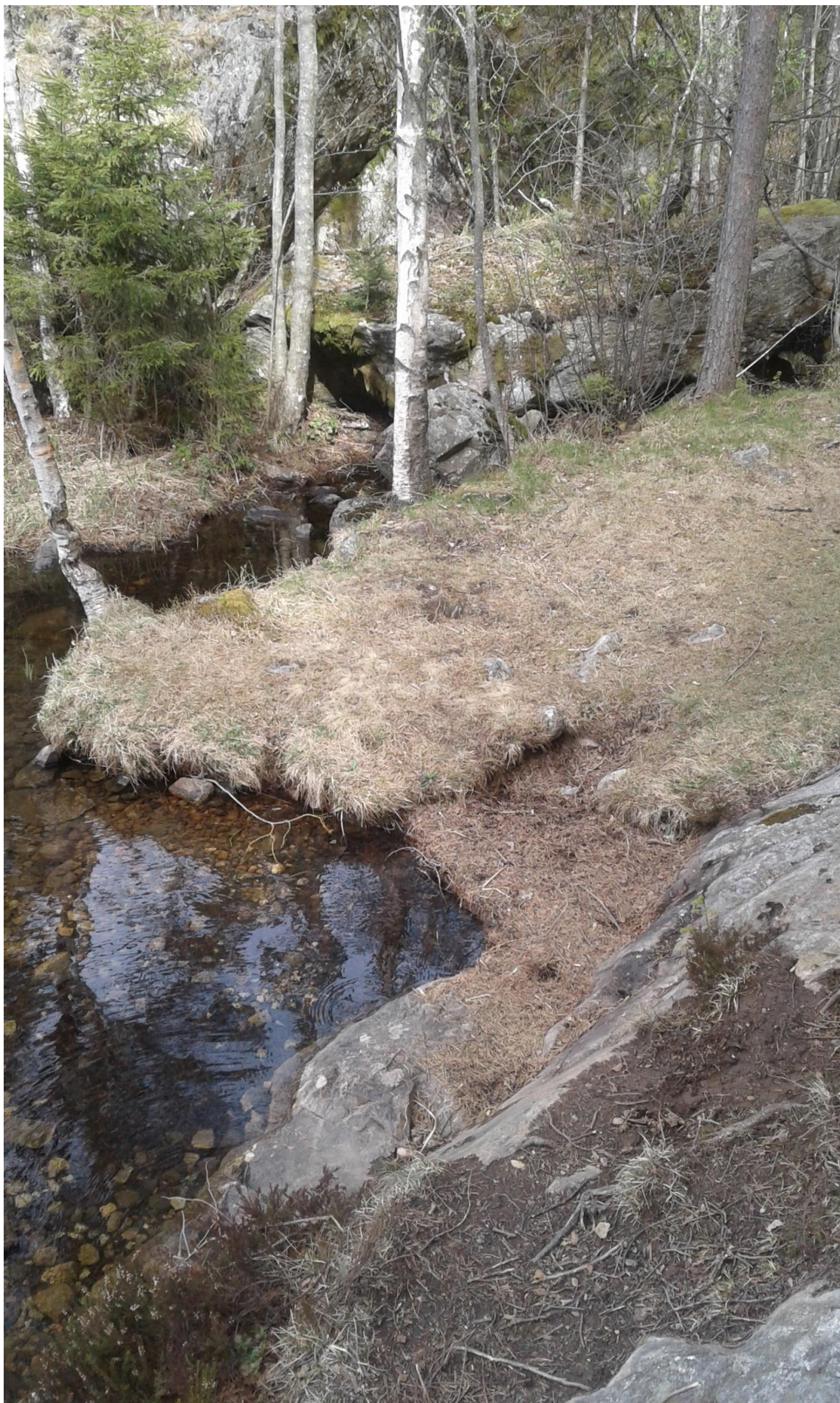
Foto 54. Bekken ved skiløypen i vest. Mulig tilførsel for tørrlagt bekkedal bak sperredam (Kjærås, mai 2017).
