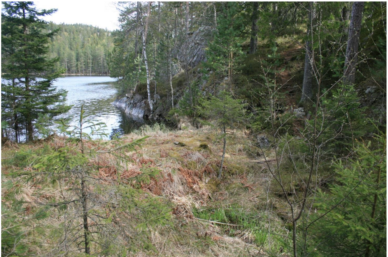
Foto 31. Nyoppdaget, ukjent dam. Har lekkasje (Erath, mai 2017).
