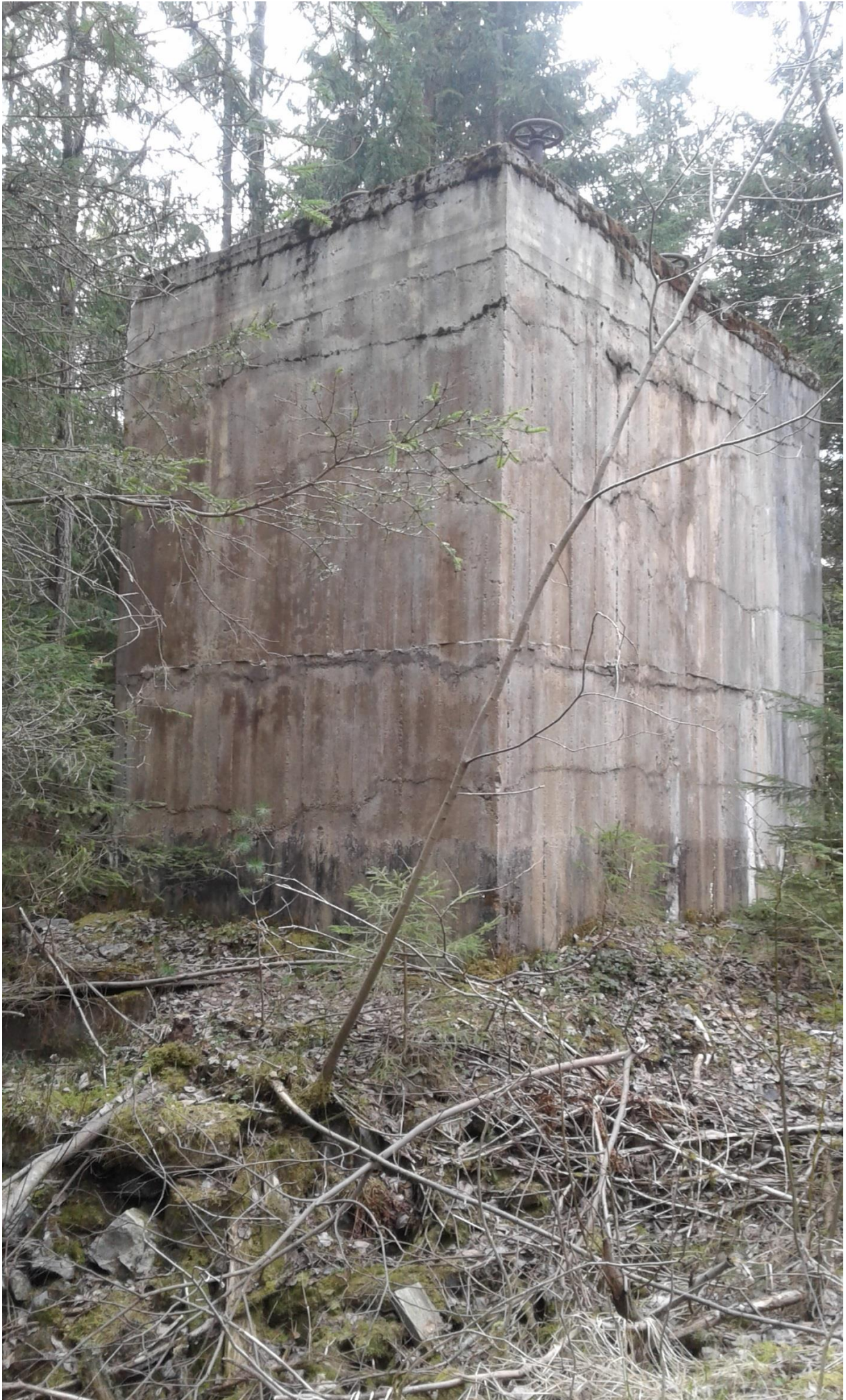
Foto 40. Ventilammer (Kjærås, mai 2017).
