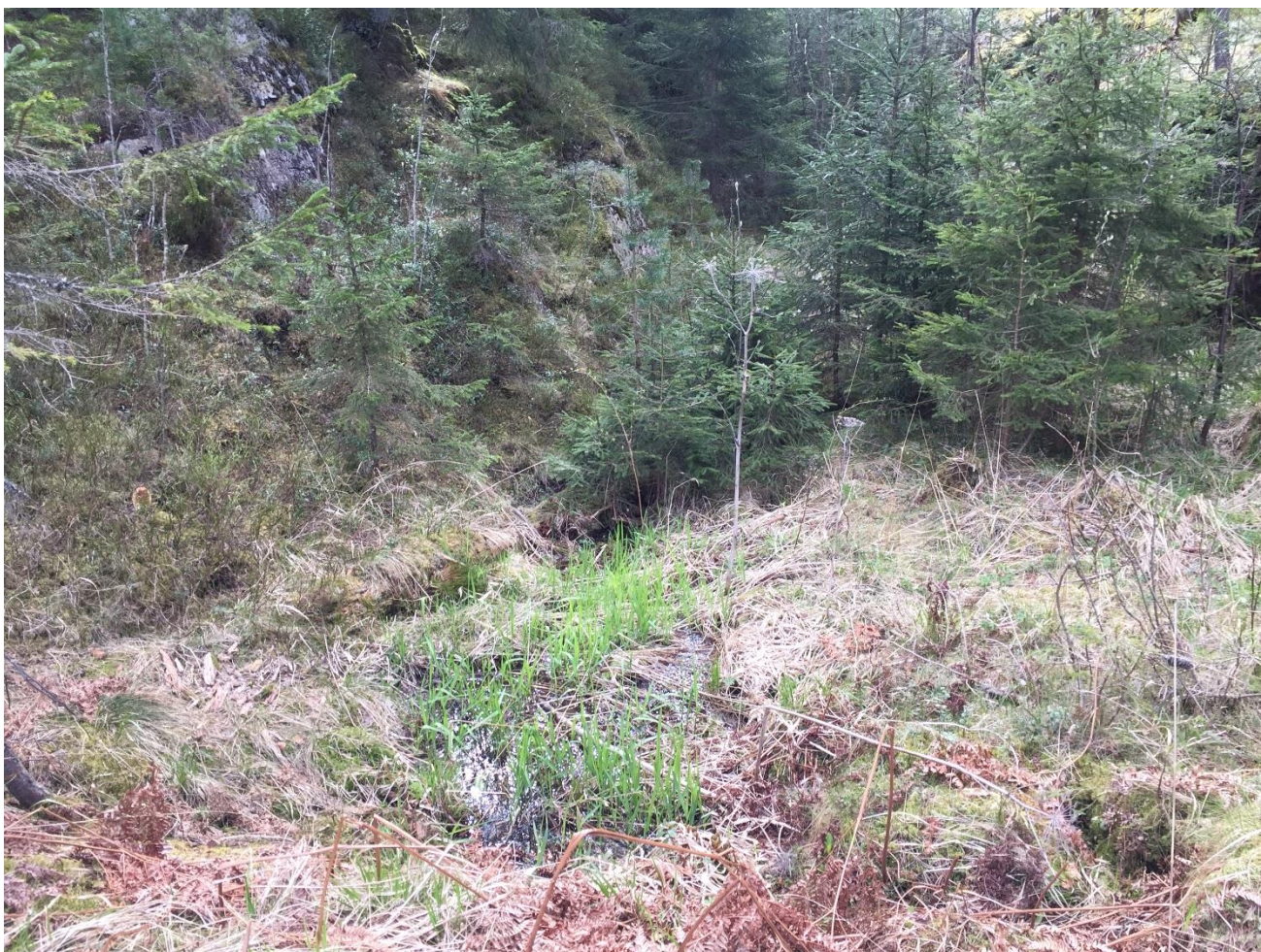
Foto 34. Lekkasje (Amland, mai 2017).
