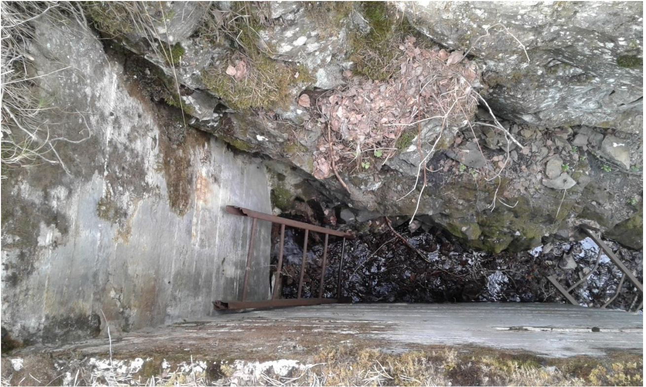
Foto 22. Siden av sperredam (Kjærås, mai 2017).
