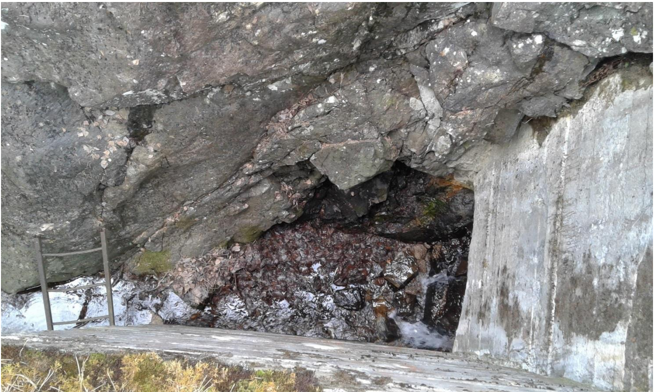
Foto 23. Siden av sperredam (Kjærås, mai 2017).
