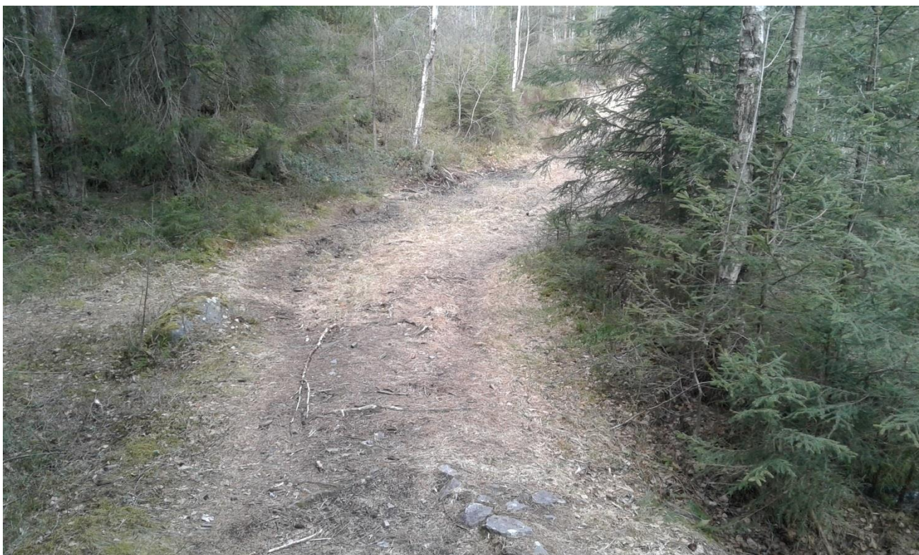
Foto 48. Vei nedenfor sperredam (Kjærås, mai 2017).
