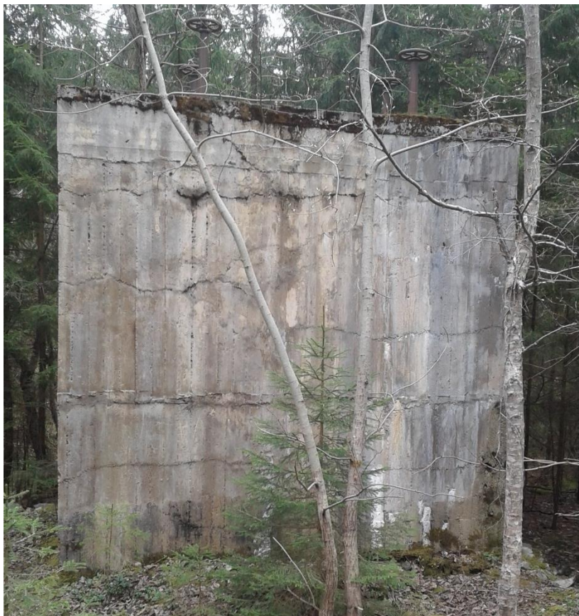
Figur 1-4. Ventilkammer sett fra skogsveien.
