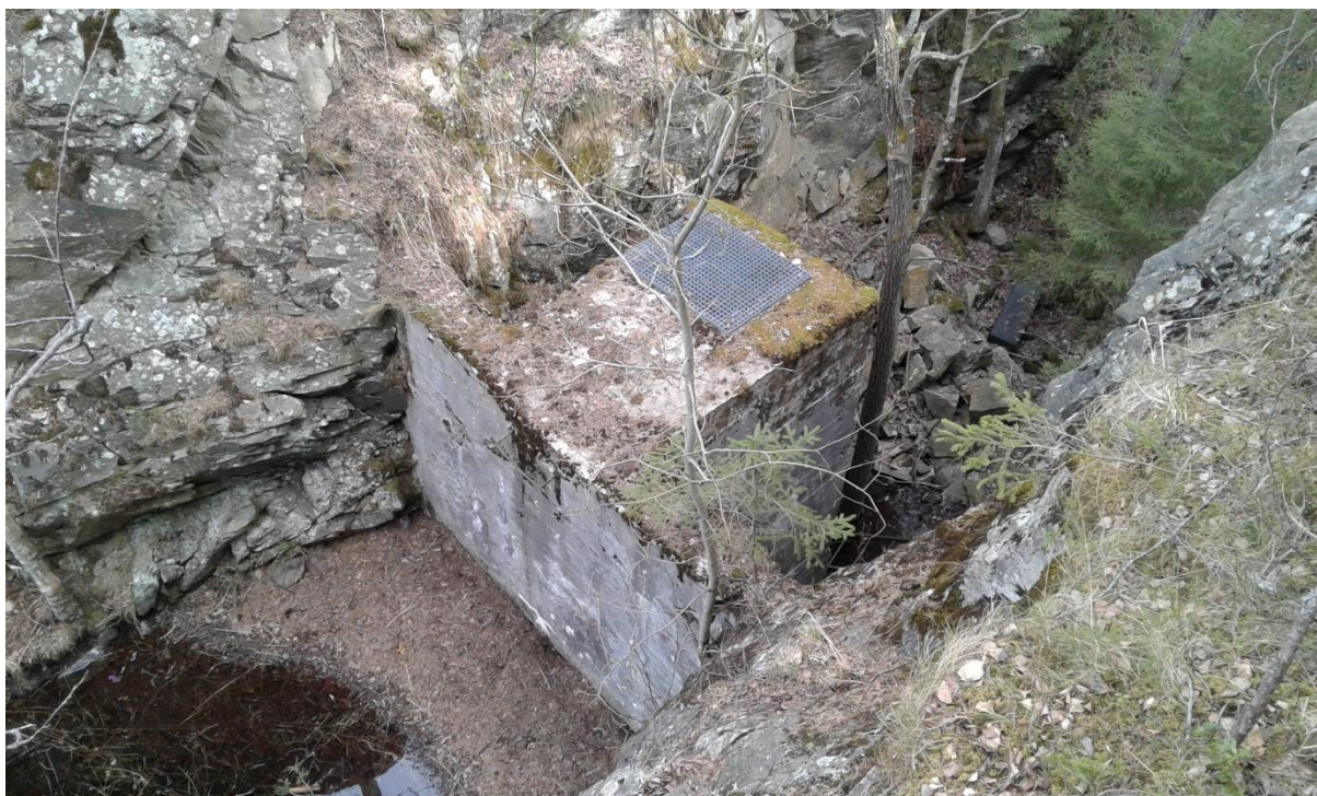
Figur 1-3. Ramstadsjøen sperredam sett fra høyre vederlager.
