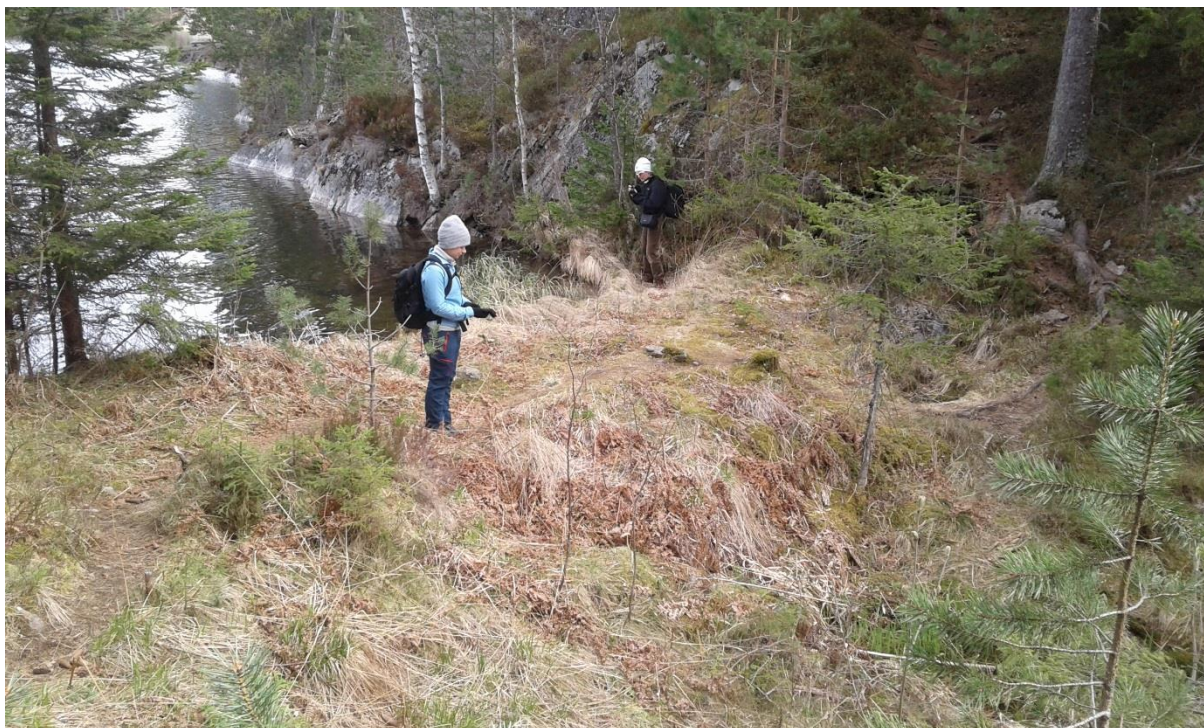
Figur 1-6. Ramstadsjøen sperredam 2 sett fra oppstrøms side.
