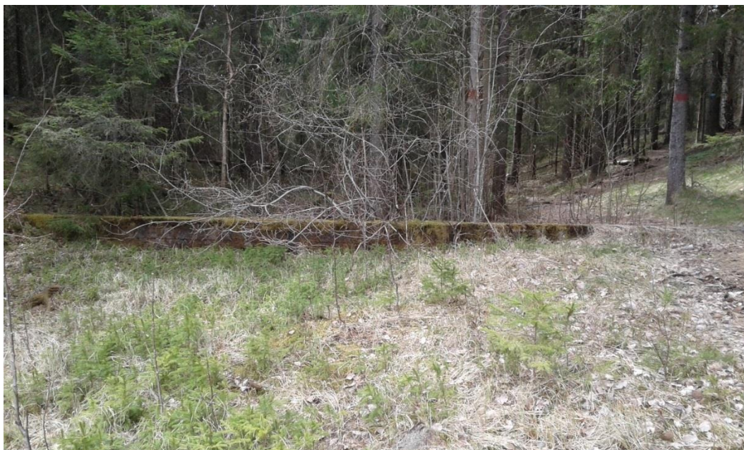
Figur 1-5. Åmoddammen, sperredam sør-vest, sett fra oppstrøms side.
