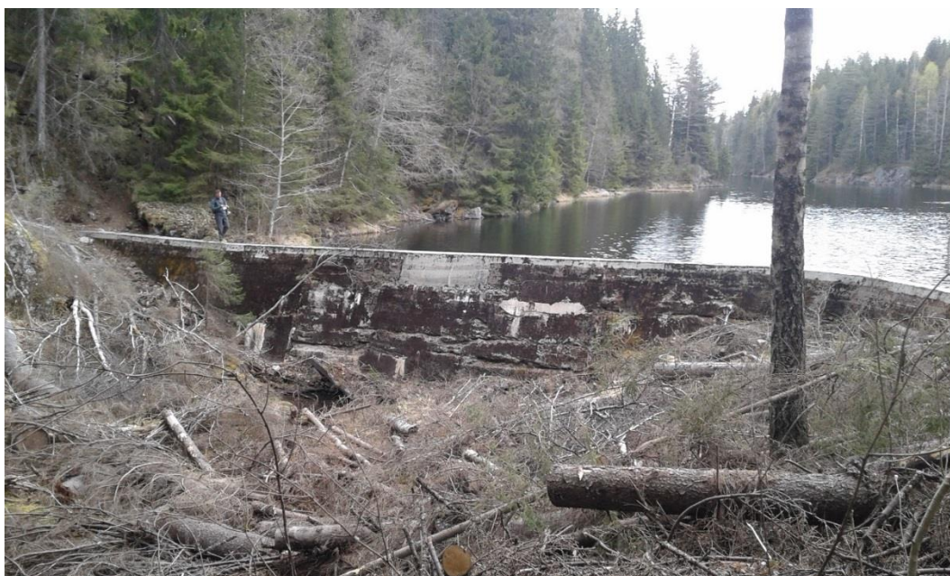
Figur 1-4. Åmodtdammen, sperredam vest, sett fra nedstrøms side.
