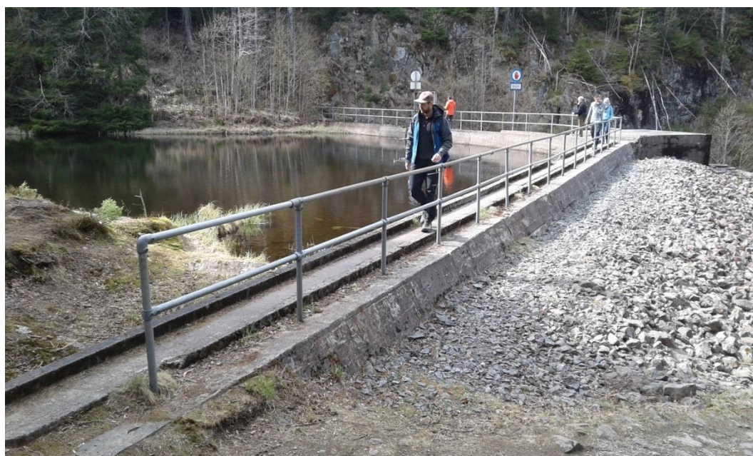
Figur 1-2. Åmodtdammen hoveddam, sett fra høyre vederlager.
