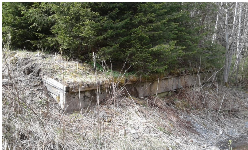
Figur 1-3. Bunker nedstrøms for dammen.
