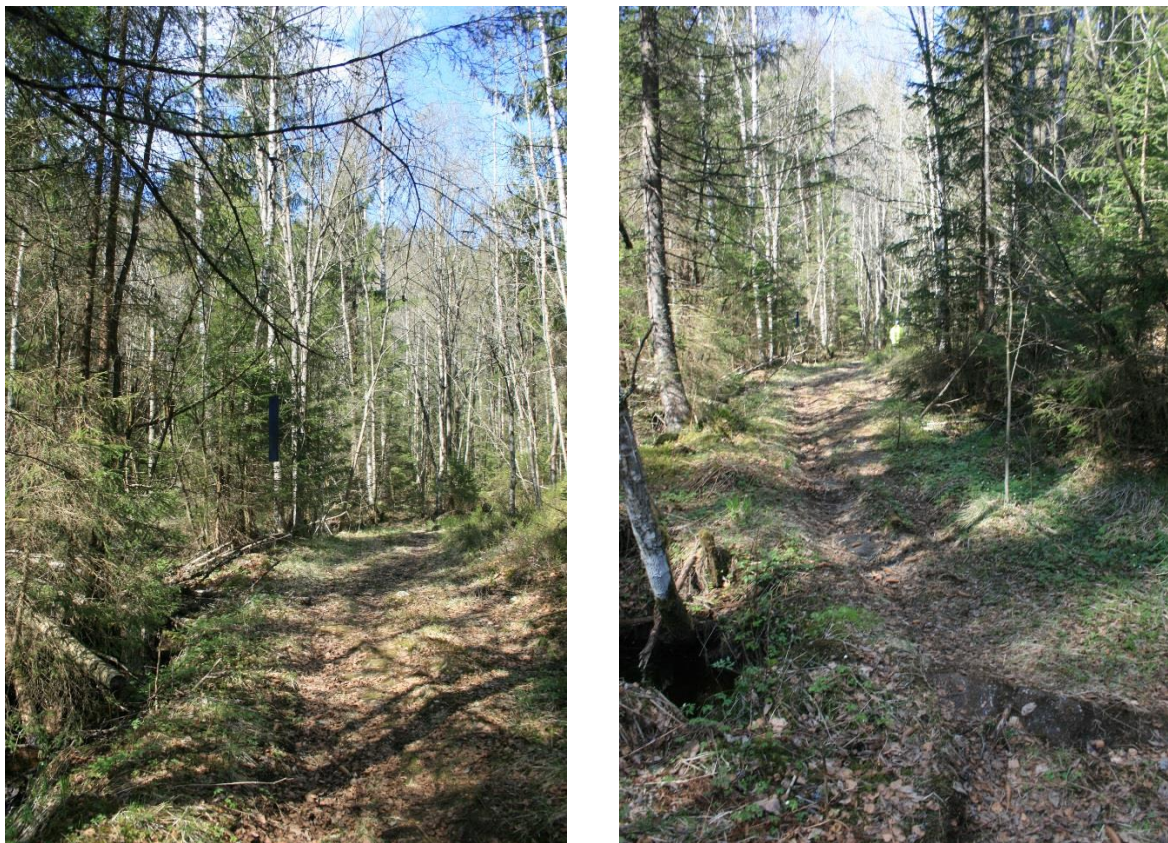
Figur 2-3. Gammel anleggsvei opp til Bæreggtjernet. Anleggsveien med bredde 2.5m etableres i samme trase.
