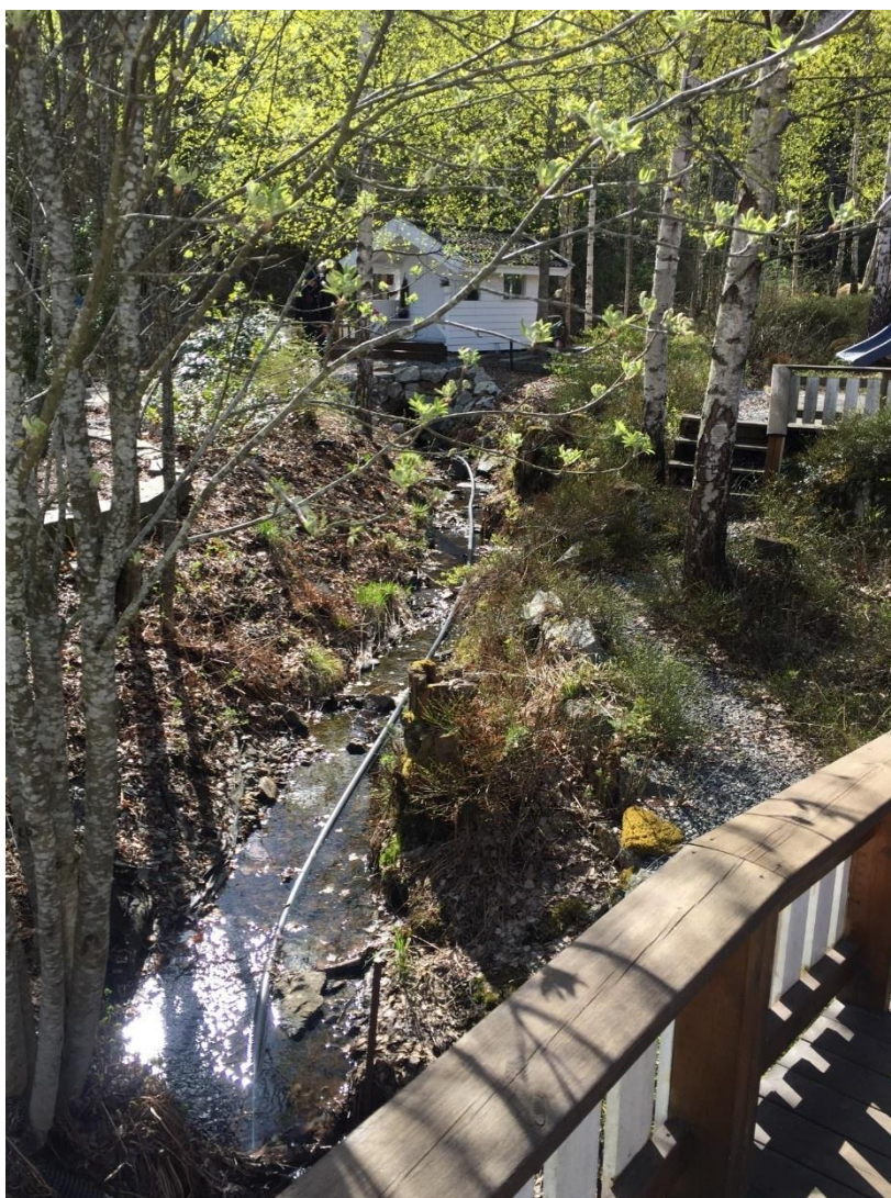
Figur 3-4 Bekk som renner nedstrøms dam, dette er et flomutsatt område (Bilde tatt under befaring 8. mai 2017).
