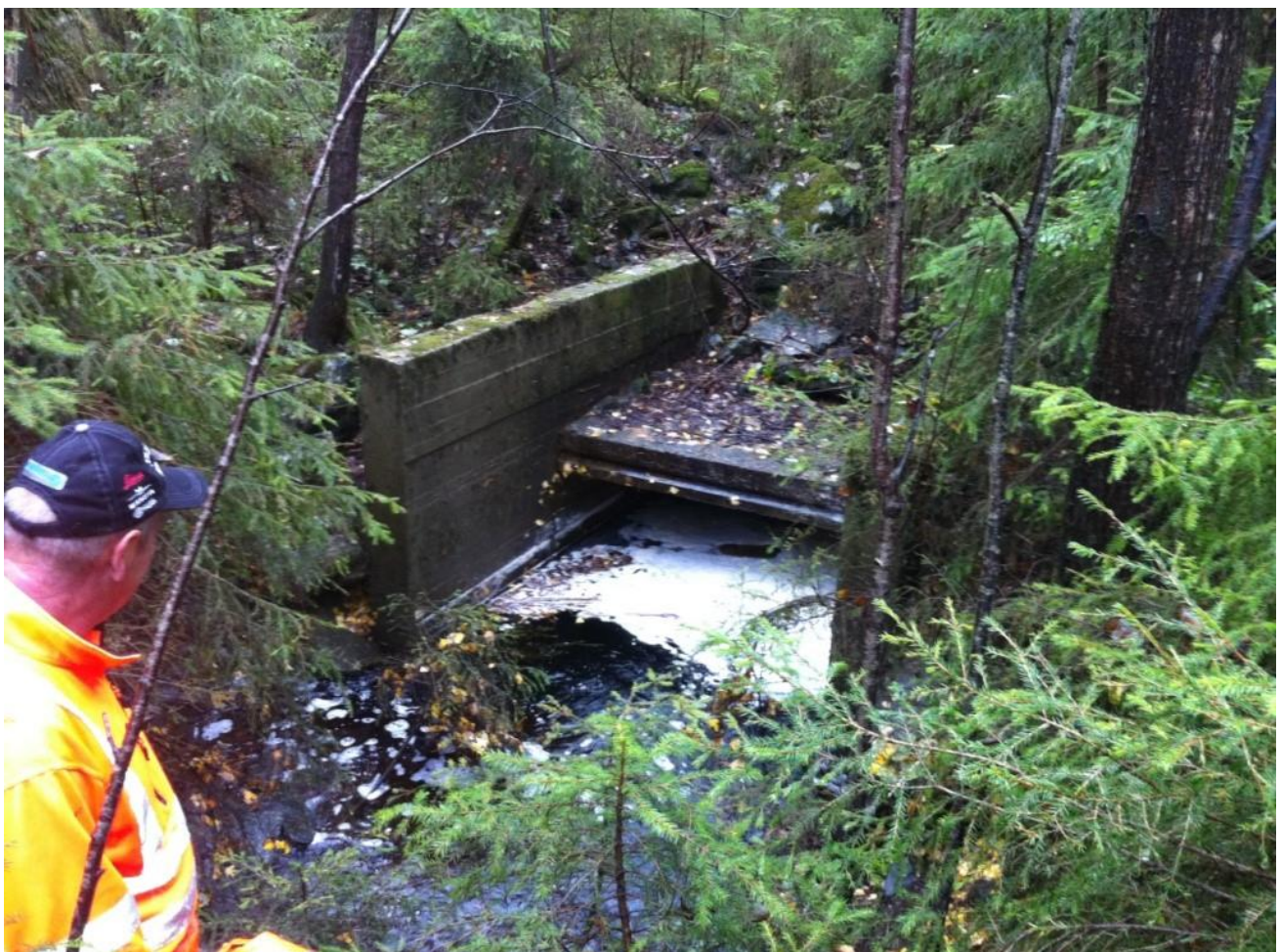
Foto 29. Situasjon ved kulverten i 2011 (Vassbygg).
