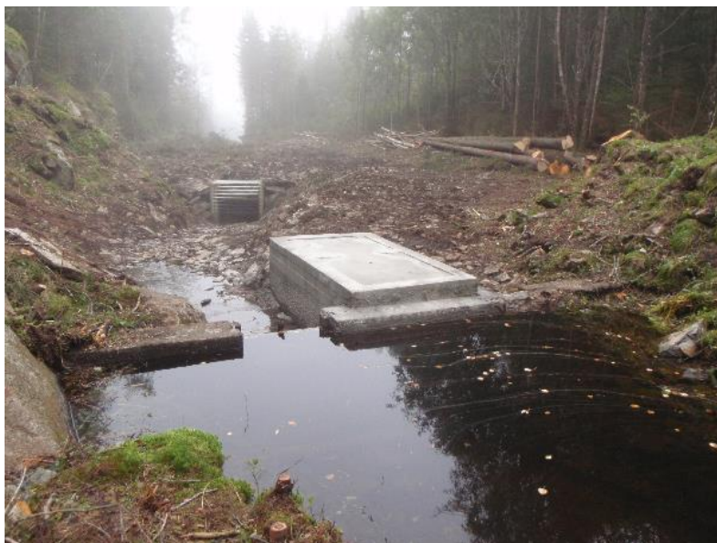
Figur 1-3. Situasjon ved dam og kulvert like etter tiltak (Foto: Øystein Nyengen 2013).
