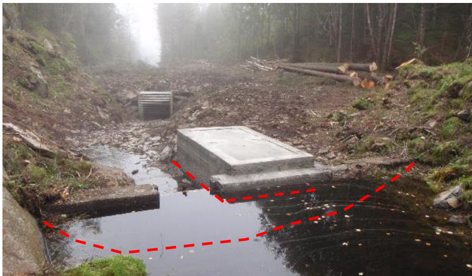
Figur 2-1. Illustrasjon av foreslått tiltak illustrerer antatte grenser for pigging av eksisterende konstruksjon..
