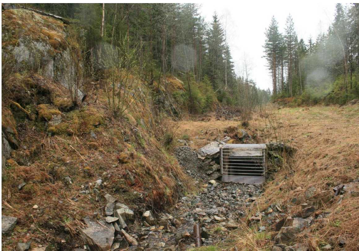
Figur 3-8. Situasjonen ved kulvert i 2017.
