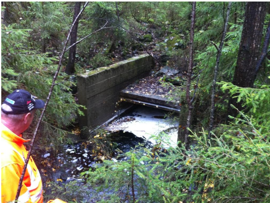
Figur 3-7. Situasjonen ved kulverten i 2011 (Vassbygg).
