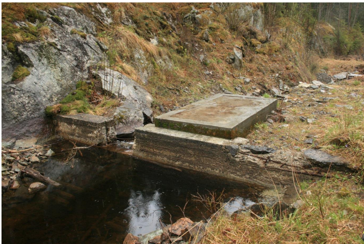
Figur 3-9. Situasjonen ved dammen i 2017.
