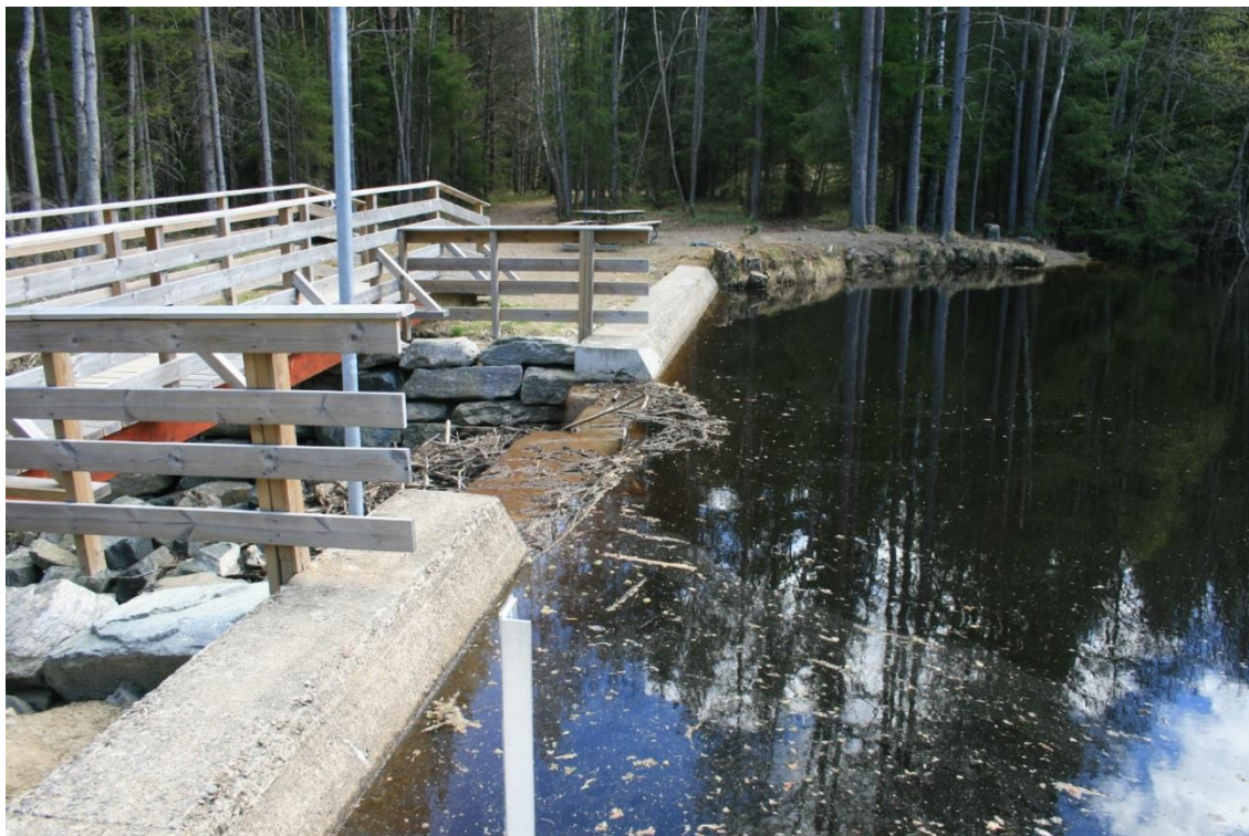
Figur 1-3. Senneruddammen sett fra vannsiden, flomløpet sikret med rekkeverk.
