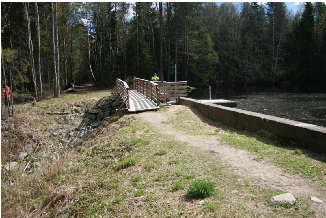
Figur 1-4. Senneruddammen med tappekummen på oppstrøms side, gangbru over utløpet, og nedstrøms støttefylling.
